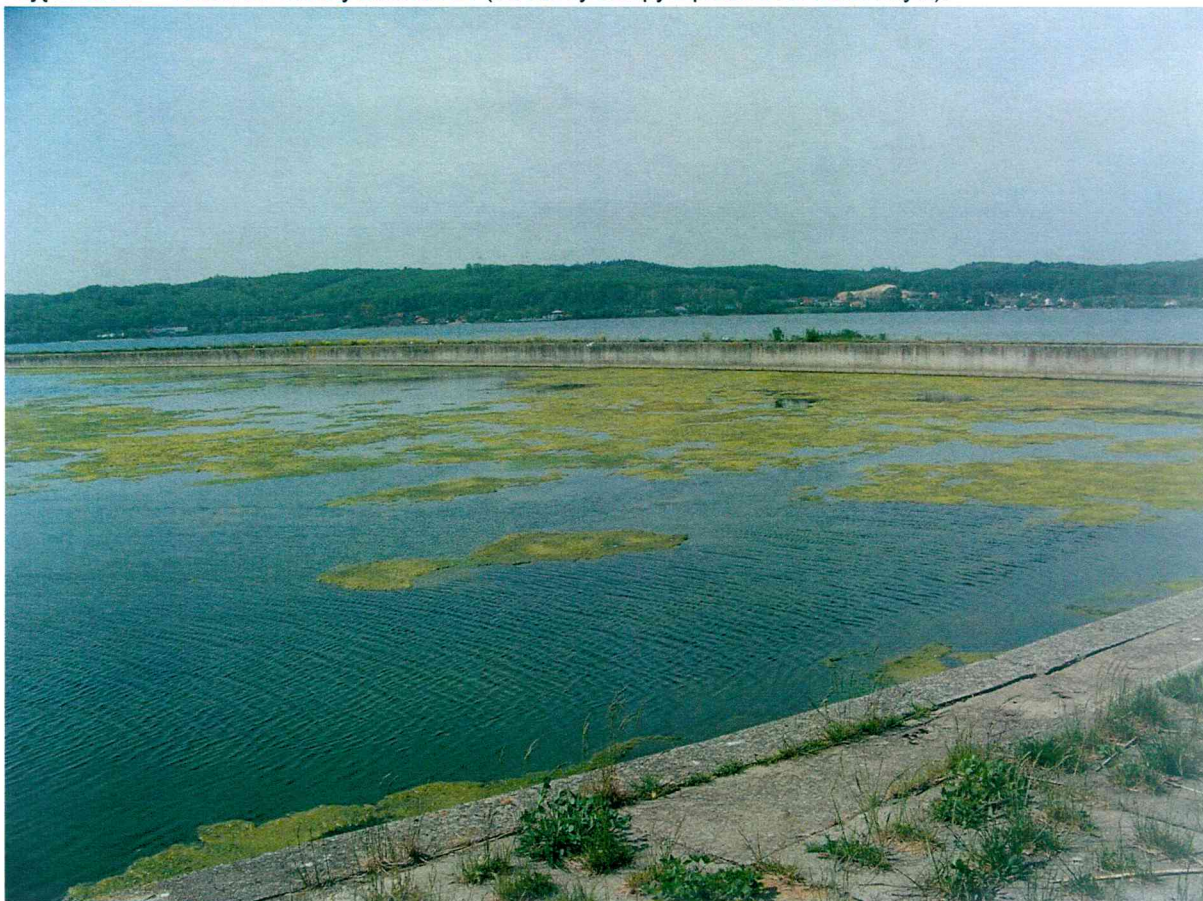
Zdjęcie nr7/2 – Widok na otwarty zbiornik Z1 (od strony skarpy z przelewem lewarowym).
