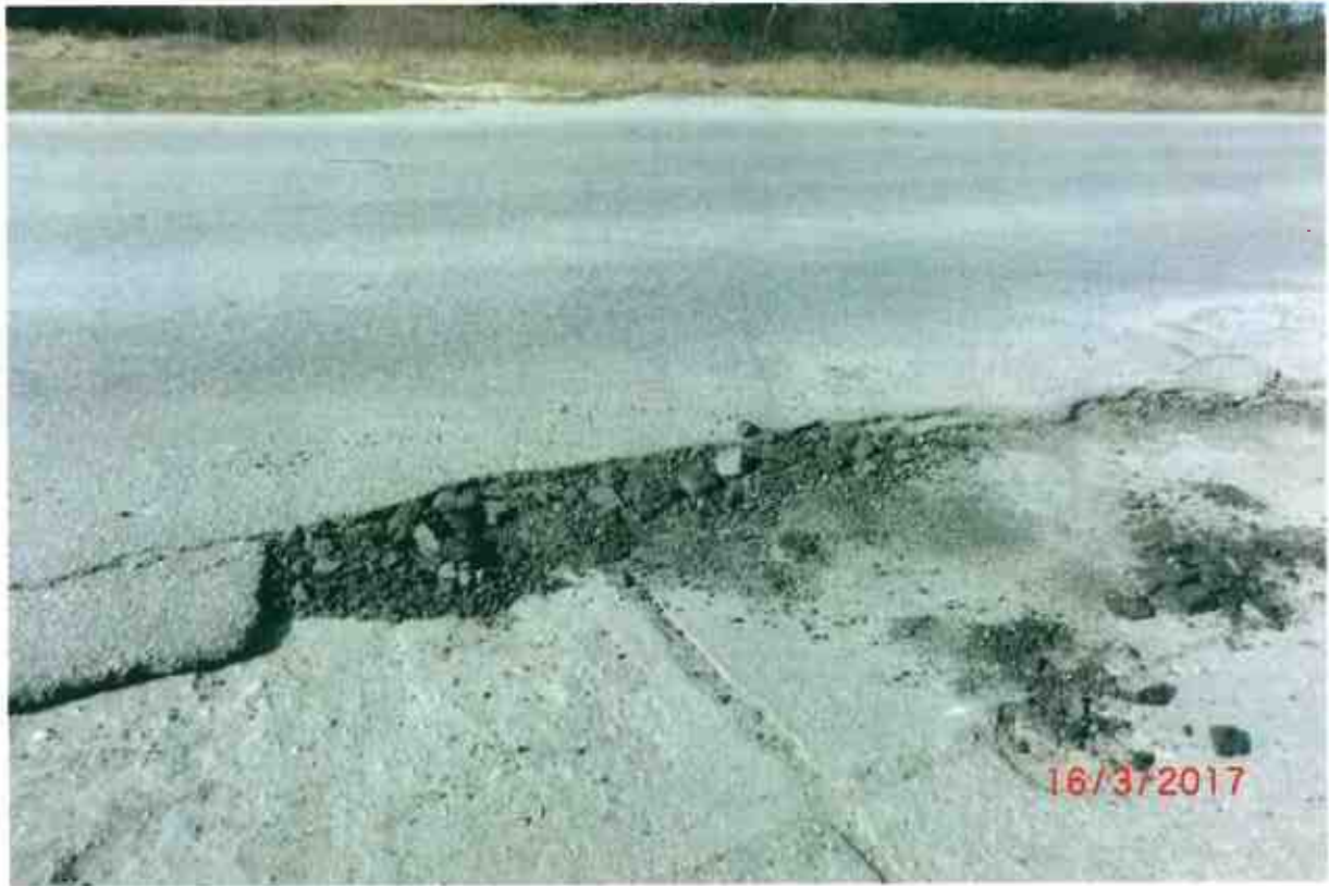
Zdjęcie nr 3 – Zjazd na ul. Torfową z ul. Spokojnej
