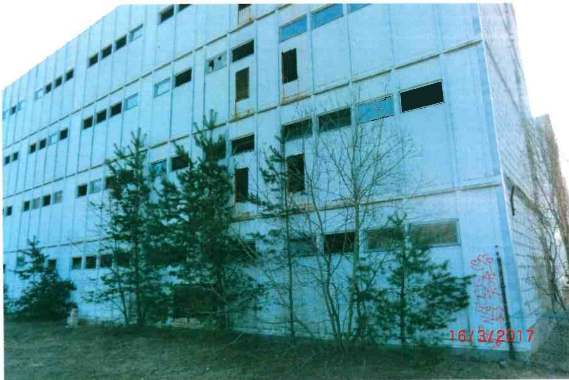
Rys. nr 2 Widok na budynek ZEW-67
