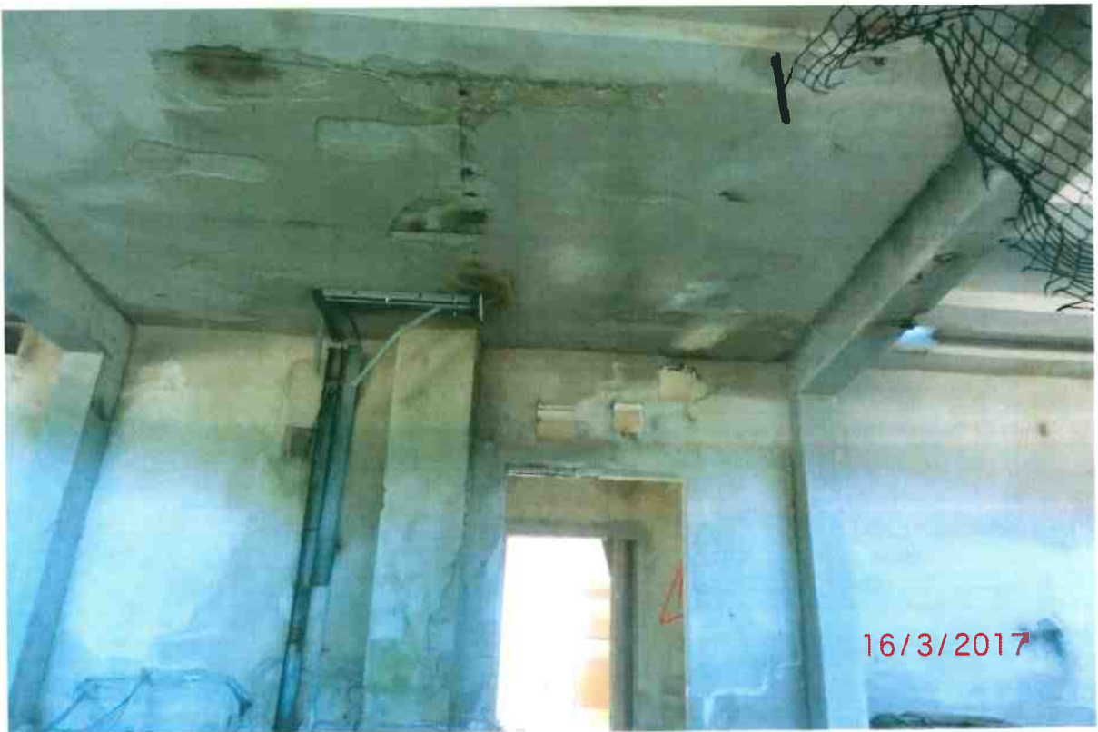
Rys. nr 8 - Stan budynku nr ZEW-67 wewnątrz.
