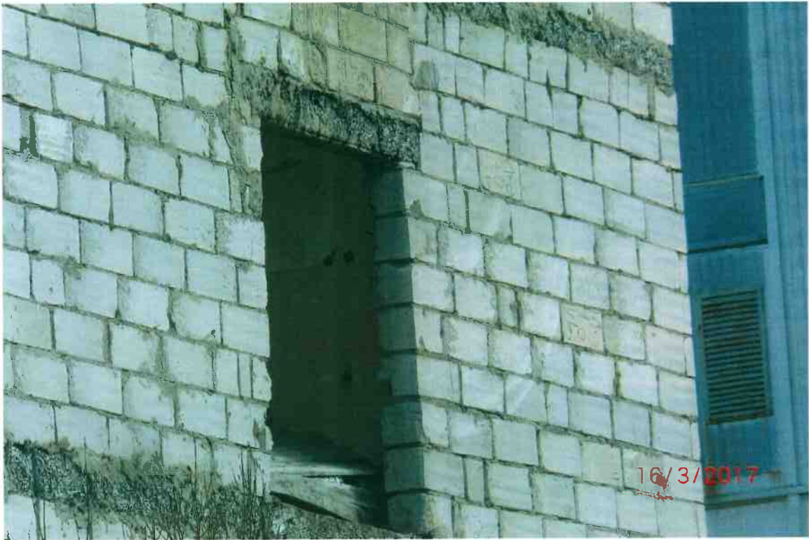
Rys. nr 3 - Widok na elewację szczytową budynku ZEW-67
