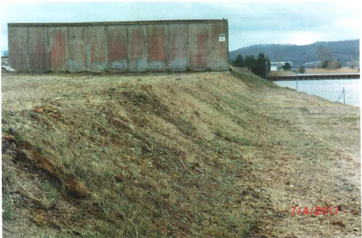
Zdjęcie nr7/3 – Widok na miejsce budowy ogrodzenia w kierunku Door-Pol
