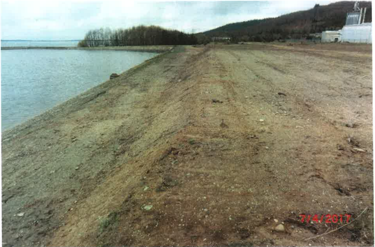
Zdjęcie nr5/2 – Widok na miejsce budowy ogrodzenia (górnny nasyp) - od strony Door-Pol
