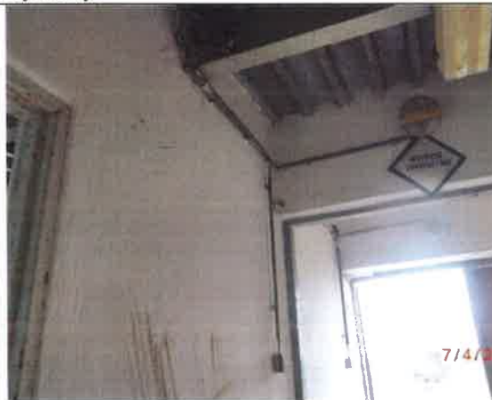
Fot. – 45 (Poziom +1.10) – malowanie ścian, naprawa i uzupełnienie oświetlenia.
