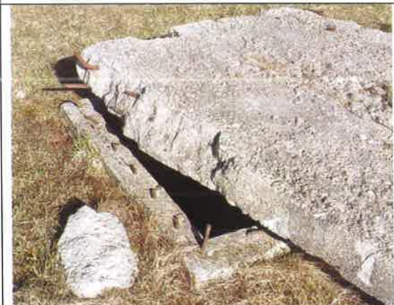
Fot. 24 – Wywiewczak zbiornika – do odtworzenia.
