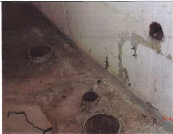
Fot. – 73 (Poziom -2.50) – Korytarz prowadzący do zbiorników – istn. otwory do zamurowania.
