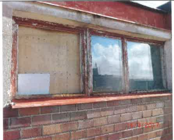
Fot. 38 – Okno do zamurowania luksferami.
