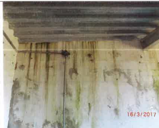
Fot. – 47 (Poziom +1.10) – malowanie ścian, usunięcie zbędnych instalacji, naprawa i uzupełnienie oświetlenia.
