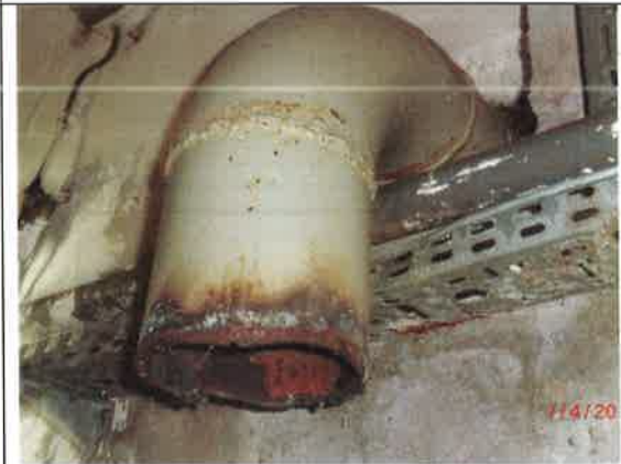
Fot. – 72 (Poziom -2.50) – Korytarz prowadzący do zbiorników – istn. rurociągi do demontażu; otwory do zamurowania.
