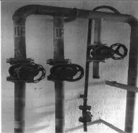
Fot. – 51 (Poziom +1.10) – rurociągi odwodnienia – do demontażu.
