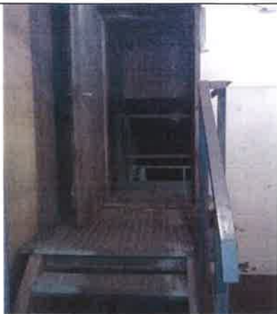
Fot. – 79 (Poziom -2.50) – Galeria – wejście do zbiorników wód opadowych.
