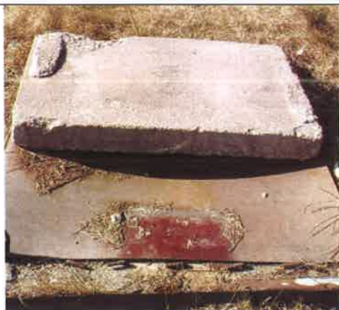
Fot. 23 – Wywiewczak zbiornika – do odtworzenia.
