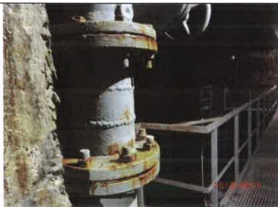
Fot. – 81 (Zbiorniki wody deszczowej) – rurociągi systemu płuczącego do demontażu i utylizacji.
