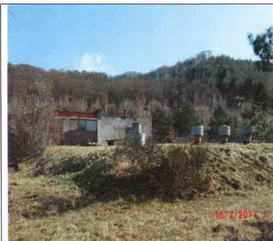
Fot. 1 (Teren) – widok na budynek F-13.
