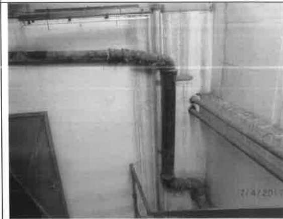
Fot. – 54 (Poziom +1.10) – klatka schodowa – ściany do pomalowania, rurociągi do odczyszczenia i oznakowania.
