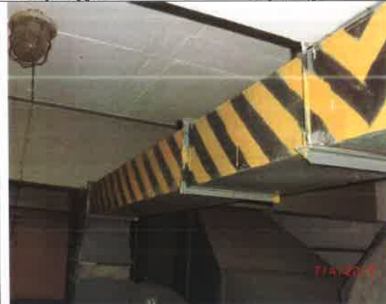
Fot. – 65 (Poziom -2.50) – pomieszczenie wentylatorowni i AKPiA – nieczynne kanały wentylacyjne – do demontażu i utylizacji.
