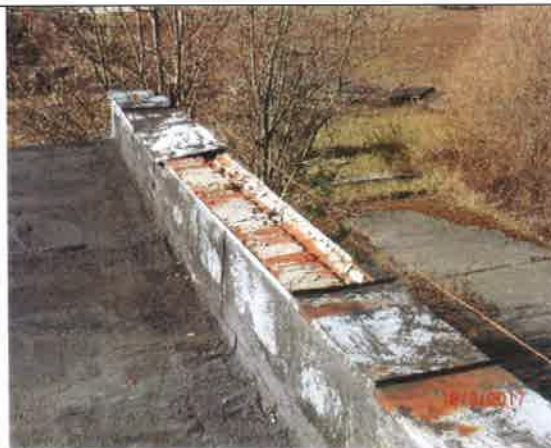
Fot. 39 – Murek ogniochronny do naprawy i zabezpieczenia blachą ocynkowaną.
