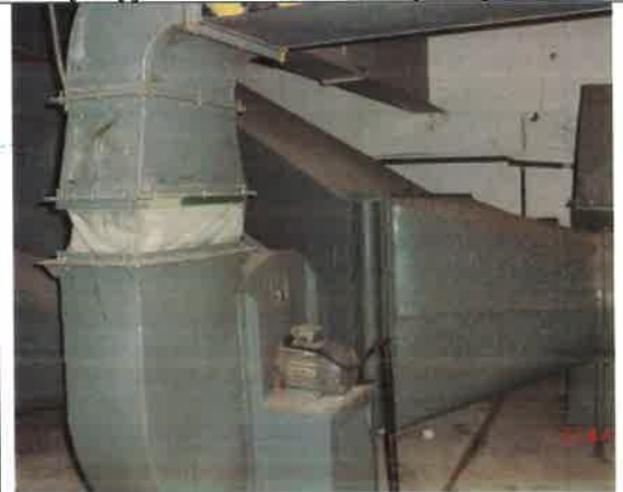
Fot. – 64 (Poziom -2.50) – pomieszczenie wentylatorowni i AKPiA – nieczynne kanały wentylacyjne – do demontażu i utylizacji.
