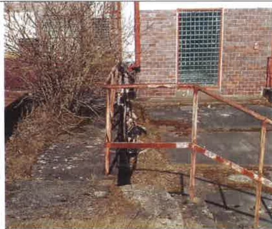
Fot. 33 – Balustrada do demontażu. Schody do odczyszczenia, poręcz do odczyszczenia i pomalowania.
