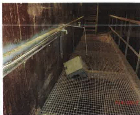
Fot. – 84 (Zbiorniki wody deszczowej) – istn. rurociągi wody do demontażu i utylizacji.
