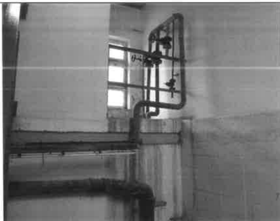
Fot. – 53 (Poziom +1.10) – klatka schodowa – ściany do pomalowania, rurociągi odwodnienia – do demontażu.
