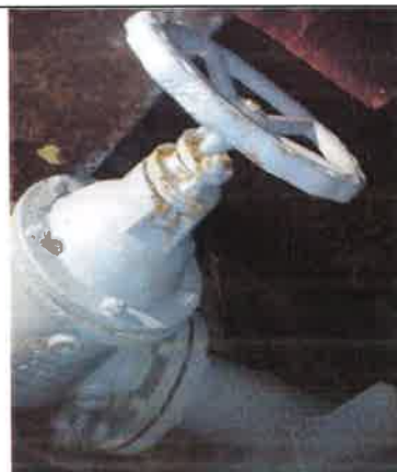
Fot. – 82 (Zbiorniki wody deszczowej) – rurociągi systemu płuczącego do demontażu i utylizacji.
