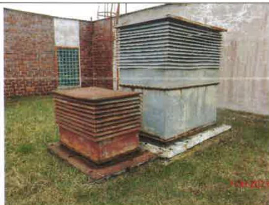
Fot. 29 – Czerpnia wentylacyjna – do likwidacji. Otwory po czerpni do trwałego zabezpieczenia.
