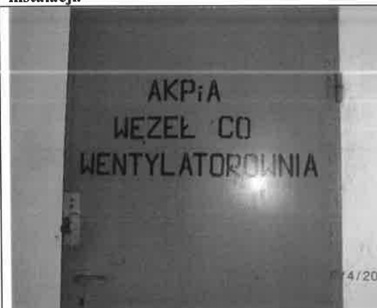
Fot. – 60 (Poziom -2.50) – pomieszczenie wentylatorowni i AKPiA.
