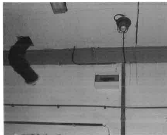
Fot. – 58 (Poziom -2.50) – demontaż zbędnych instalacji.
