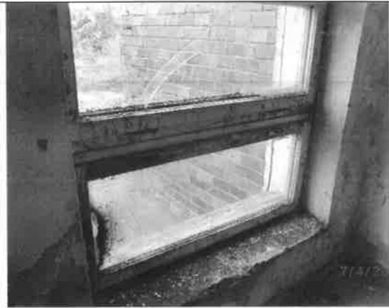
Fot. – 50 (Poziom +1.10) – demontaż stolarki okiennej, zabudowa otworu okiennego luksferami.
