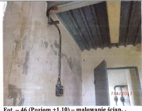
Fot. – 46 (Poziom +1.10) – malowanie ścian, usunięcie zbędnej instalacji sterowania wentylacją mechaniczną. Naprawa i uzupełnienie oświetlenia.
