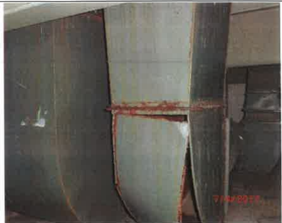
Fot. – 62 (Poziom -2.50) – pomieszczenie wentylatorowni i AKPiA – nieczynne kanały wentylacyjne – do demontażu i utylizacji.
