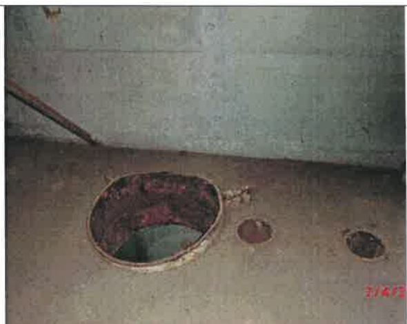
Fot. – 95 (Poziom -6.10) – otwory do zamurowania i trwałego zabezpieczenia.
