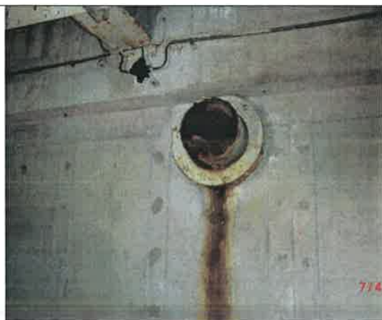
Fot. – 99 (Poziom -6.10) – otwory do zamurowania i trwałego zabezpieczenia.
