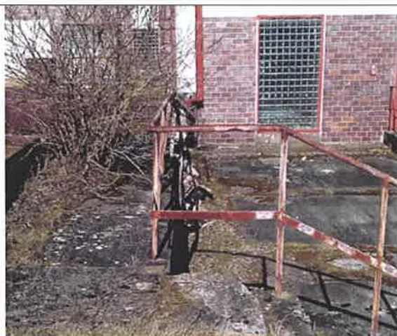
Fot. 23 – Balustrada do demontażu.
