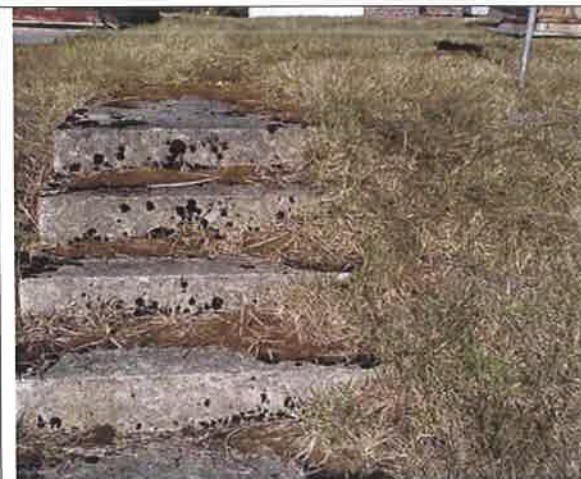
Fot. 24 – schody zewnętrzne do oczyszczenia.
