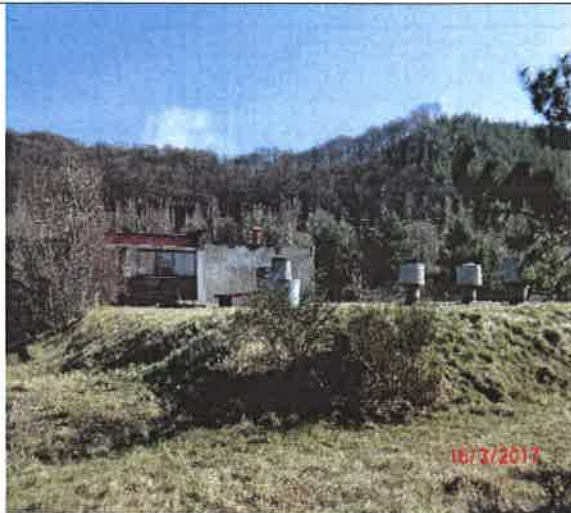
Fot. 1 – widok na budynek F-13.
