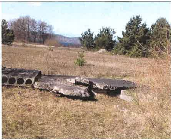
Fot. 9 – przykrycie kanału technologicznego – do naprawy.
