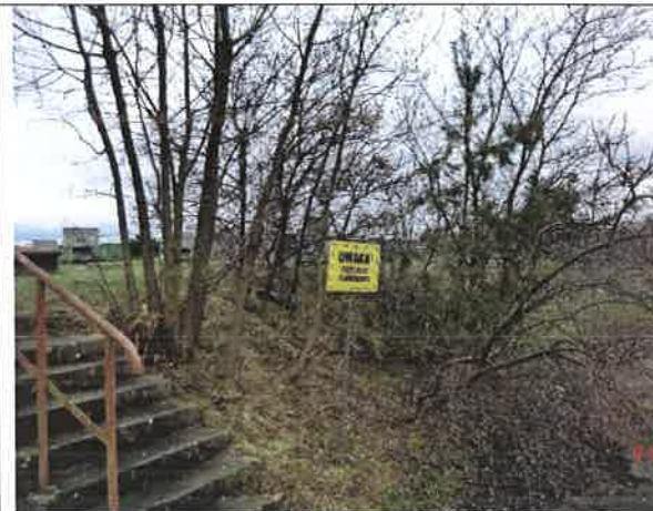
Fot. 4 – wejście do budynku F-13. Drzewa i krzewy do wycięcia.
