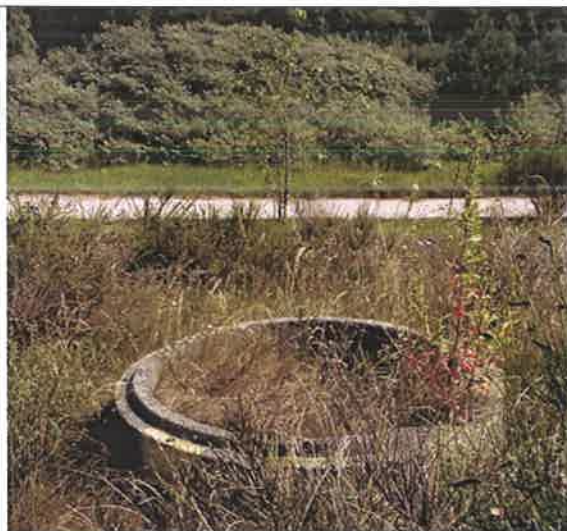
Fot. 17 – Istniejąca studzienka kanalizacyjna (ozn. Ks 1 na planie sytuacyjnym), do przykrycia i zabezpieczenia.
