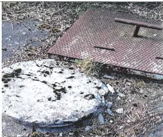
Fot. 13 – Pokrywa wjazdu – do wymiany.
