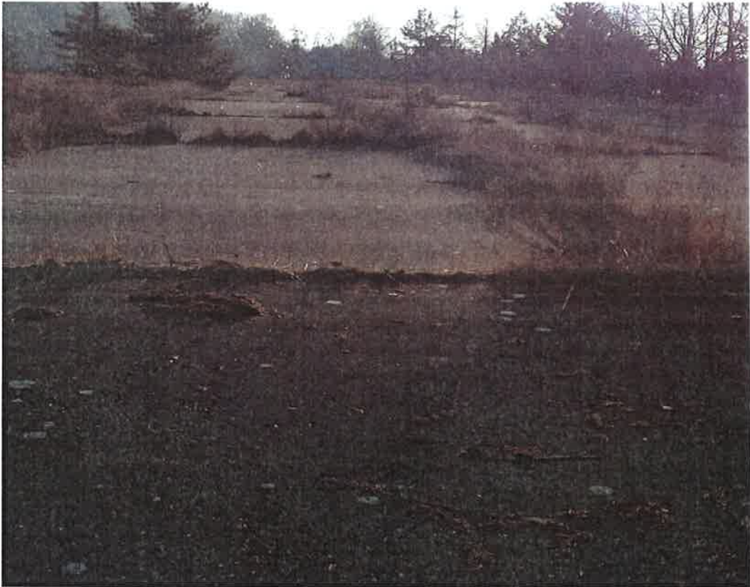
Foto 6.1 – Widok placu na działce 198/27 od strony ul. Widokowej.
