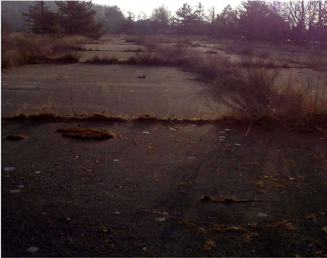
Foto 4.1 – Widok placu na działce 198/27 od strony ul. Widokowej.
