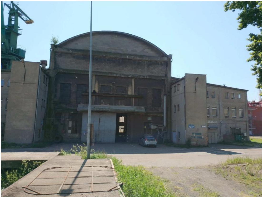
Fot.2 Elewacja północna
