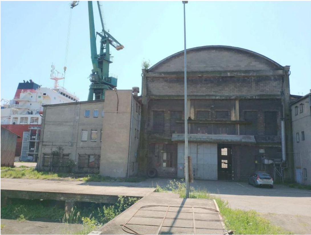
Fot.1 Elewacja północna
