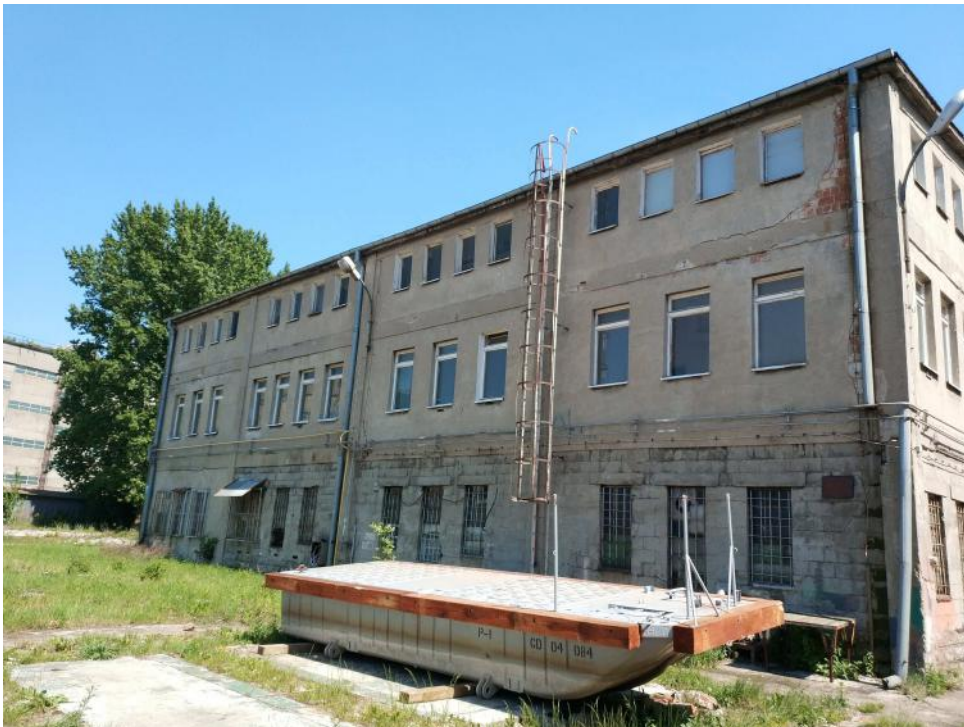
Fot.3 Elewacja zachodnia
