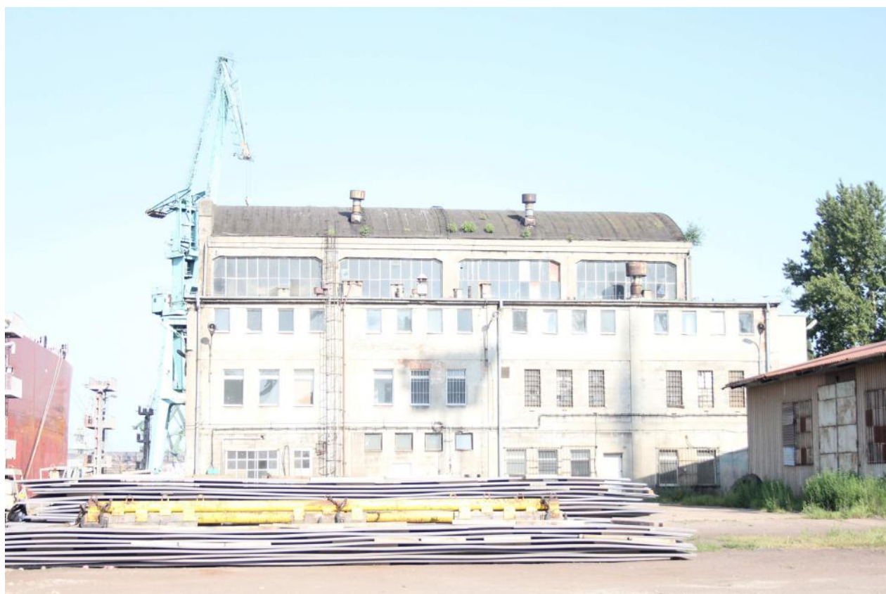
Fot. 8 elewacja wschodnia
