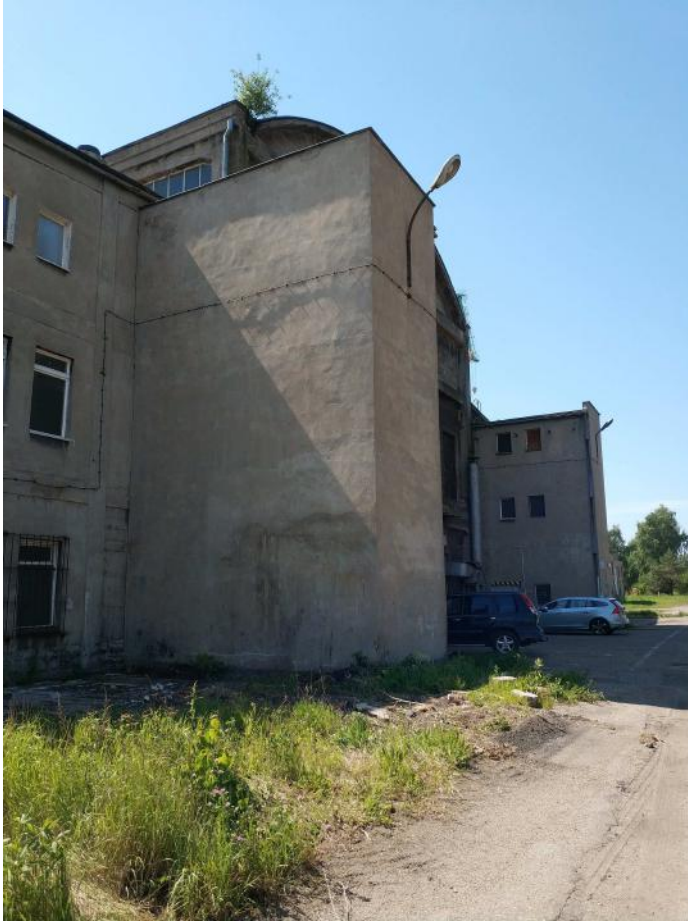
Fot.3 Elewacja wschodnia
