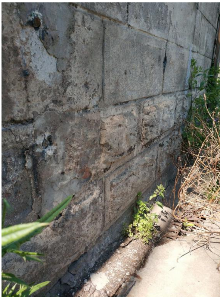
Fot. 5 strefa cokołu
