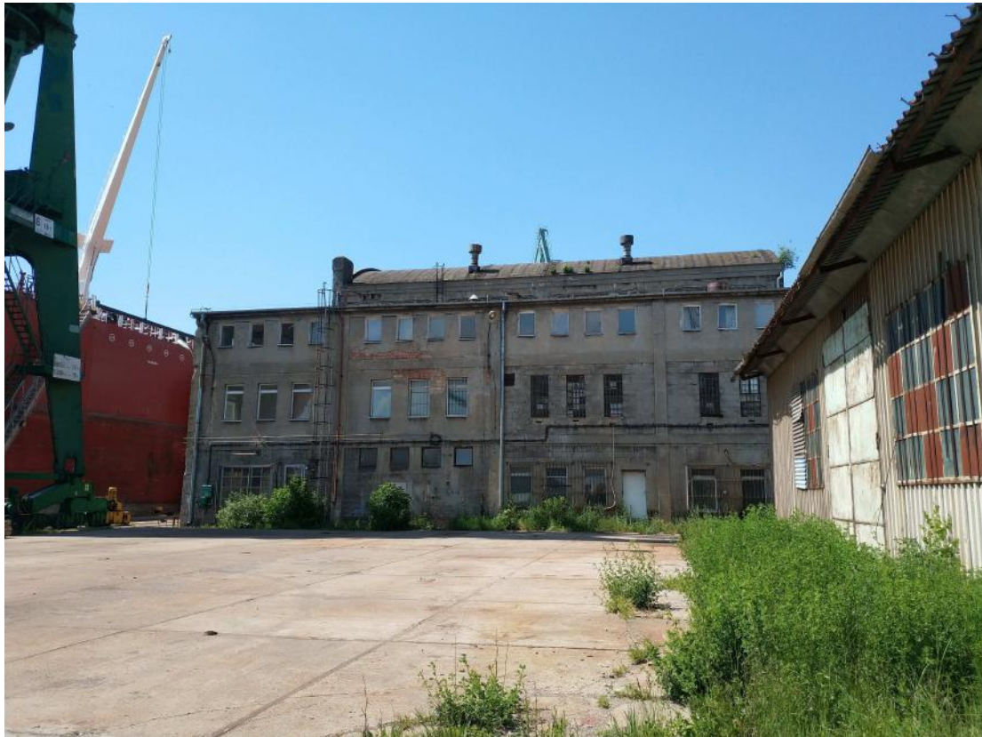
Fot.3 Elewacja wschodnia
