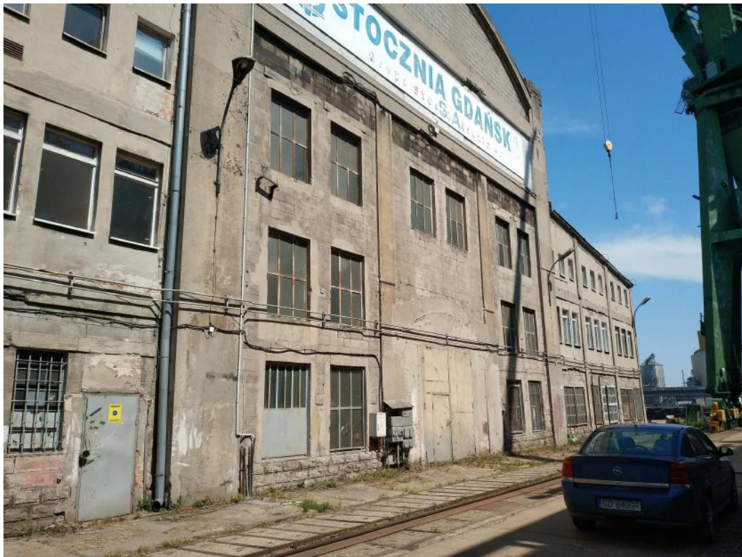
Fot.4 Elewacja południowa
