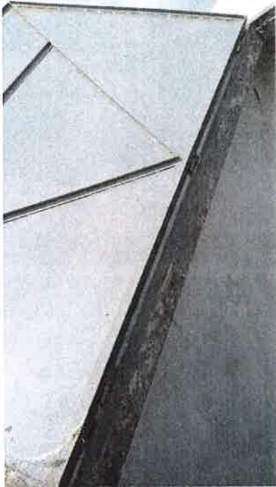
5/ZR2 – komora pomp – skrzydło wjazdu do komory pomp
