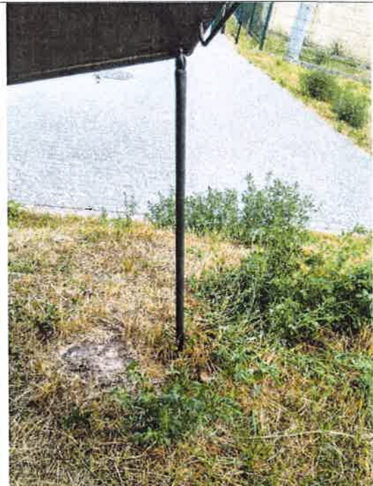
10/ZR1 – podparcie wjazdu do komory pomp
