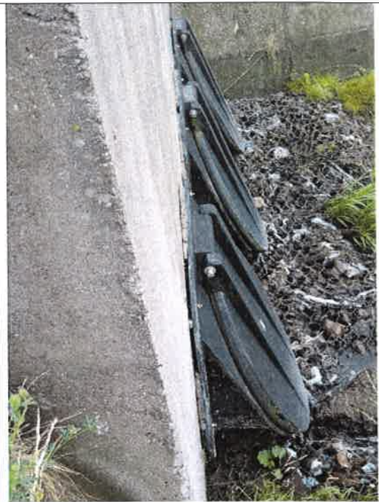
26/ZR1 – klapy zwrotne na wylotach kolektorów do rowu
