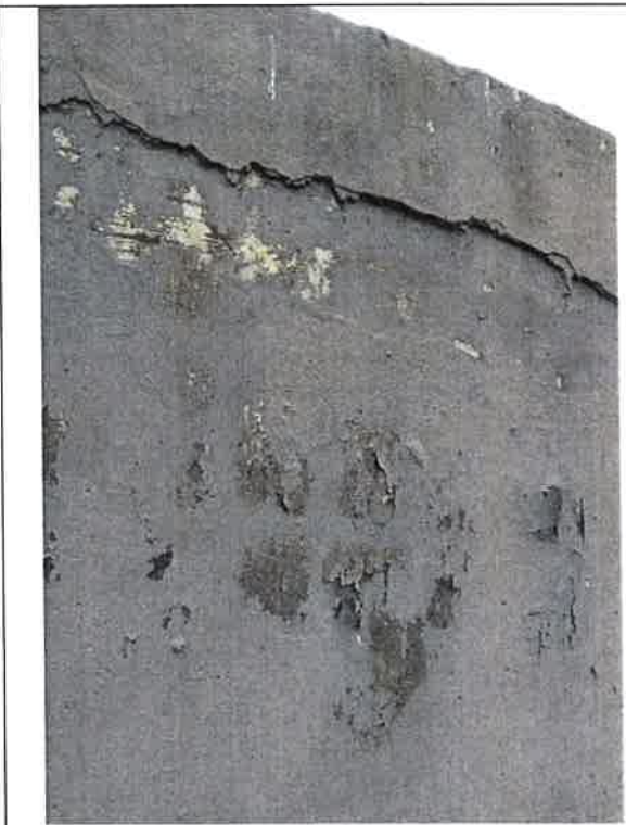
24/ZR1 – obudowa komory separatora
