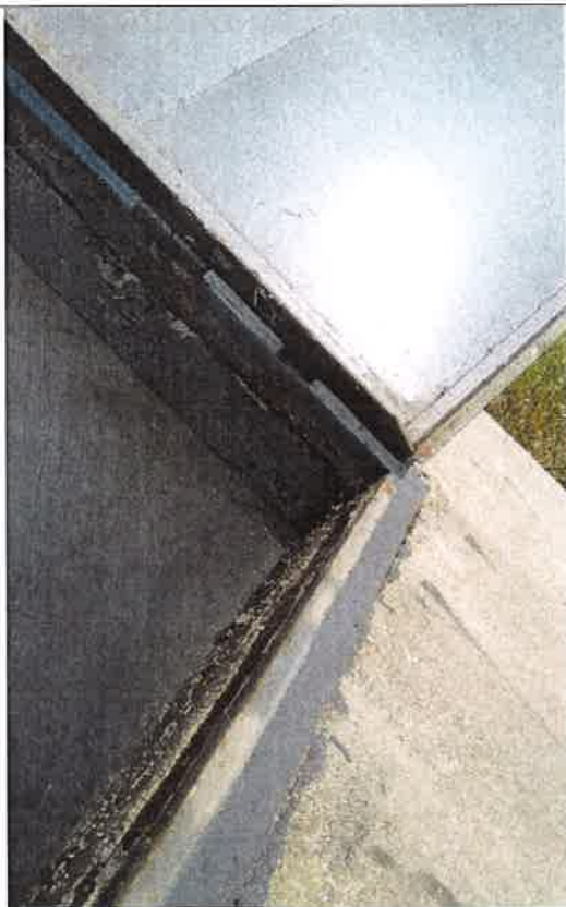
9/ZR2 – komora pomp – rama wjazdu do komory pomp
