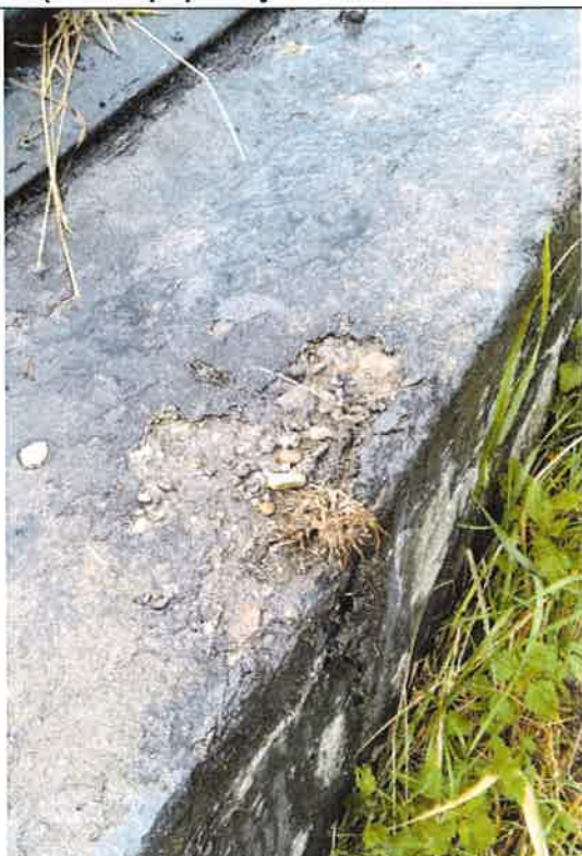
19/ZR1 – obudowa komory separatora
