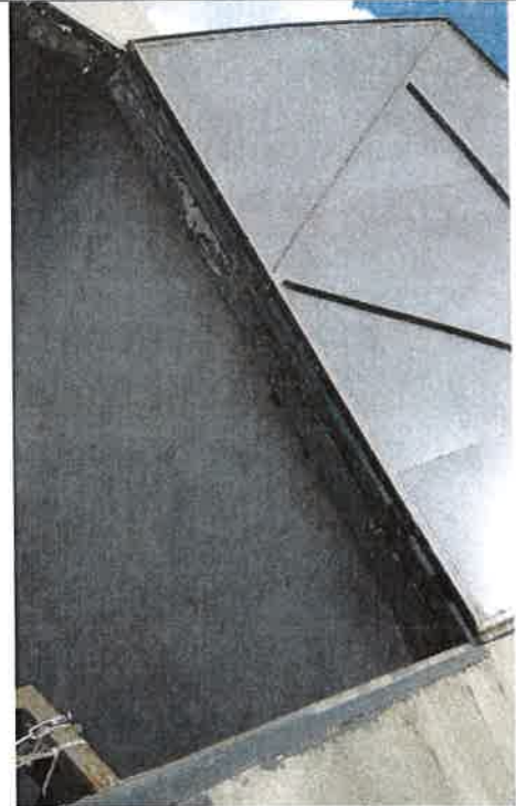
6/ZR2 – komora pomp – skrzydło wjazdu do komory pomp
