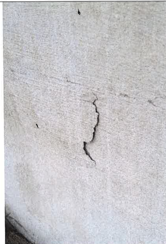
12/ZR2 – obudowa komory pomp
