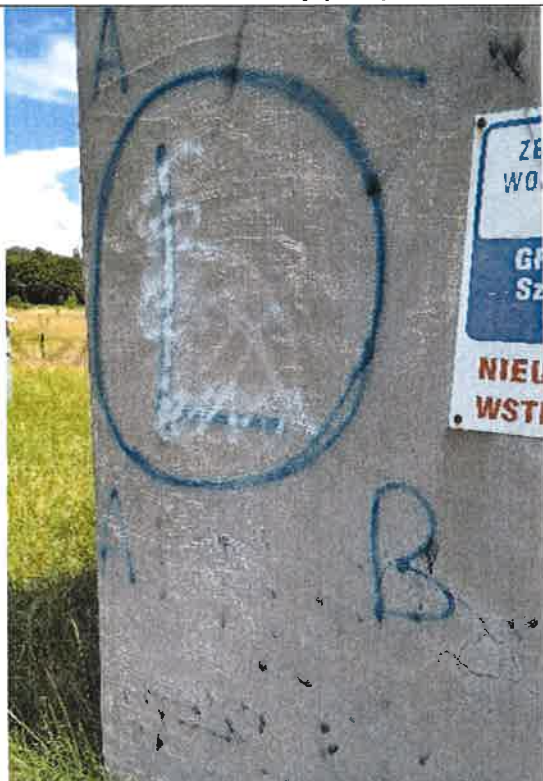
15/ZR2 – obudowa komory pomp
