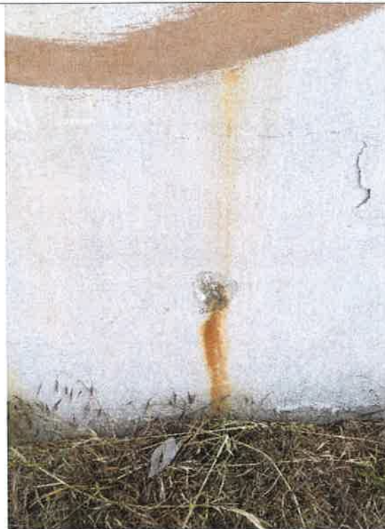
14/ZR2 – obudowa komory pomp
