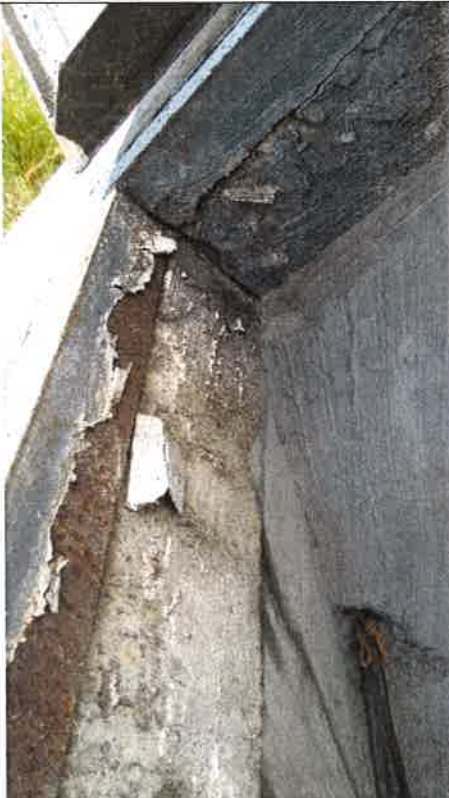
7/ZR2 – komora pomp – rama wjazdu do komory pomp
