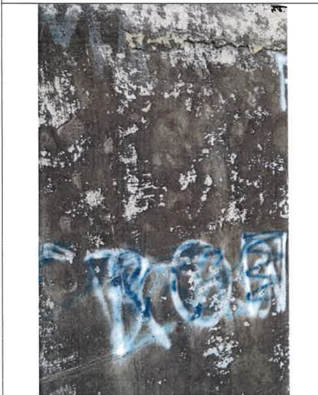
7/ZR1 – obudowa komory pomp
