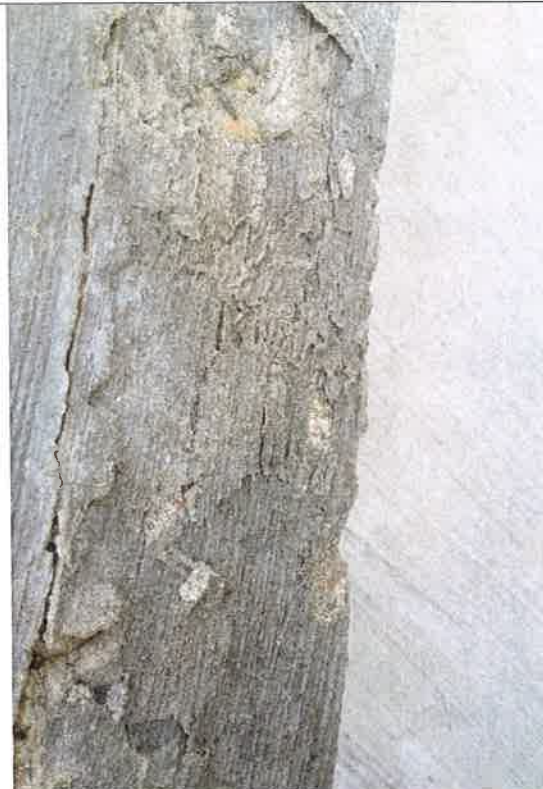
10/ZR2 – komora pomp – obudowa ramy wjazdu do komory pomp
