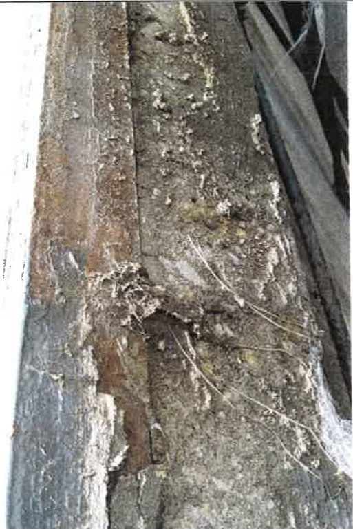
8/ZR2 – komora pomp – rama wjazdu do komory pomp /ZR1 – komora pomp
