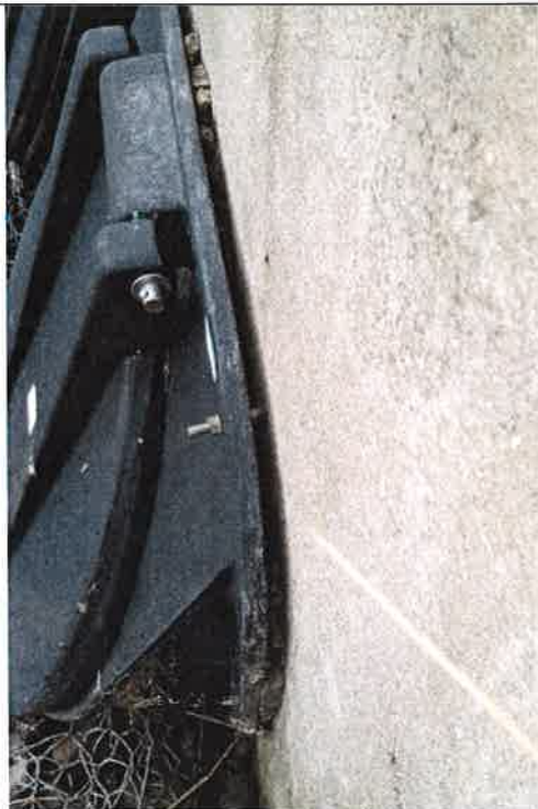
27/ZR1 – klapy zwrotne na wylotach kolektorów do rowu
