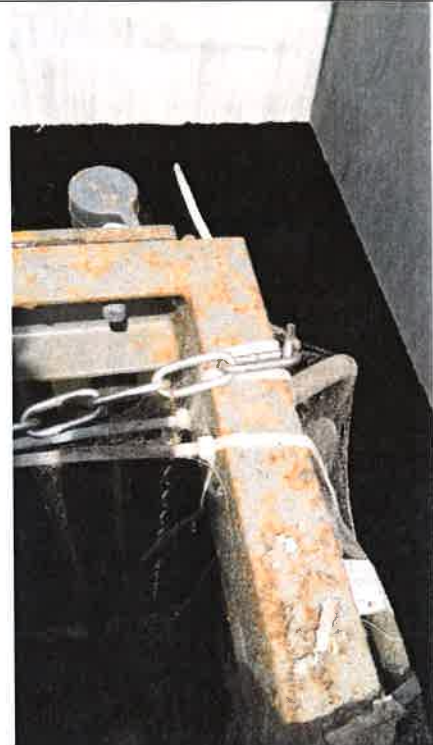
4/ZR2 – komora pomp – konstrukcja przewodnic pomp
