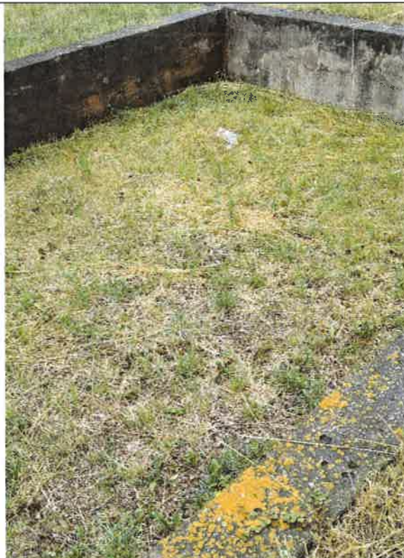
15/ZR1 – poletko ociekowe do odsączania popłuczyn.
