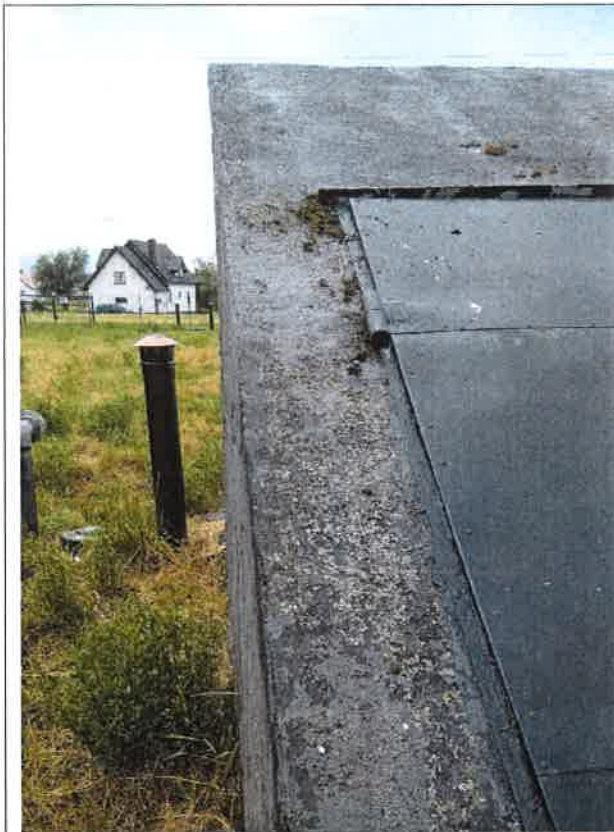
21/ZR1 – obudowa komory separatora
