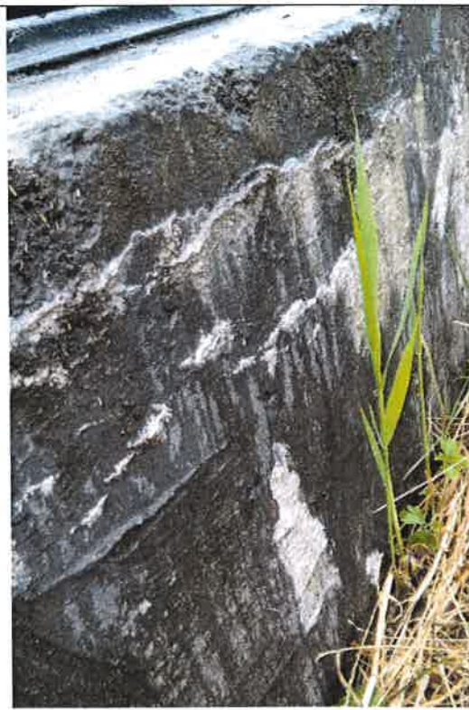
20/ZR1 – obudowa komory separatora
