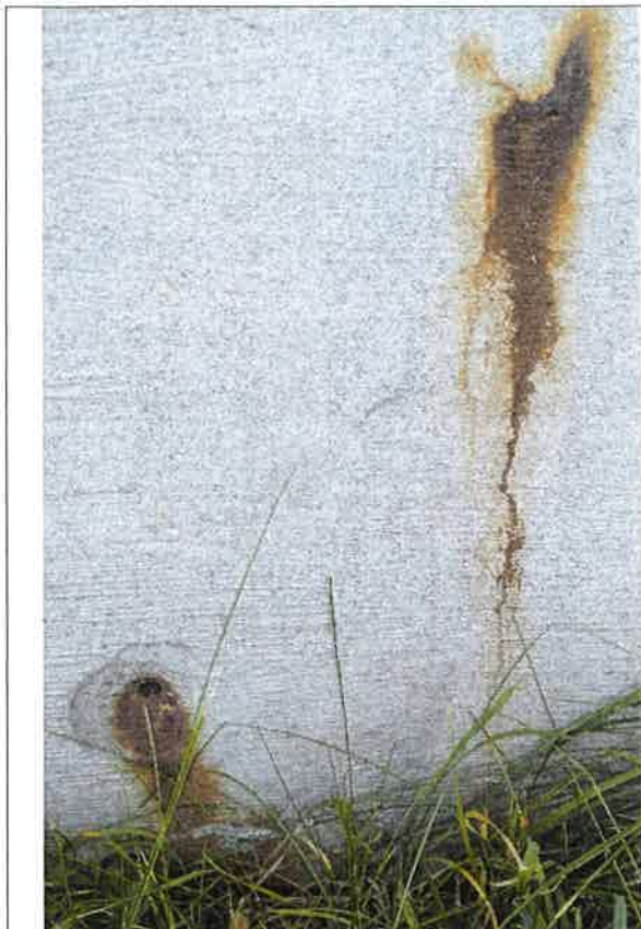
13/ZR2 – obudowa komory pomp
