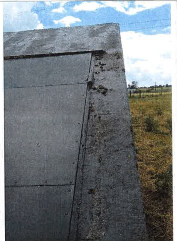
22/ZR1 – obudowa komory separatora
