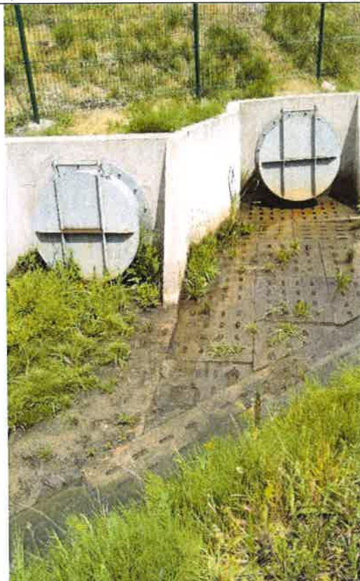
20/ZR2 – klapy zwrotne na wylotach kolektorów do rowu.
