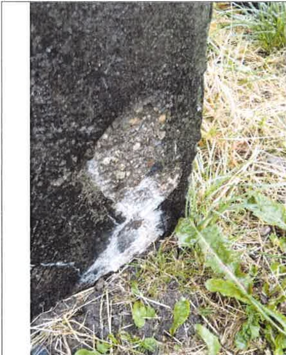
9/ZR1 – obudowa komory pomp
