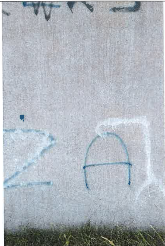
16/ZR2 – obudowa komory pomp
