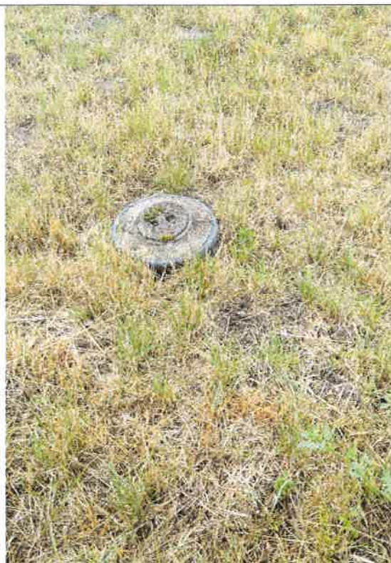
13/ZR1 – zasuwa do instalacji płuczącej osadnika.
