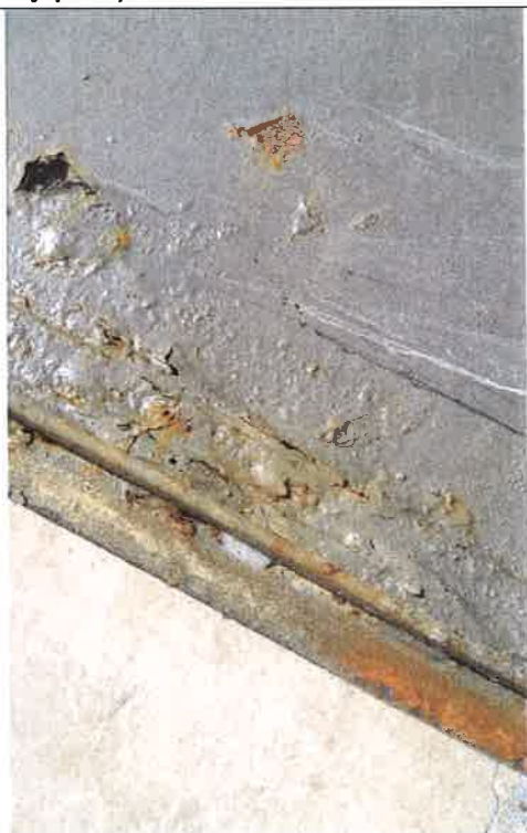
11/ZR2 – komora pomp – rama wjazdu do komory pomp
