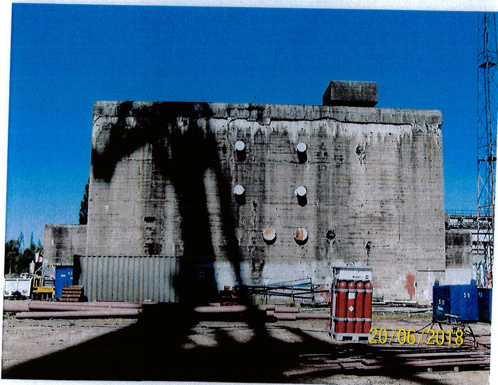
Fot. 2 – Elewacja Pd. – Wsch.
