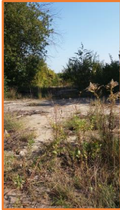
Fundamenty po budynkach 124,125,126
