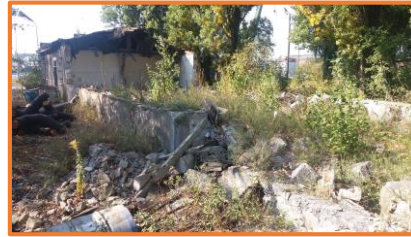
Fundamenty po budynku 119
