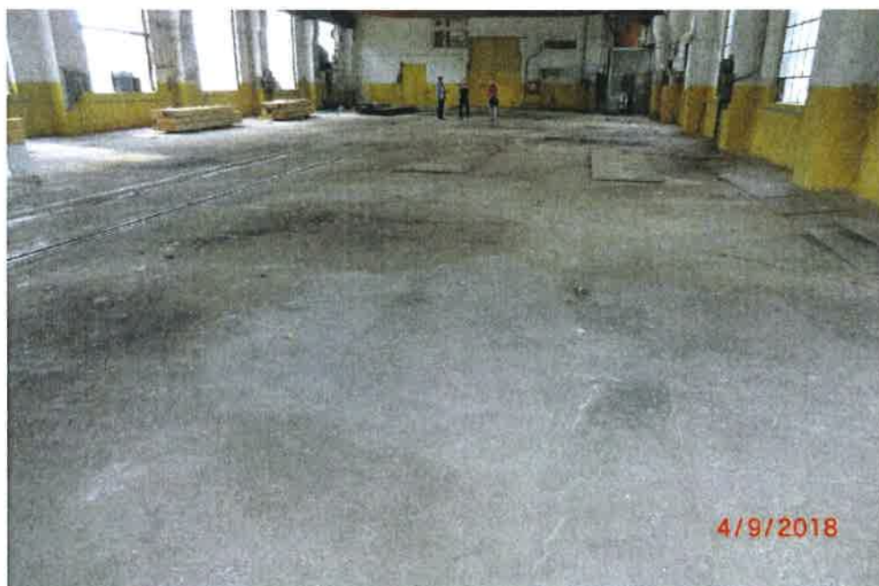
Rys. 4 Widok hali w kierunku bramy między budynkami nr 87 i nr 88.
