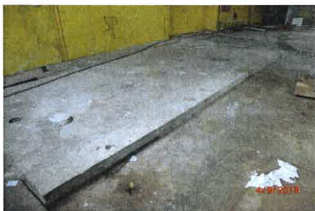
Rys. 8 i Rys. 9 Przykładowy fundament pod maszynę przewidziany do rozkucia.
