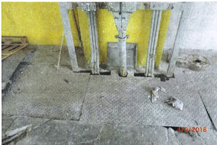
Rys. 7 Przykładowe przejście instalacji przez pokrywy kanału technicznego.
