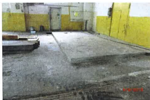
Rys. 8 i Rys. 9 Przykładowy fundament pod maszynę przewidziany do rozkucia.
