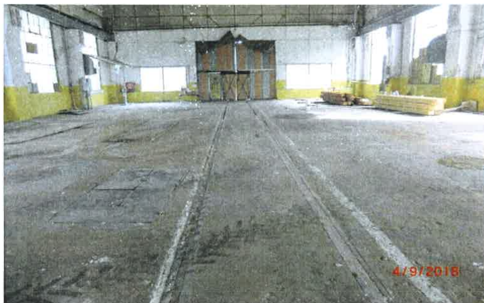
Rys. 3 Widok hali w kierunku głównej bramy.
