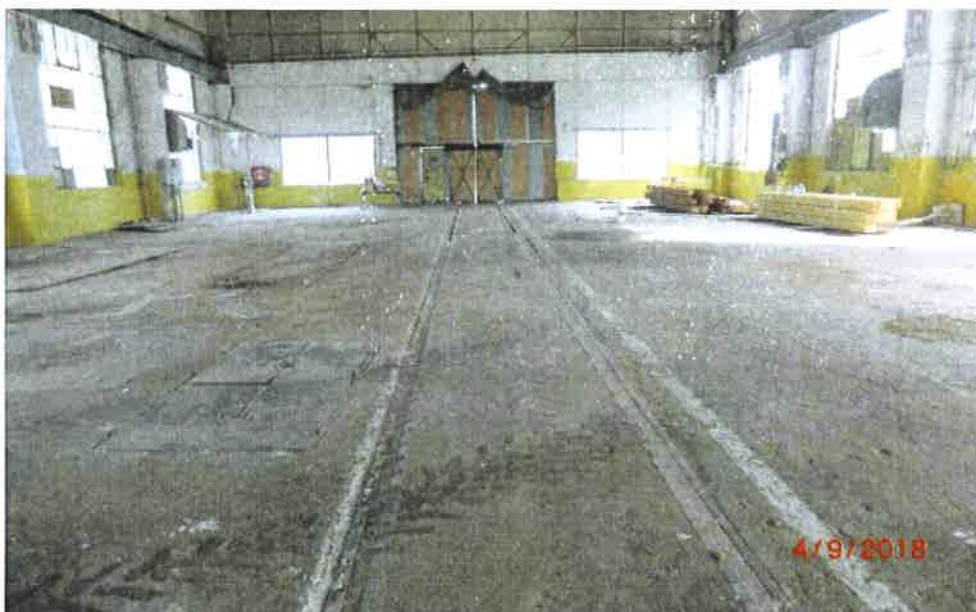
Rys. 3 Widok hali w kierunku głównej bramy.
