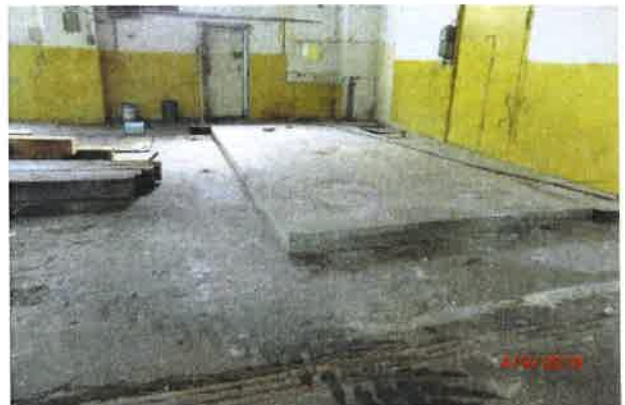
Rys. 8 i Rys. 9 Przykładowy fundament pod maszynę przewidziany do rozkucia.
