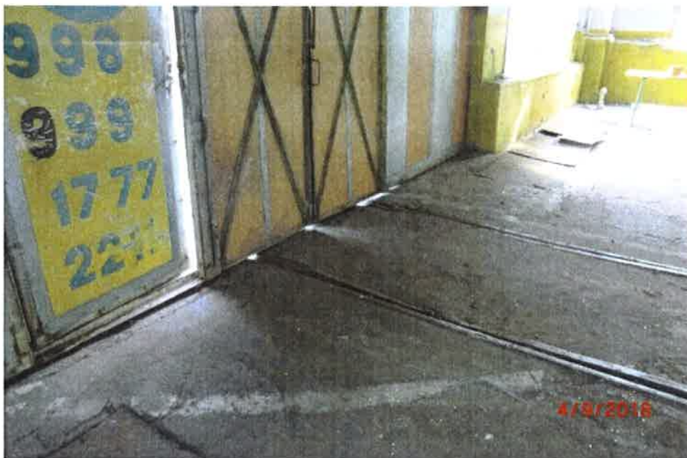
Rys. 6 Widok głównej bramy zlokalizowanej w ścianie szczytowej budynku nr 87.
