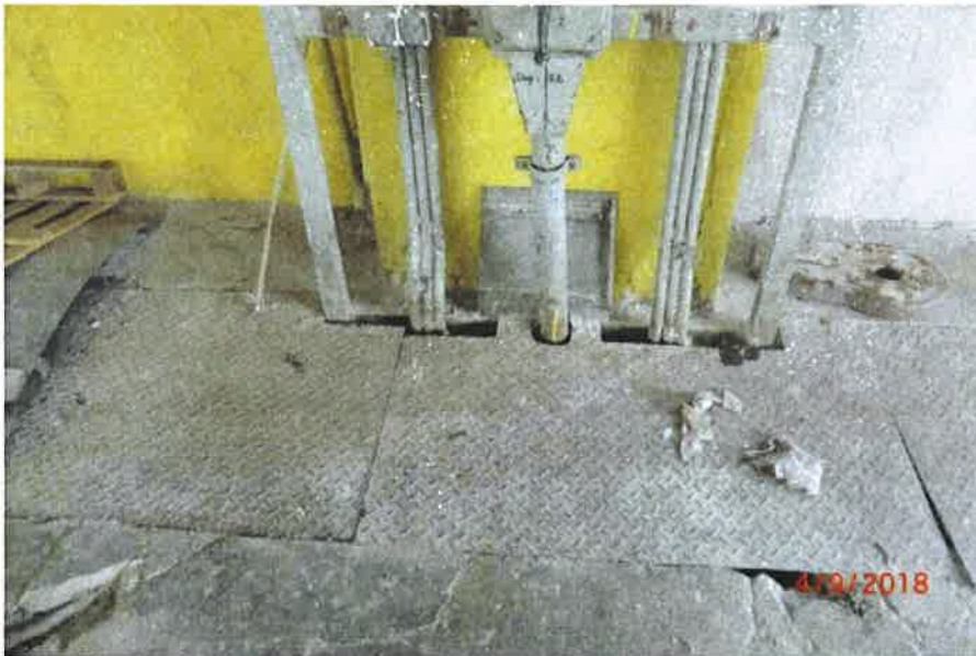
Rys. 7 Przykładowe przejście instalacji przez pokrywę kanału technicznego.
