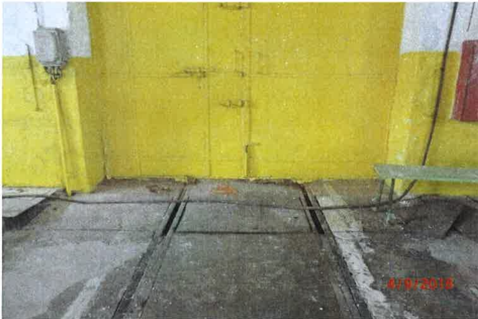
Rys. 5 Widok bramy stanowiącej łącznik między budynkami nr 87 i nr 88.
