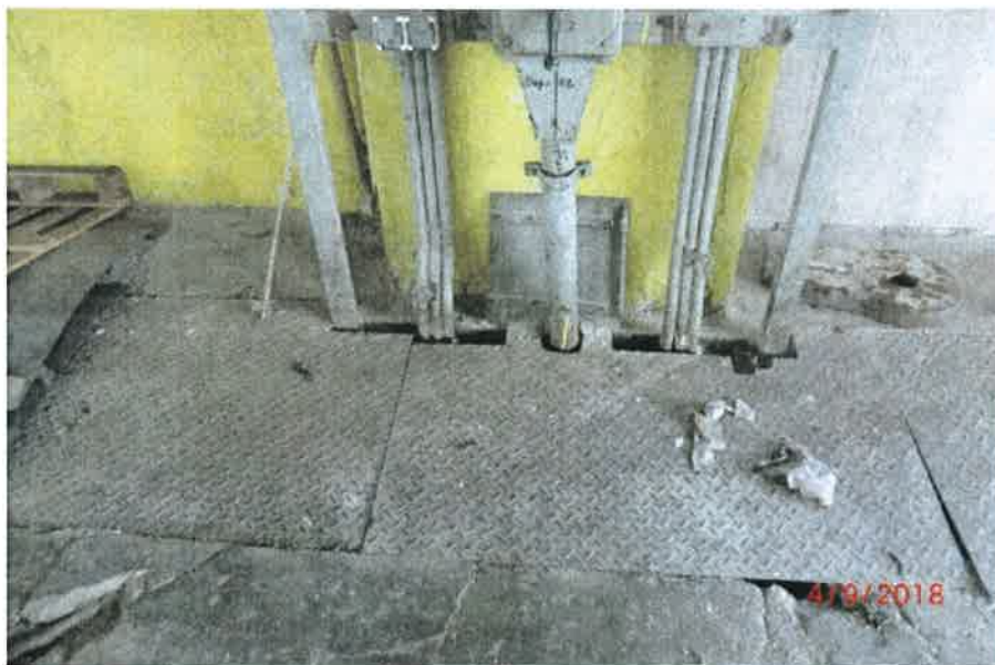
Rys. 7 Przykładowe przejście instalacji przez pokrywę kanału technicznego.
