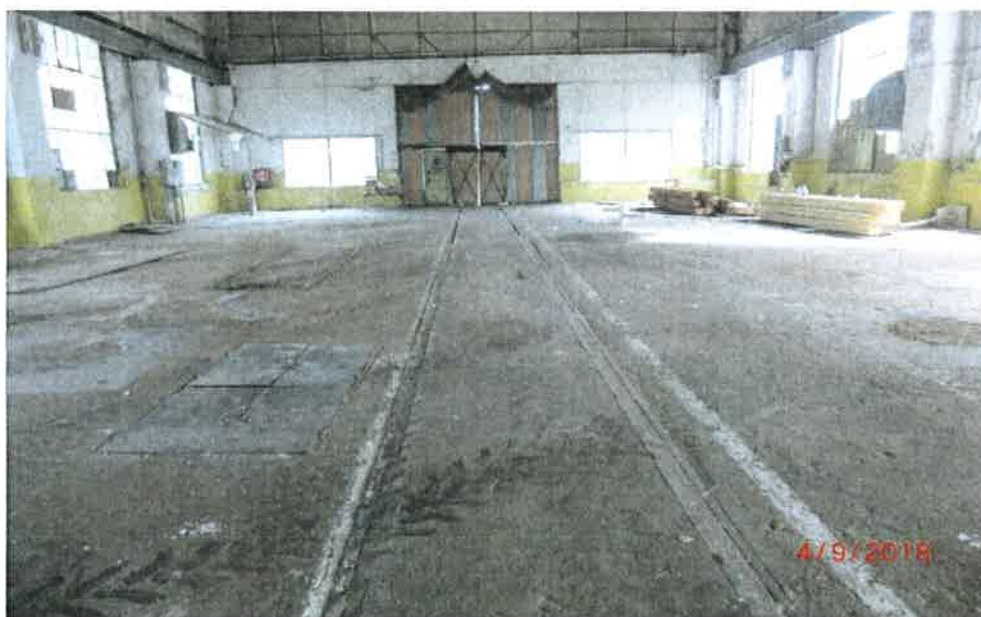
Rys. 3 Widok hali w kierunku głównej bramy.
