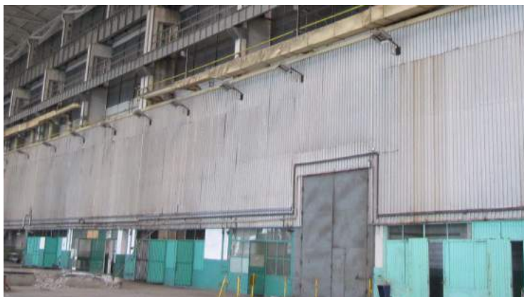
Widok istniejącej ściany dzielącej nawę AB i C od strony nawy C
