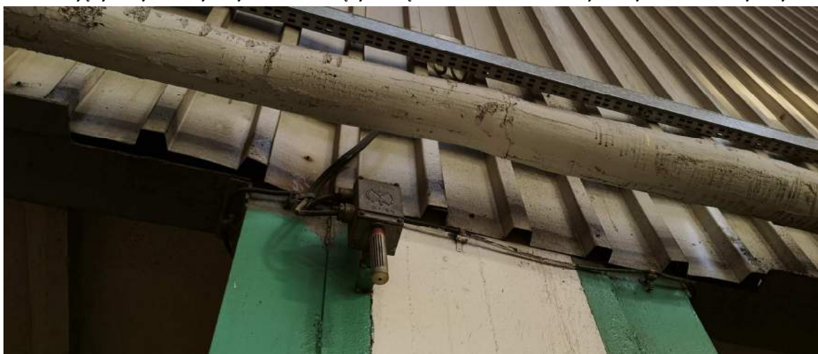
Widok dolnego zakończenia ściany od strony nawy C
