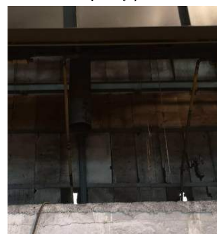
Konstrukcja ściany – widok od strony nawy AB
