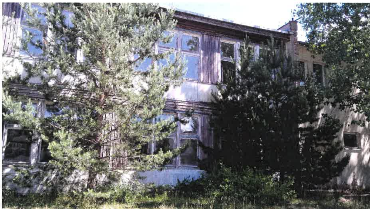
Fot. 3 – elewacja zachodnia (E).
