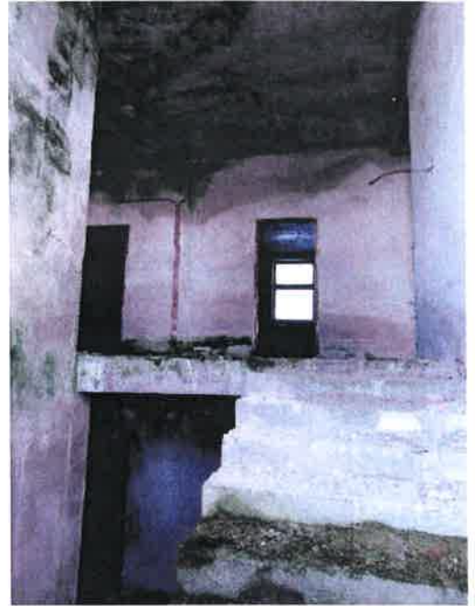
Fot. 16 – klatka schodowa w budynku A.
