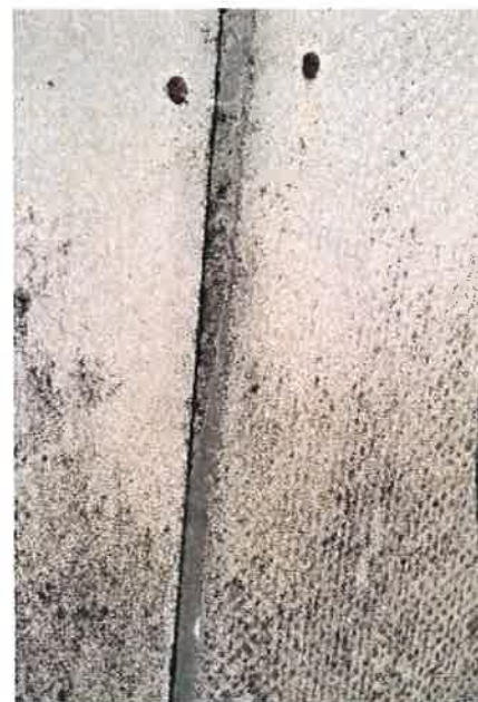
Fot. 10 – okładzina elewacyjna części drewnianej.
