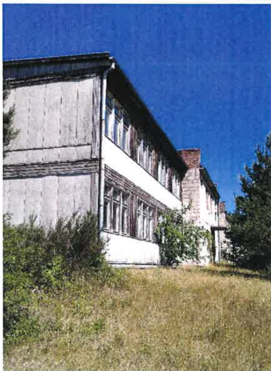
Fot. 1 – elewacja południowa (A).
