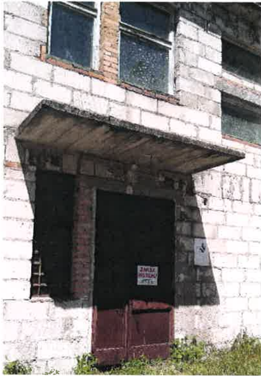
Fot. 7 – wejście do budynku A.
