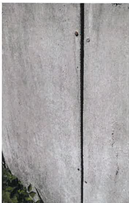
Fot. 5 – okładzina elewacyjna części drewnianej budynków.
