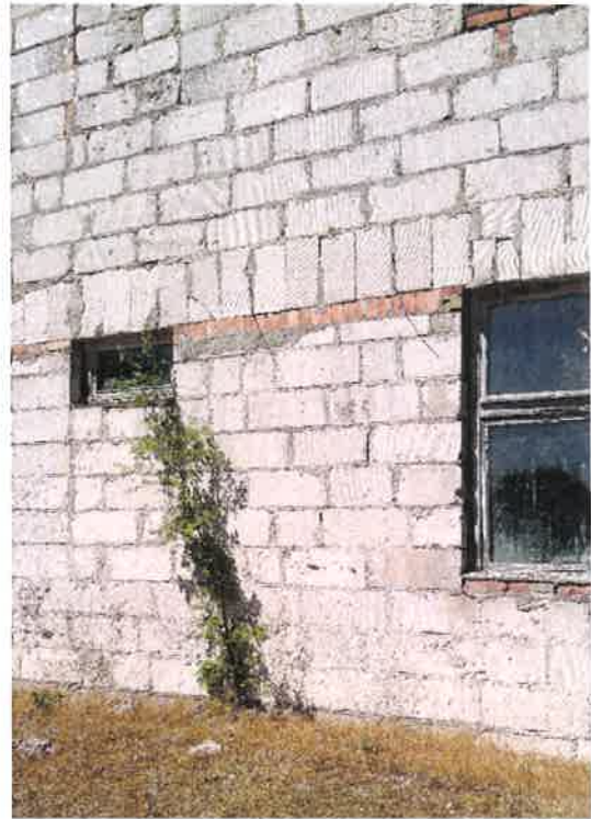
Fot. 8 – elewacja południowa A.
