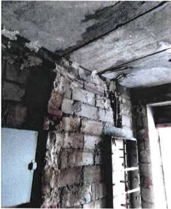
Fot. 15 – klatka schodowa w budynku A.
