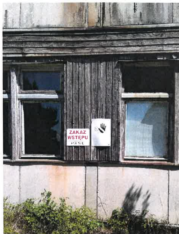
Fot. 8 – elewacja zachodnia budynku G.
