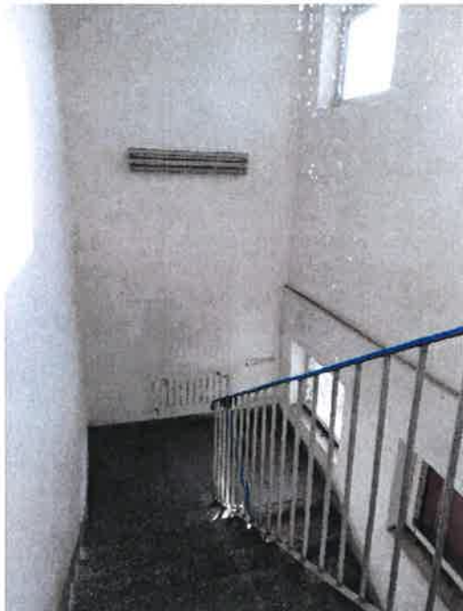
Fot. 24 – klatka schodowa (część murowana E).
