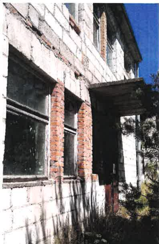
Fot. 3 – wejście do budynku A.
