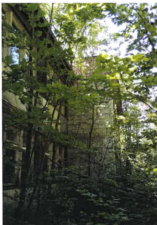
Fot. 14 – elewacja północna (B)
