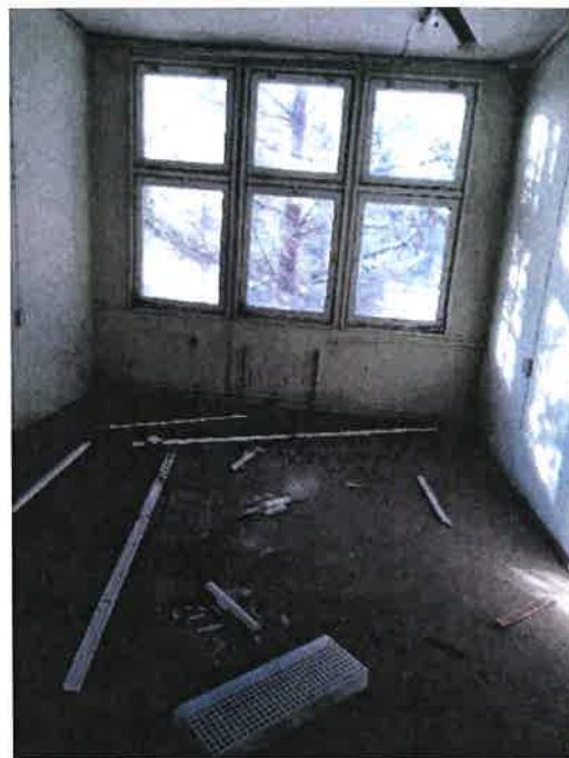
Fot. 13 – pomieszczenie biurowe. (część drewniana D).
