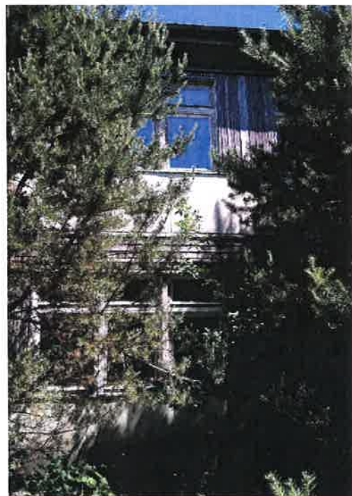
Fot. 2 – elewacja zachodnia (część drewniana F).
