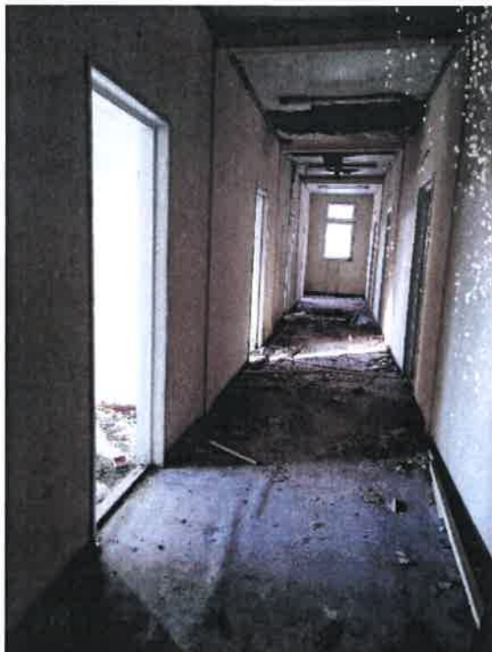
Fot. 23 – korytarz budynku G.
