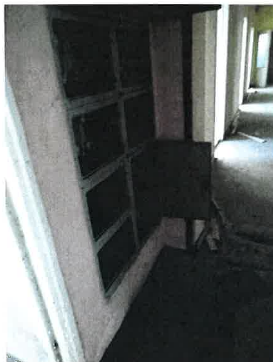
Fot. 10 – korytarz budynku F.
