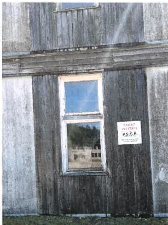
Fot. 5 – elewacja północna
