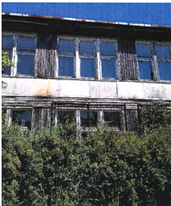
Fot. 1 – elewacja zachodnia (część drewniana D).
