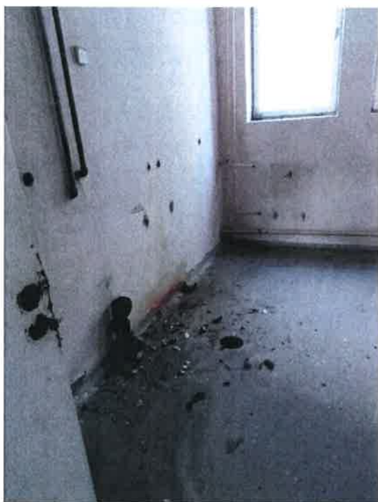
Fot. 17 – pomieszczenie techniczne. (część murowana G).
