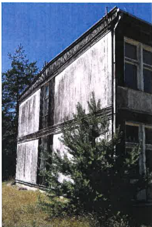
Fot. 1 – elewacja południowa
