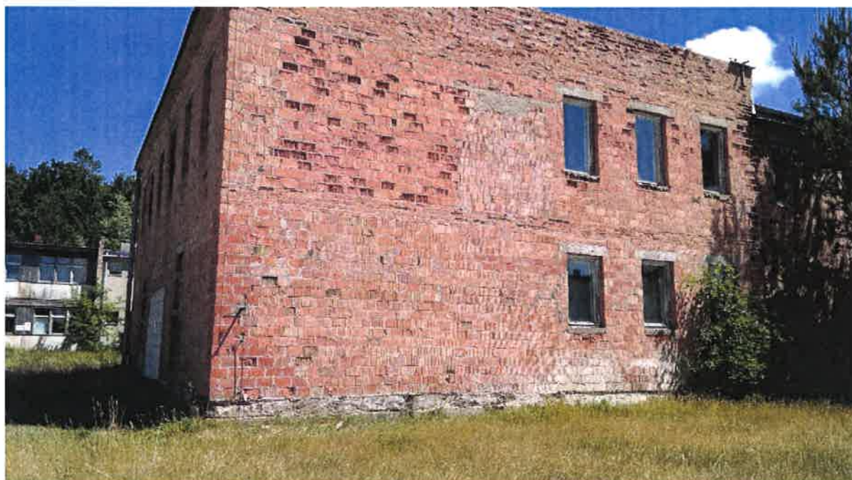
Fot. 4 – elewacja zachodnia (E/1)
