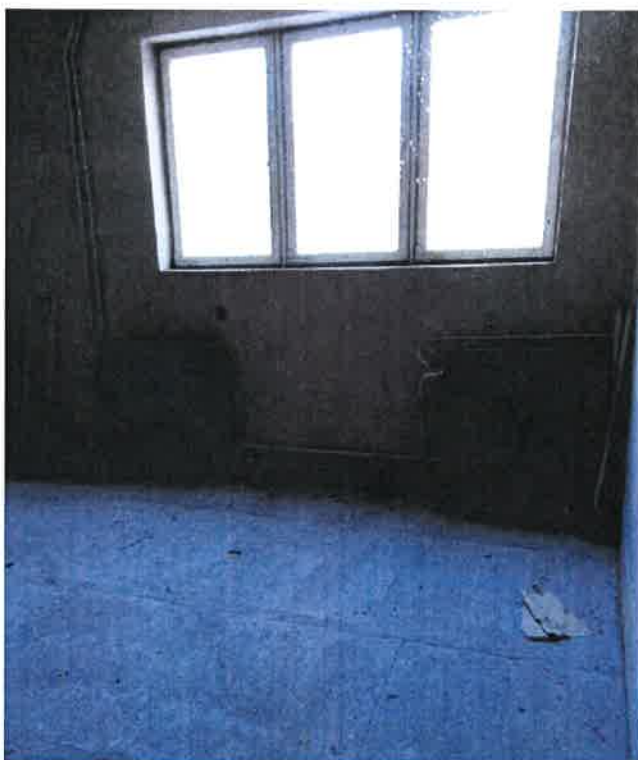
Fot. 15 – pomieszczenie biurowe (część drewniana F).
