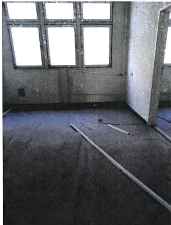
Fot. 24 – pomieszczenie biurowe (część drewniana G).
