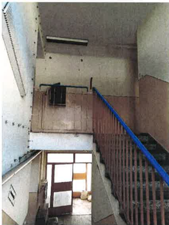
Fot. 13 – klatka schodowa (część murowana). murowana).
