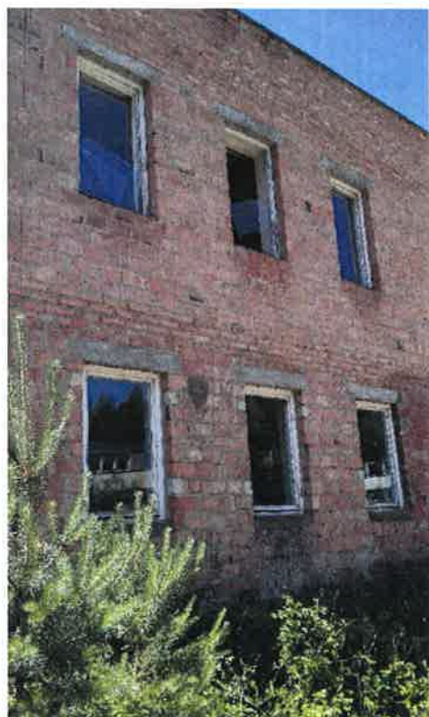
Fot. 6 – elewacja wschodnia (E/1).
