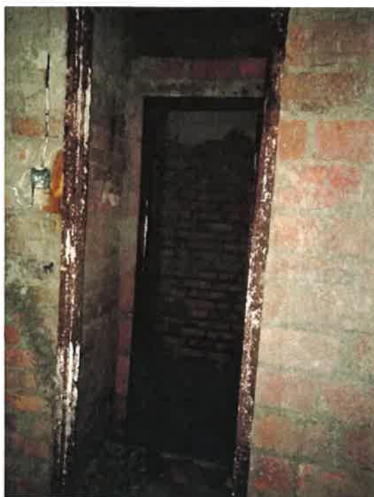
Fot. 21 – pomieszczenia sanitarne w budynku A. wewnątrz budynku A.
