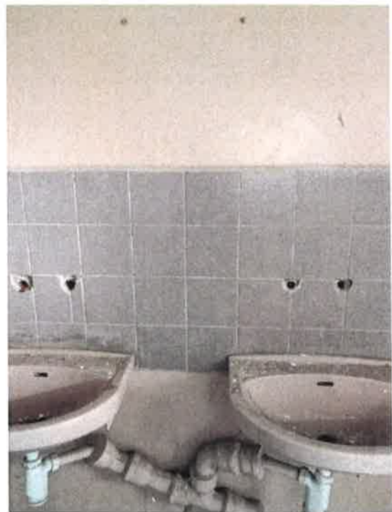
Fot. 14 – pomieszczenia sanitarne (część
