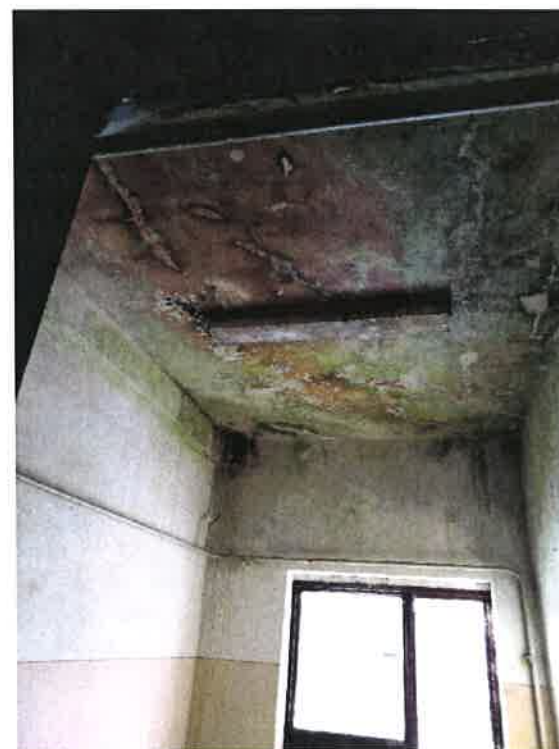
Fot. 15 – klatka schodowa (E).
