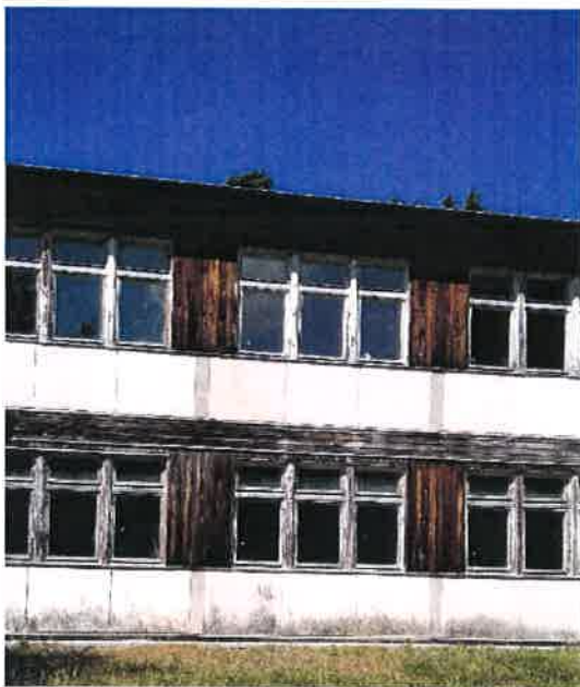
Fot. 9 – elewacja południowa A.
