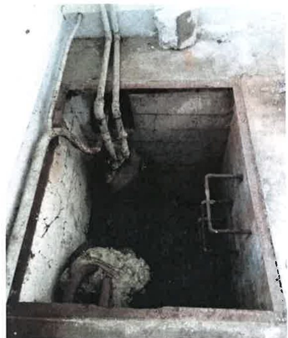
Fot. 10 – podłączenie rurociągów c.o. w budynku. (część murowana).
