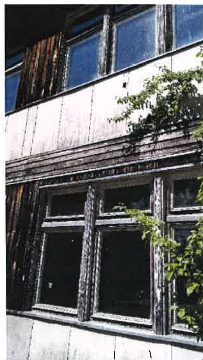
Fot. 6 – elewacja południowa (A)
