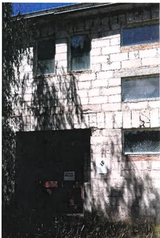
Fot. 11 – wejścia do budynku B.
