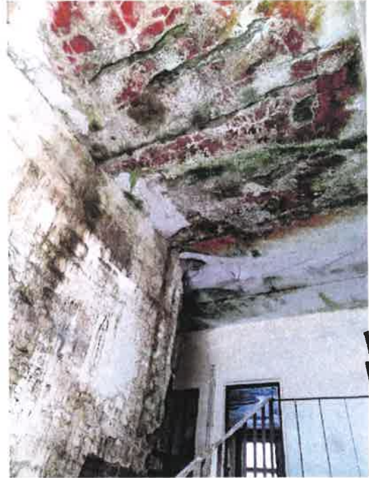
Fot. 32 – strop nad klatką schodową w bud. B
