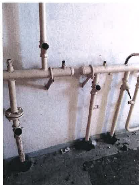
Fot. 18 – rozdzielacze c.o. (G).
