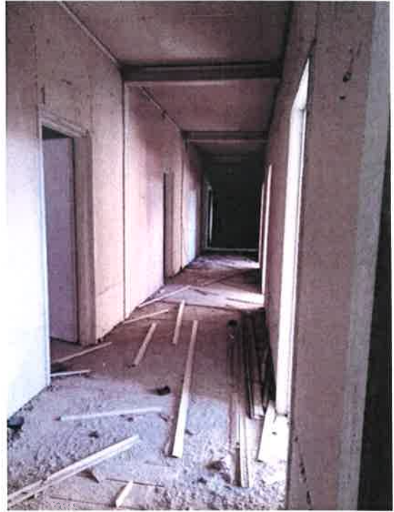
Fot. 24 – korytarz w części drewnianej budynku A.
