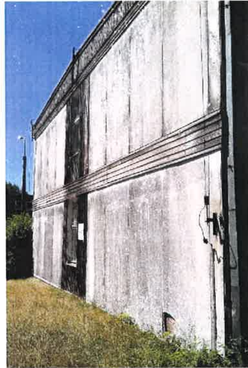
Fot. 9 – elewacja południowa (D).
