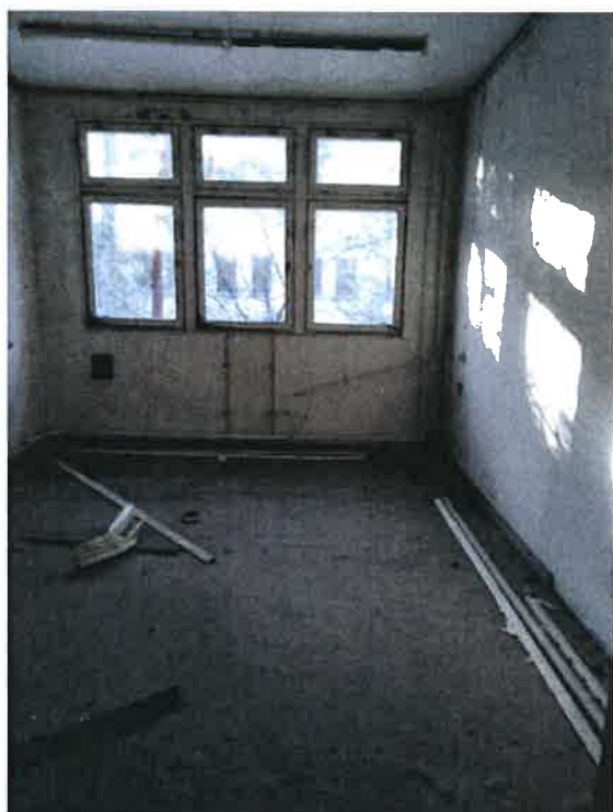
Fot. 13 – pomieszczenie biurowe (część drewniana F).
