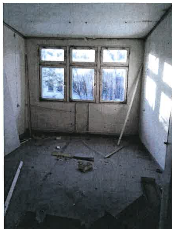
Fot. 14 – pomieszczenie biurowe (część drewniana F).
