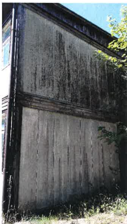
Fot. 13 – wschodnia ściana szczytowa (B).
