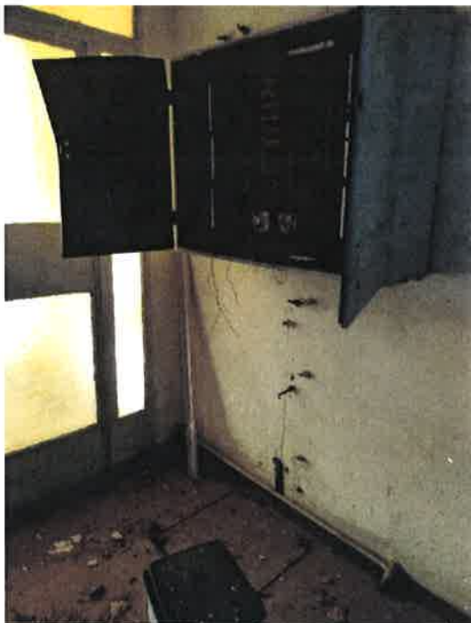
Fot. 10 – klatka schodowa (D).
