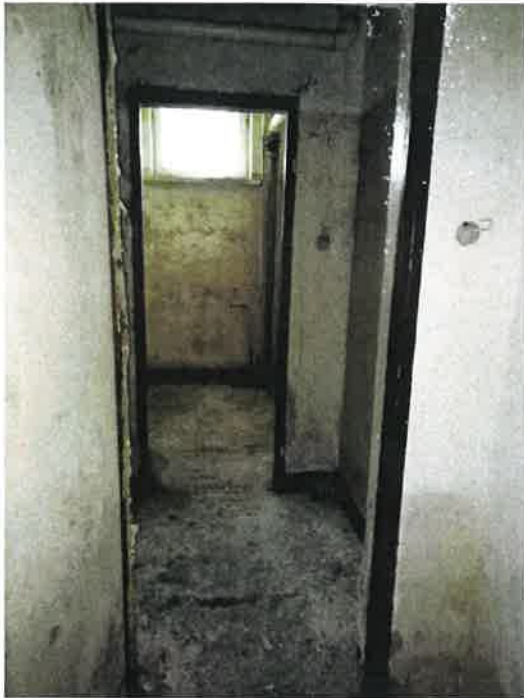
Fot. 35 – pomieszczenia sanitarne w budynku B.
