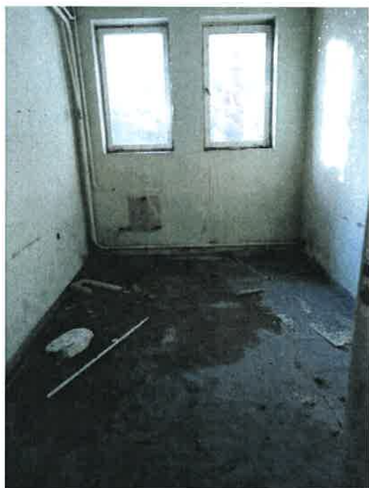
Fot. 11 – pomieszczenie techniczne (F).
