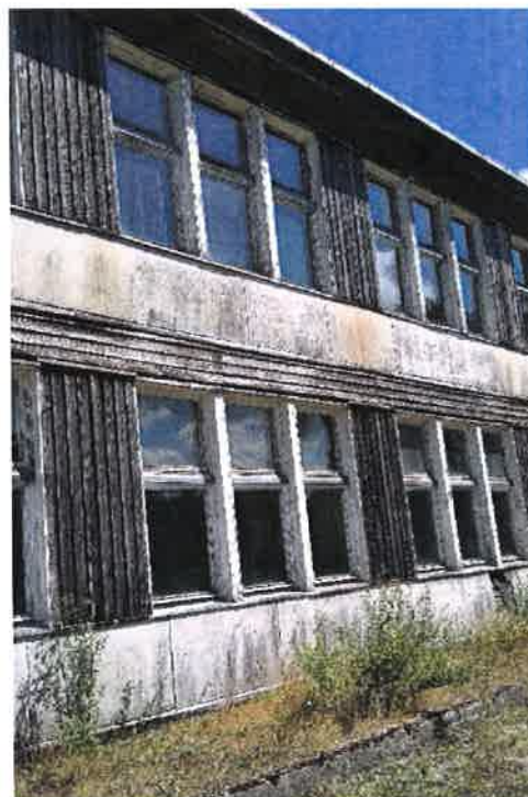
Fot. 6 – elewacja zachodnia
