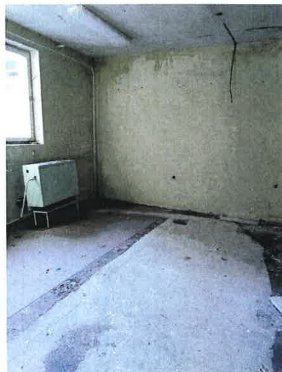
Fot. 26 – pomieszczenie techniczne (część murowana G).
