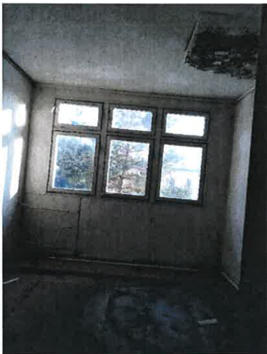
Fot. 37 – pomieszczenie biurowe (część drewniana B).
