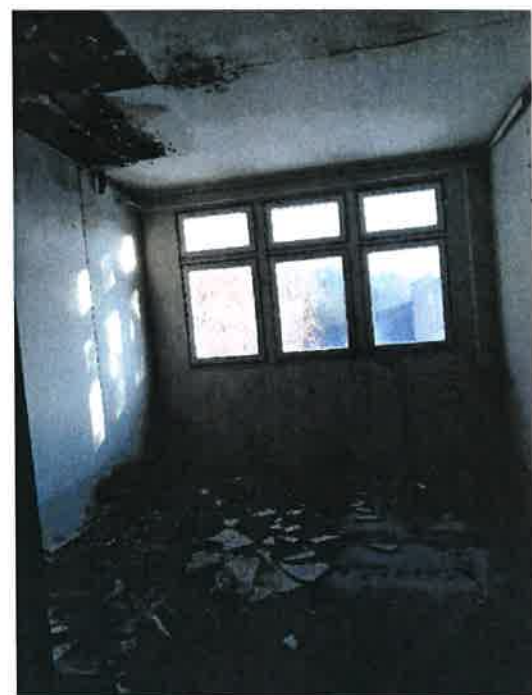
Fot. 28 – pomieszczenie biurowe (część drewniana B).
