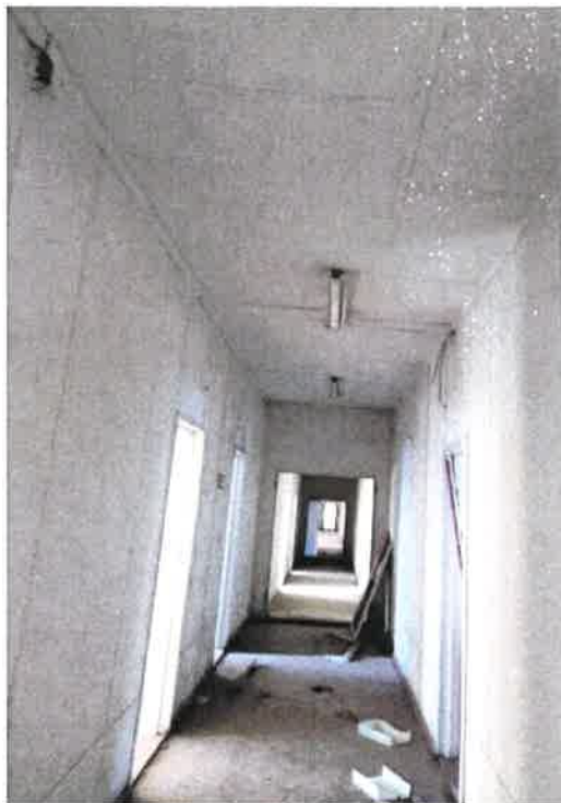
Fot. 12 – korytarz (D, E).
