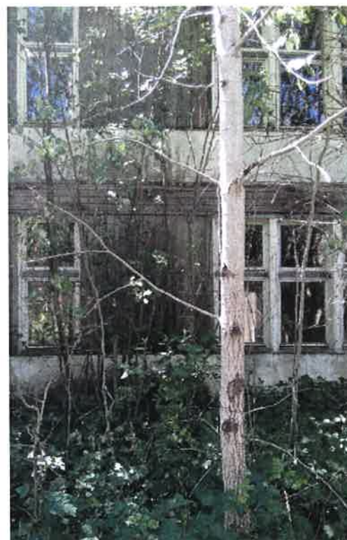
Fot. 7 – elewacja wschodnia (część drewniana E).
