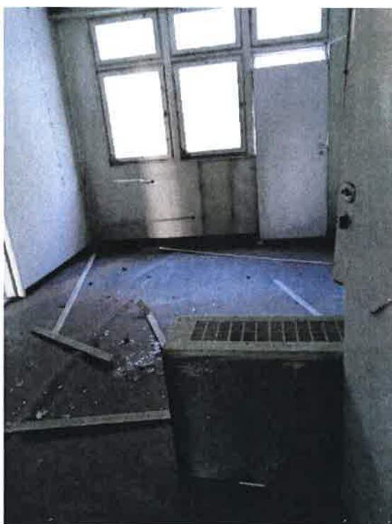
Fot. 25 – pomieszczenie biurowe (część drewniana G).
