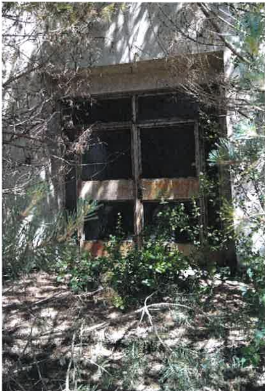
Fot. 5 – wejście do budynku G.
