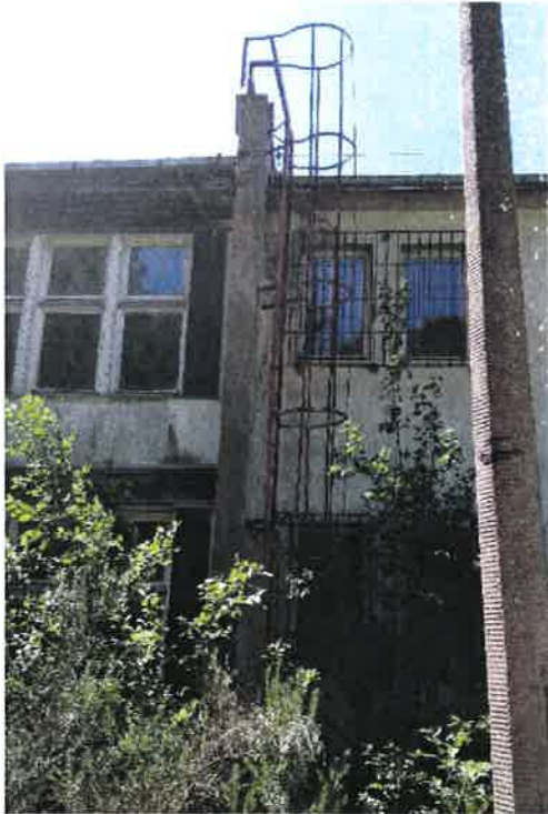
Fot. 8 – elewacja wschodnia (D).
