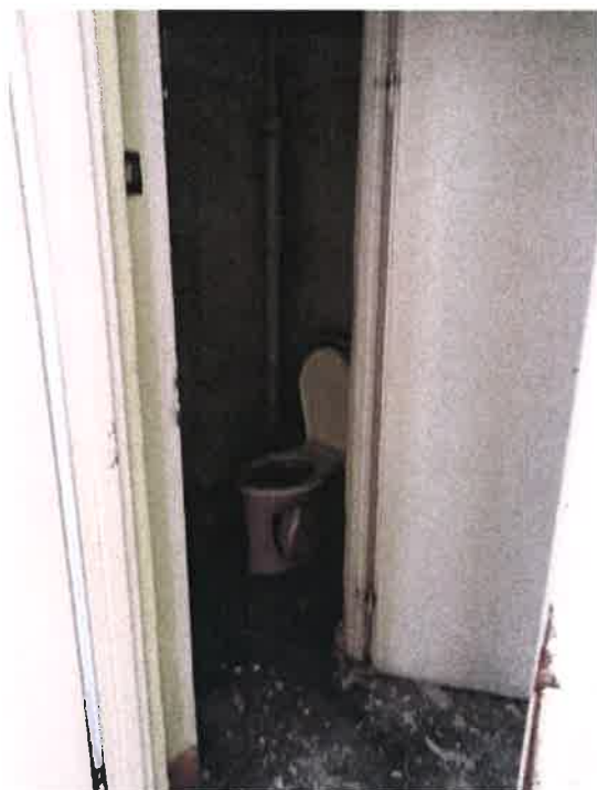
Fot. 26 – pomieszczenie sanitarne (część murowana E).
