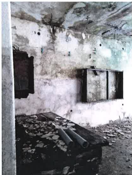
Fot. 33 – pomieszczenie techniczne (część murowana B).
