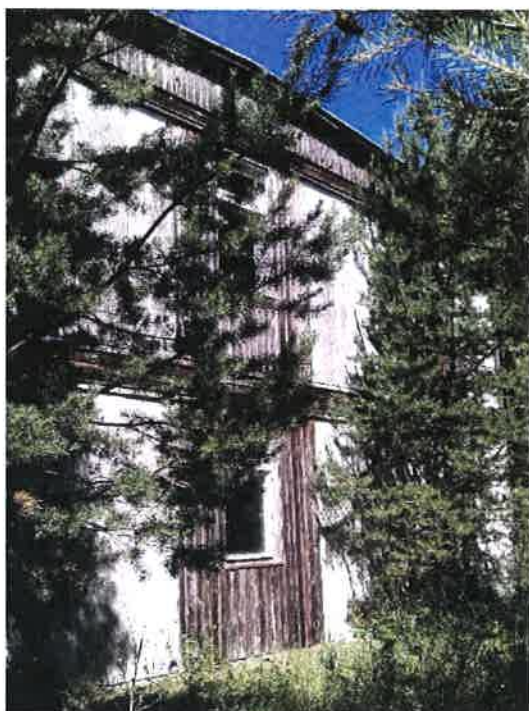
Fot. 1 – elewacja południowa (część drewniana F).
