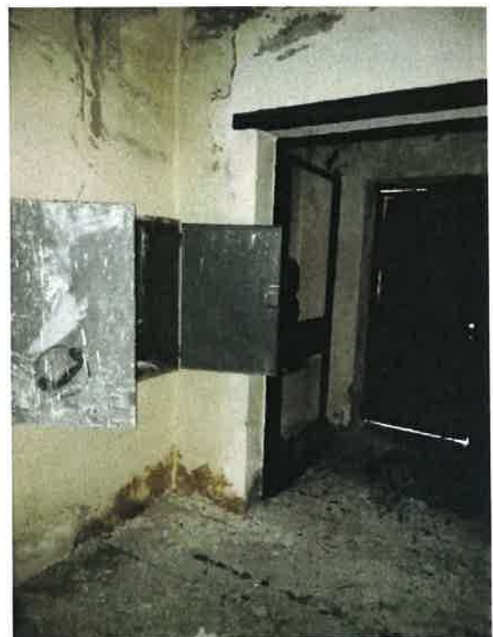
Fot. 30 – klatka schodowa w bud. B
