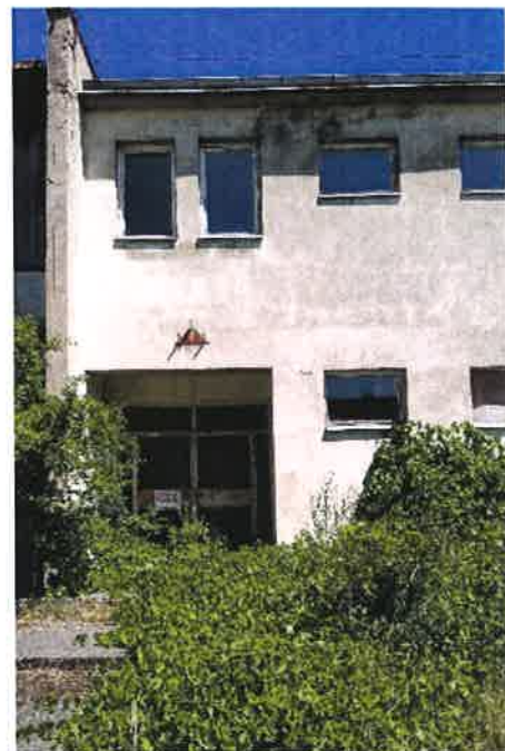
Fot. 2 – elewacja zachodnia (część murowana D).
