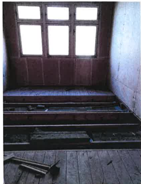
Fot. 26 – pomieszczenia biurowe.
