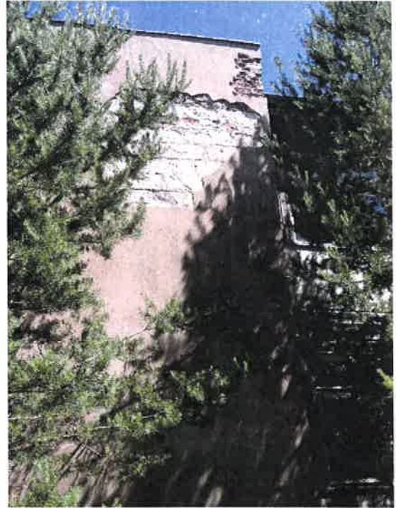
Fot. 4 – elewacja zachodnia (część murowana F).
