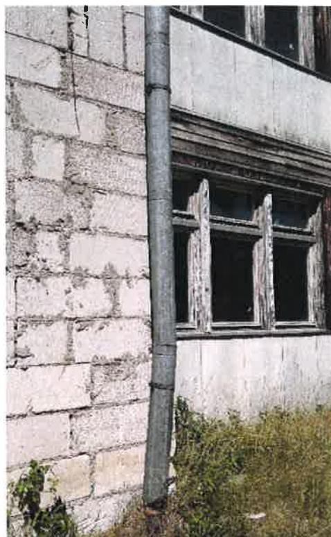
Fot. 4 – elewacja południowa budynku A.
