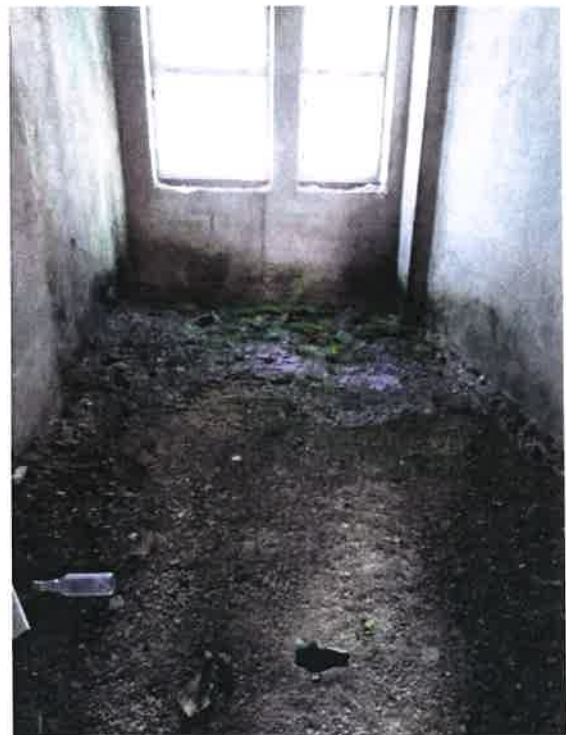
Fot. 18 – posadzka w pomieszczeniu technicznym (część murowana A).
