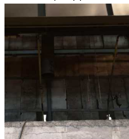
Konstrukcja ściany – widok od strony nawy AB
