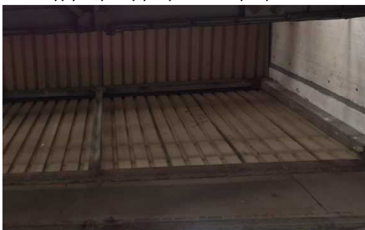
Widok istniejącej ściany od strony nawy AB – nad bramą wjazdową
