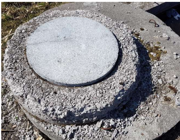
Fot. 52 – Właz studni D12.7.
