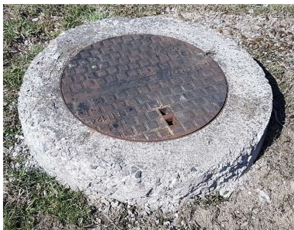
Fot. 42 – Obudowa wężu studni D8.3 .
