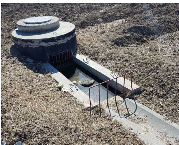
Fot. 38 – Wlot otwarty do studni D12.4.
