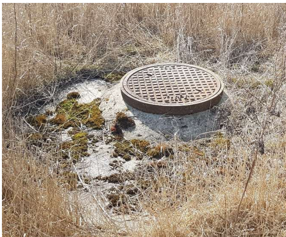
Fot. 3 – Pokrywa studni D6
