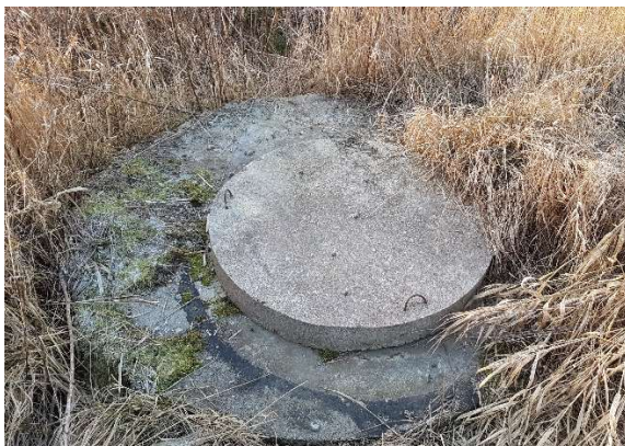
Fot. 9 – Pokrywa studni D21
