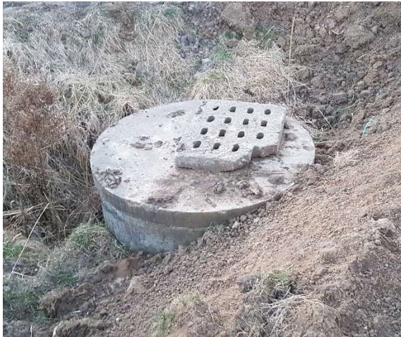
Fot. 13 – Pokrywa studni D1
