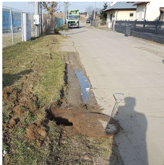
Fot. 2 – Lokalizacja studni D35
