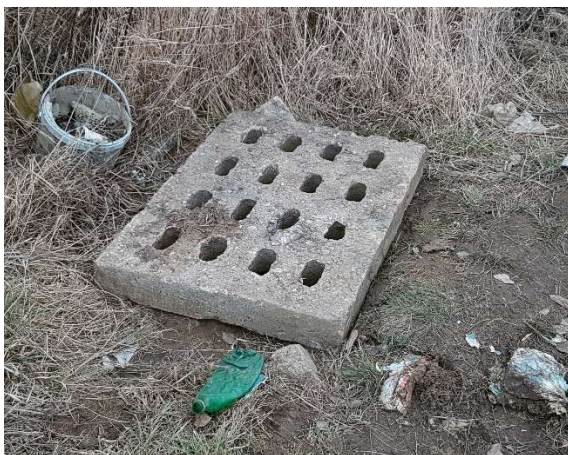
Fot. 15 – Pokrywa studni D3
