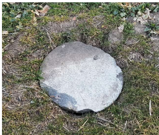
Fot. 20 – Pokrywa studni D14
