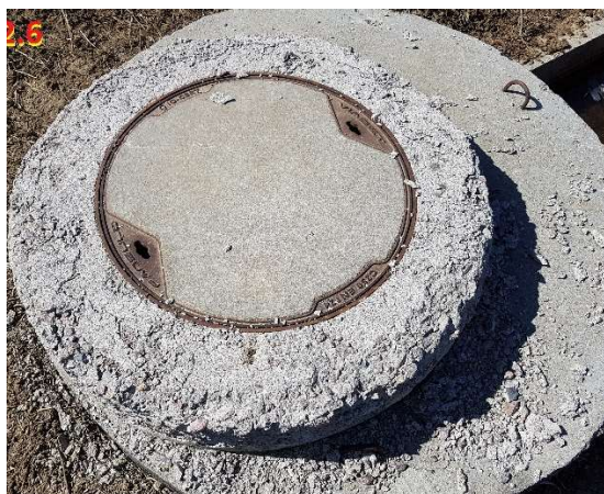
Fot. 48 – Obudowa włazu studni D12.6.
