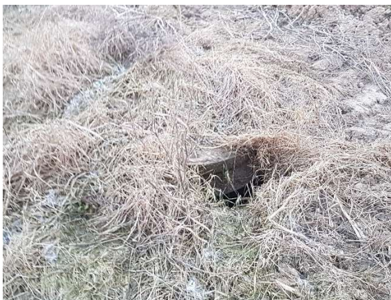
Fot. 17 – Pokrywa studni D5
