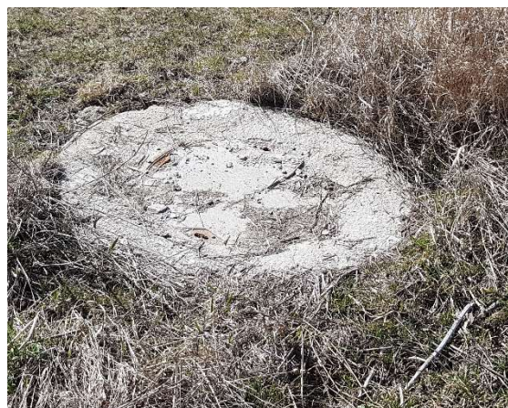
Fot. 43 – Obudowa wężu studni D8.5 .
