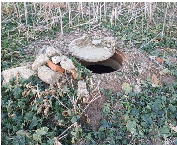
Fot. 19 – Pokrywa studni D12
