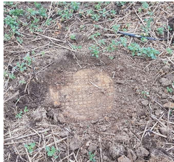
Fot. 6 – Pokrywa studni D10
