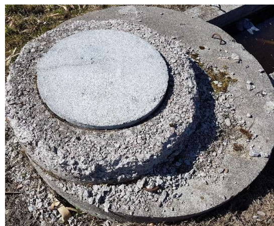
Fot. 49 – Obudowa włazu studni D12.7.
