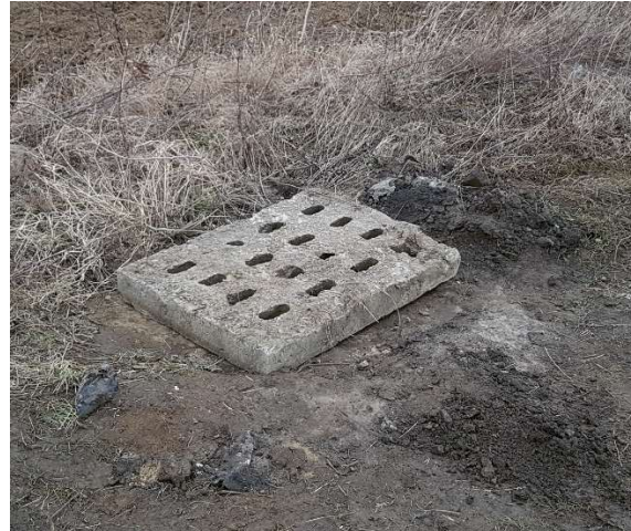
Fot. 14 – Pokrywa studni D2
