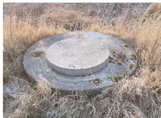
Fot. 10 – Pokrywa studni D22
