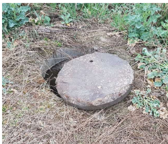
Fot. 22 – Pokrywa studni D17.
