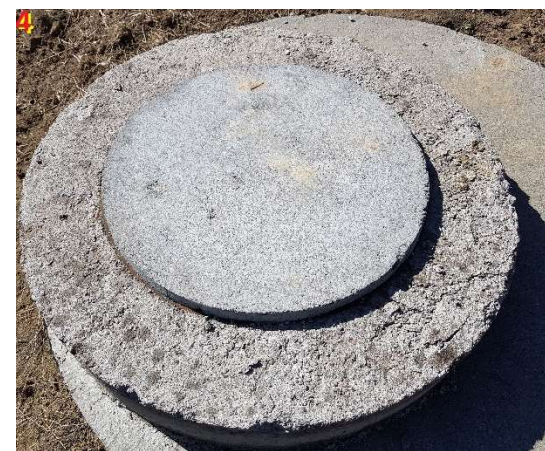
Fot. 51 – Właz studni D12.4.
