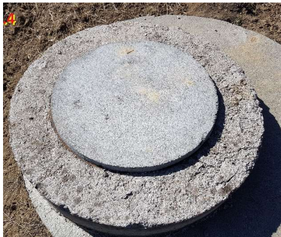
Fot. 46 – Obudowa włazu studni D12.4.
