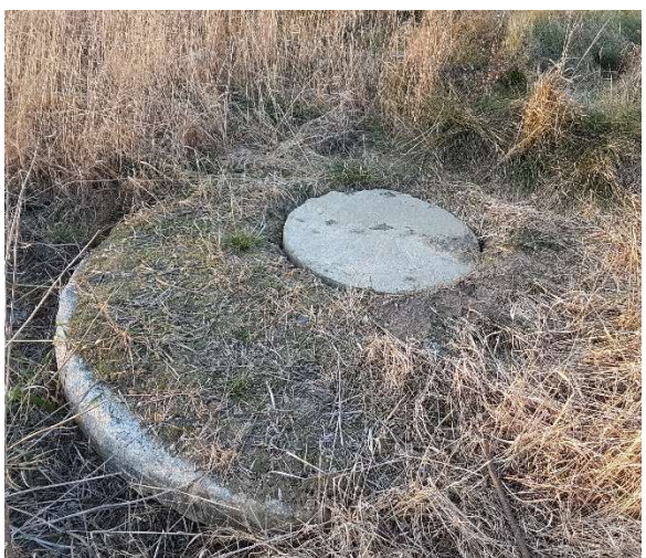
Fot. 23 – Pokrywa studni D17.1.
