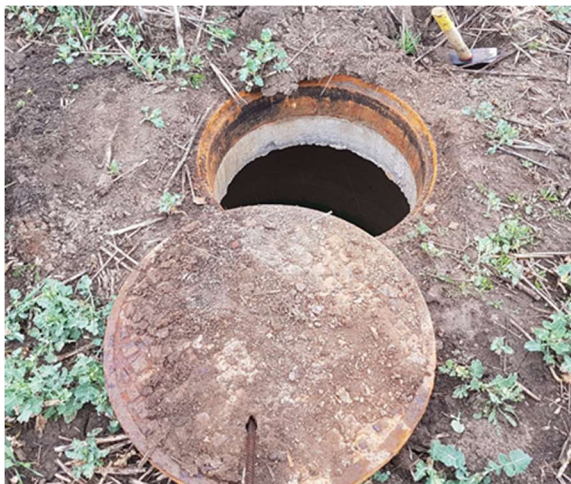
Fot. 7 – Pokrywa studni D13
