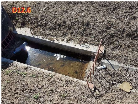
Fot. 40 – Wlot otwarty do studni D12.6 .
