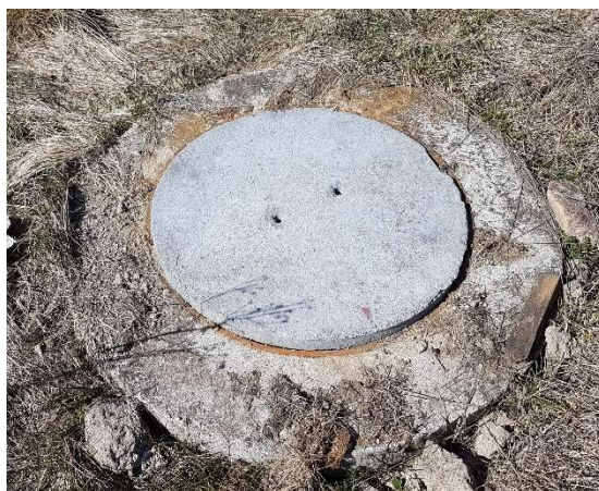
Fot. 50 – Właz studni D12.3.3.
