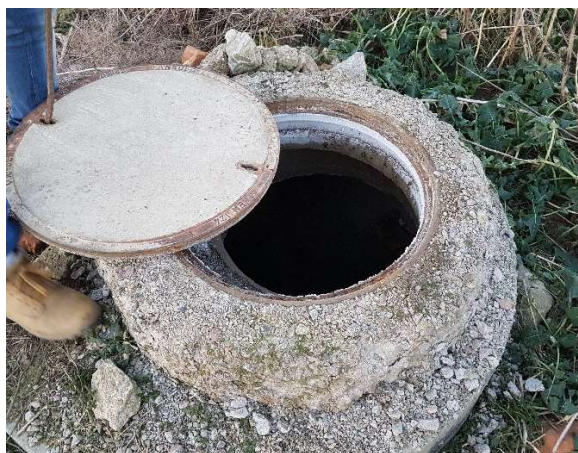
Fot. 44 – Obudowa wężu studni D12.1 .
