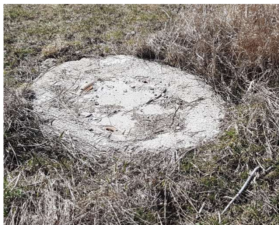
Fot. 53 – Właz studni D8.5.
