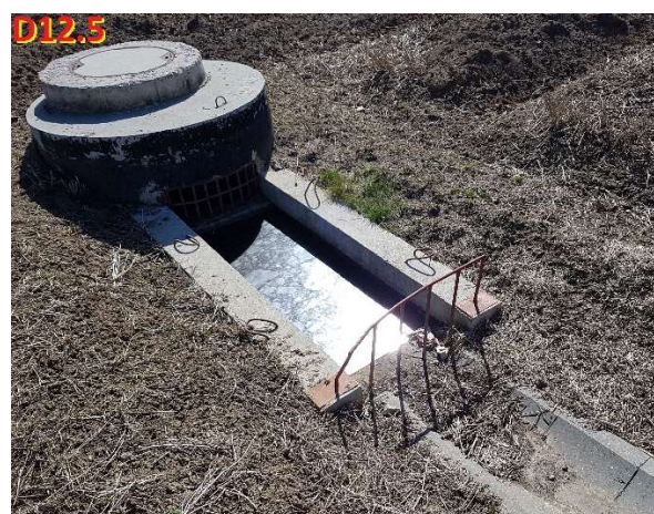
Fot. 39 – Wlot otwarty do studni D12.5.
