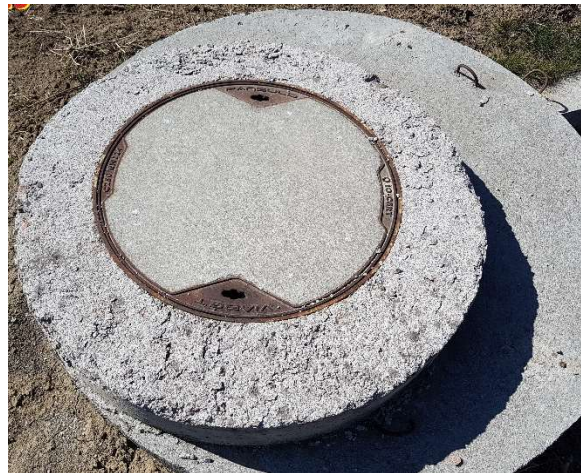
Fot. 47 – Obudowa włazu studni D12.5.
