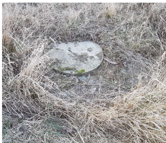
Fot. 26 – Pokrywa studni D23.
