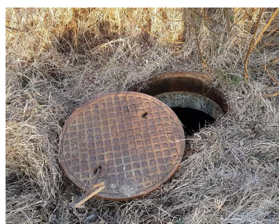
Fot. 12 – Pokrywa studni D38
