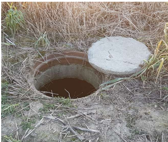
Fot. 25 – Pokrywa studni D20.
