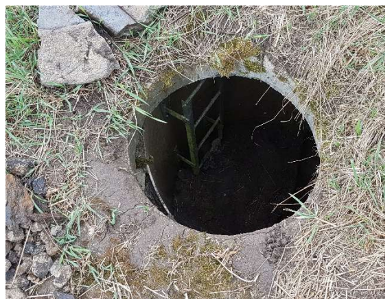
Fot. 18 – Pokrywa studni D11
