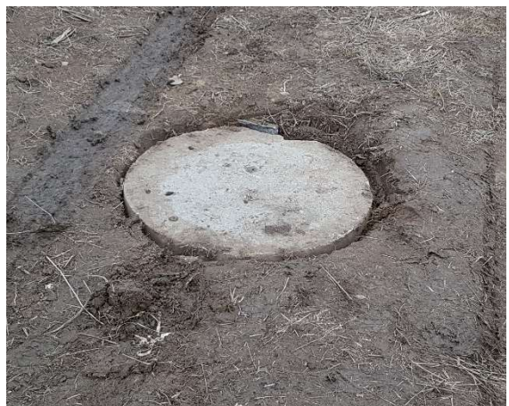
Fot. 16 – Pokrywa studni D4
