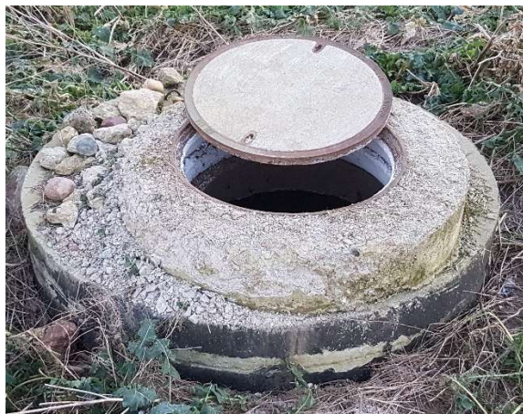
Fot. 45 – Obudowa wężu studni D12.2 .
