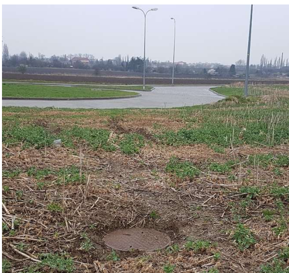
Fot. 5 – Pokrywa studni D9
