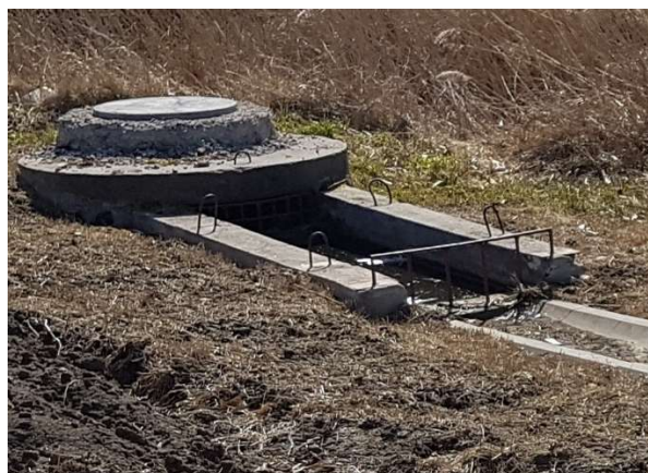
Fot. 41 – Wlot otwarty do studni D12.7 .
