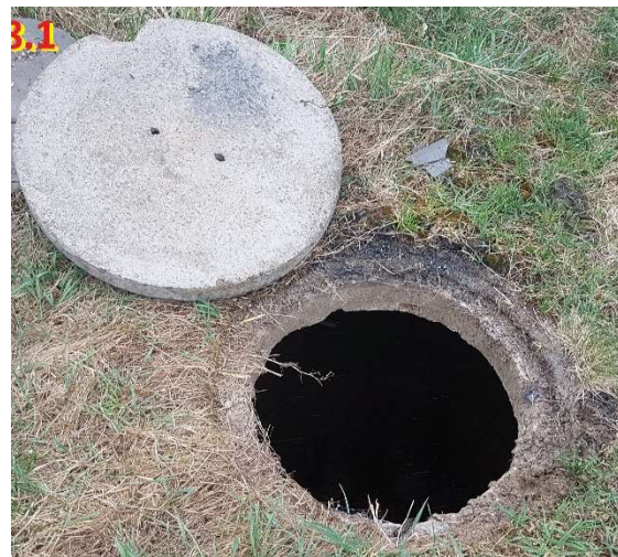
Fot. 24 – Pokrywa studni D18.1.
