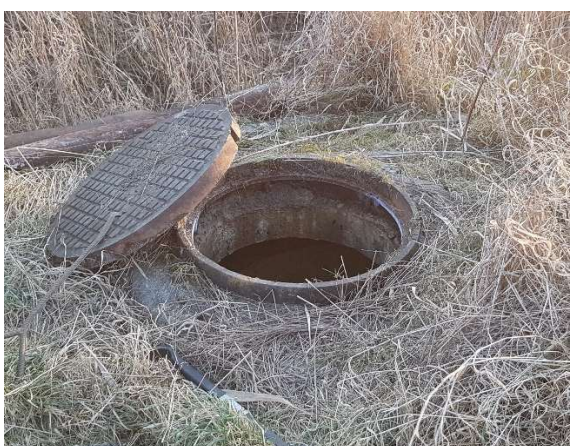
Fot. 11 – Pokrywa studni D24
