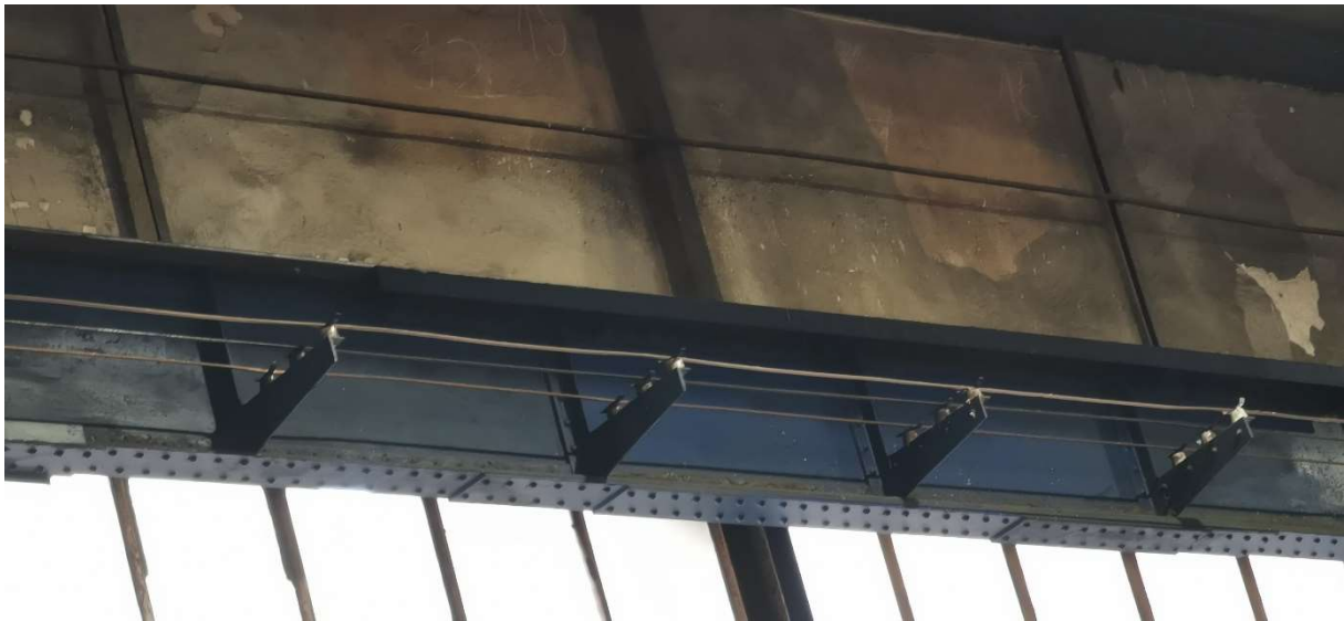
Zasilanie suwnic- trojele
