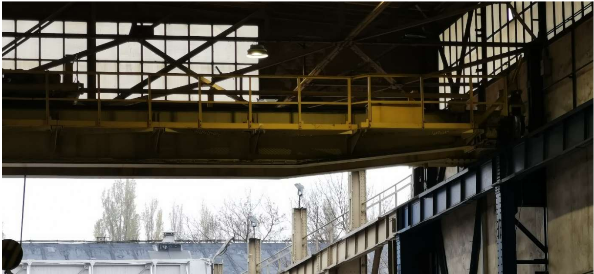
Widok belki podsuwnicowej biegnącej w budynku i na estakadzie
