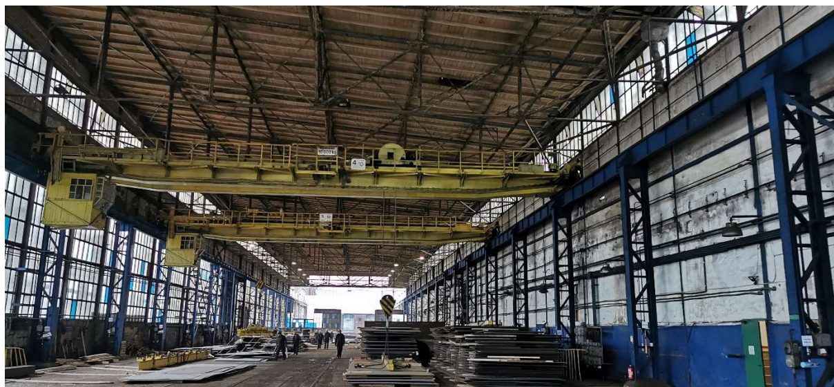
Widok wnętrza budynku w trakcie produkcji prowadzonej przez Spółkę Montex
