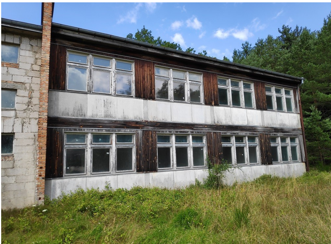
BUDYNEK ZEW-81 B
