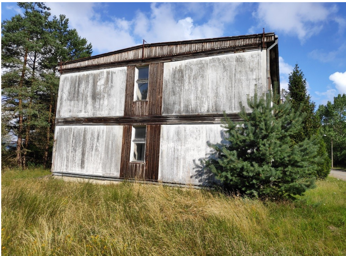
BUDYNEK ZEW-80 C
