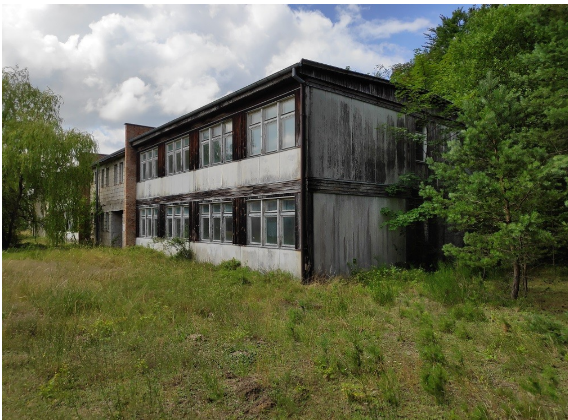
BUDYNEK ZEW-81 B
