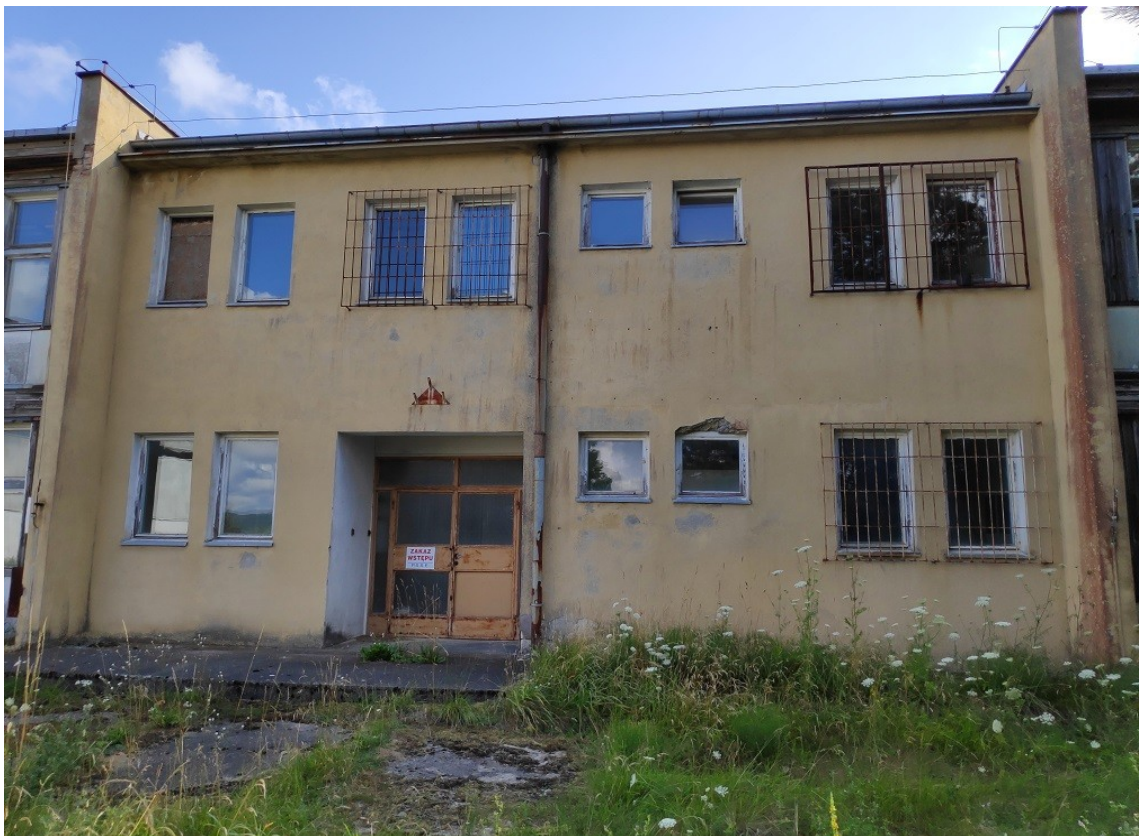
BUDYNEK ZEW-80 C
