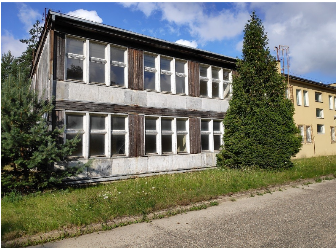
BUDYNEK ZEW-80 C
