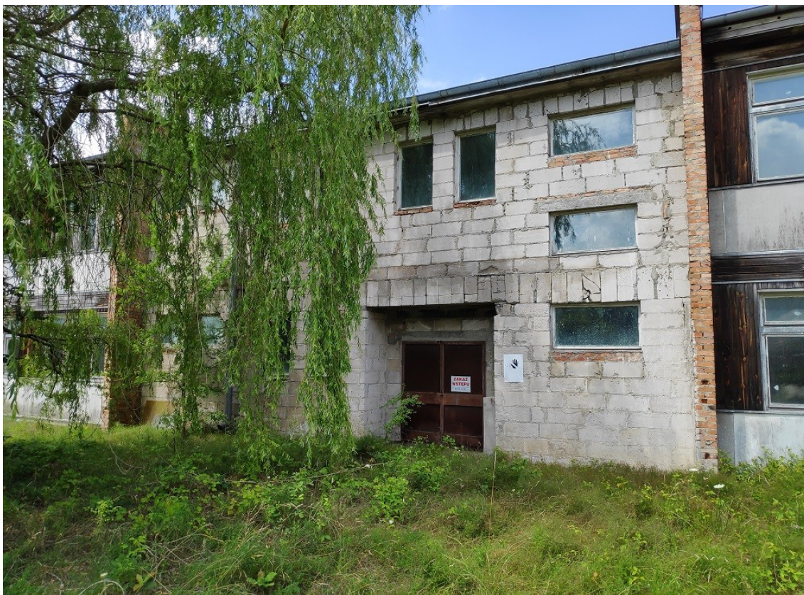
BUDYNEK ZEW-81 B
