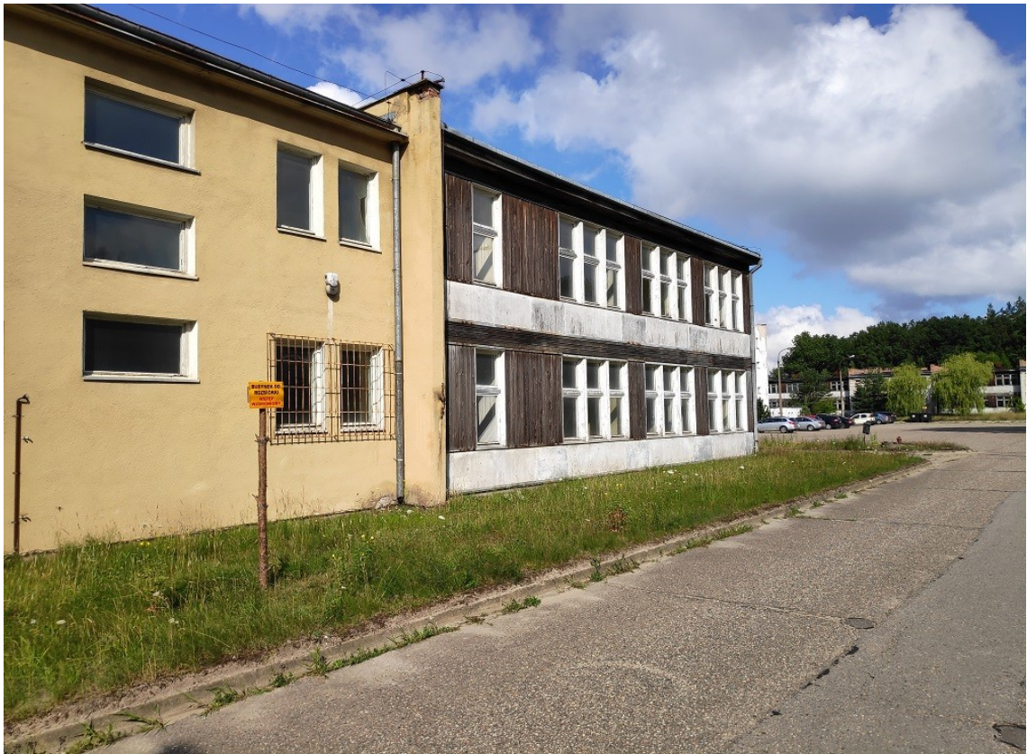
BUDYNEK ZEW-80 C
