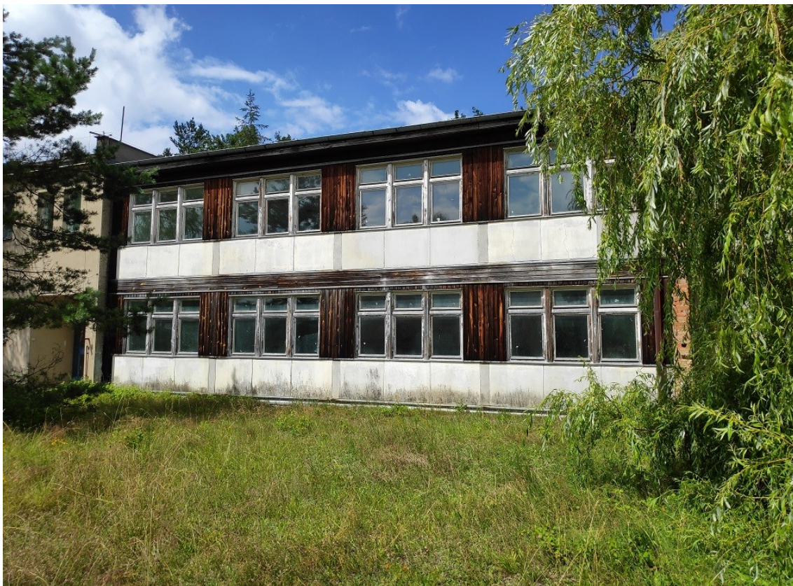
BUDYNEK ZEW-81 B
