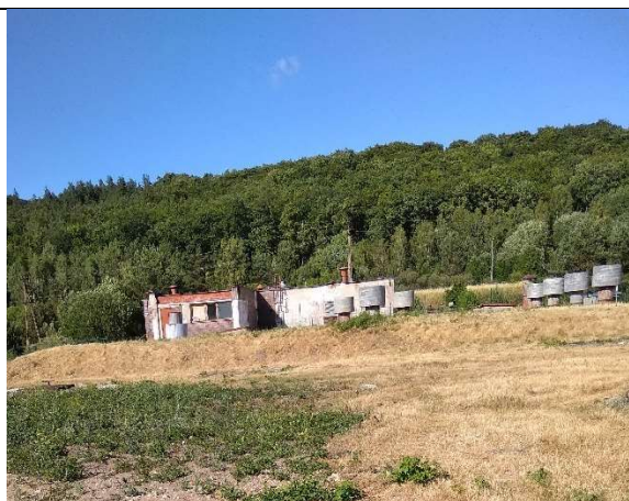
Fot. 15 – Widok na teren przepompowni od. Ul. Budowlanej.
