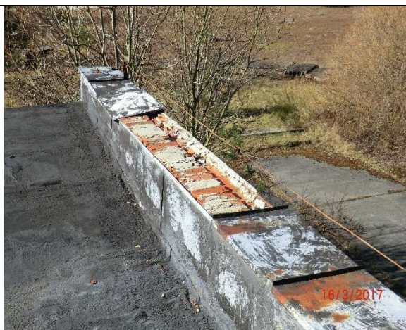
Fot. 39 – Murek ogniochronny do naprawy.
