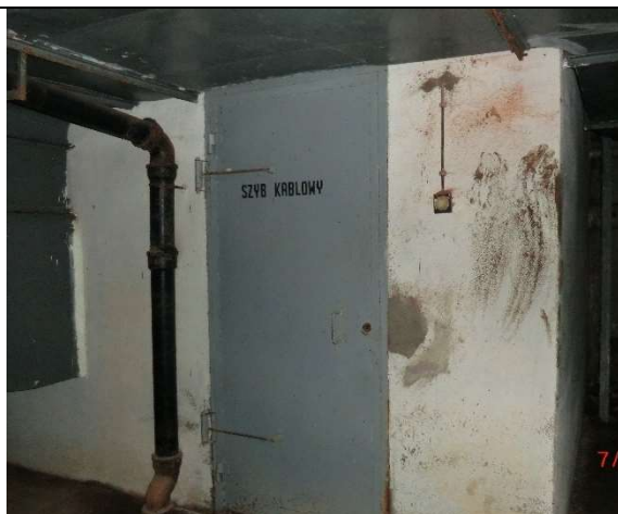
Fot. – 97 (Poziom -6.10) – wejście do szybu kablowego
