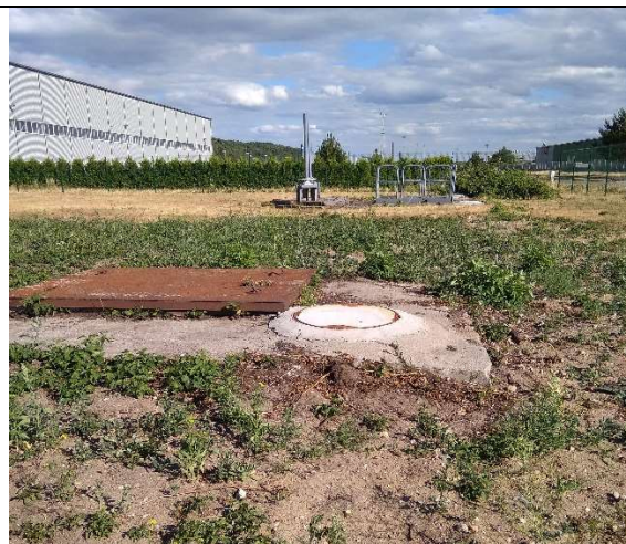
Fot. 2 (Teren) – przykrycie komory nieczynnej kanalizacji sanitarnej.
