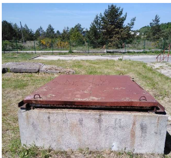
Fot. 23 – Pokrywa – do wymiany/konserwacji.
