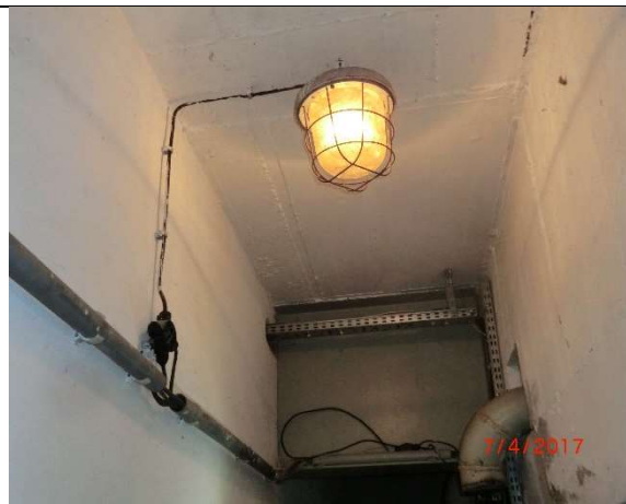
Fot. – 70 (Poziom -2.50) – Korytarz prowadzący do zbiorników.
