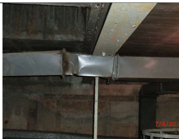
Fot. – 75 (Poziom -2.50) – Galeria – istn. kanały wentylacyjne do demontażu i utylizacji.
