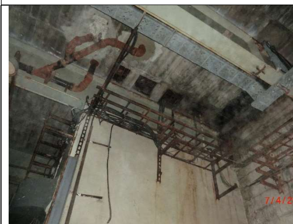
Fot. – 111 (Poziom -12.10) – nieczynna hala pomp Do uzupełnienia oświetlenie. Drabinki kabli elektrycznych – do demontażu i utylizacji.
