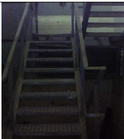
Fot. – 55 (Poziom +1.10) – klatka schodowa.
