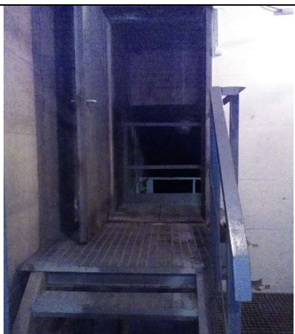
Fot. – 79 (Poziom -2.50) – Galeria – wejście do zbiorników wód opadowych.
