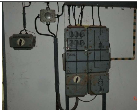
Fot. – 56 (Poziom -2.50) – rozdzielnicza do przebudowy, demontaż zbędnych instalacji.
