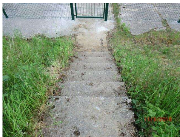
Fot. 30 – Schody i furтка od strony drogi dojazdowej.
