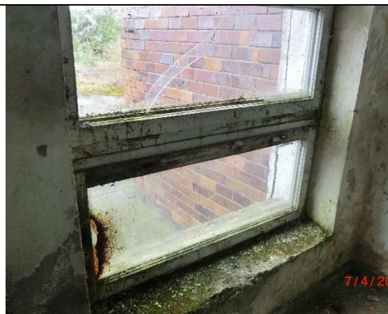
Fot. – 50 (Poziom +1.10) – demontaż stolarki okiennej, zabudowa otworu okiennego luksferami.
