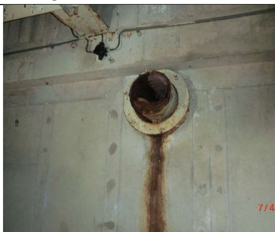
Fot. – 99 (Poziom -6.10) – otwory do zamurowania i trwałego zabezpieczenia.
