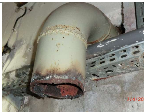
Fot. – 72 (Poziom -2.50) – Korytarz prowadzący do zbiorników – istn. rurociągi do demontażu; otwory do zamurowania.
