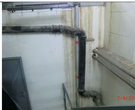
Fot. – 54 (Poziom +1.10) – klatka schodowa
