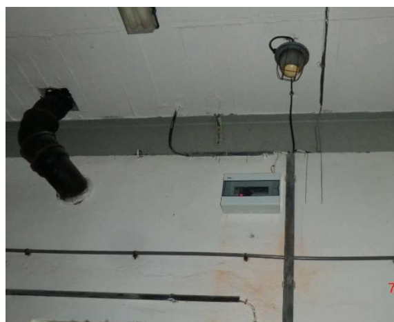
Fot. – 58 (Poziom -2.50) – demontaż zbędnych instalacji.
