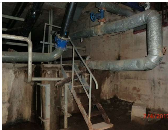
Fot. – 101 (Poziom -6.10) – schody/wejście do tunelu technologicznego prowadzącego na zewnątrz budynku.
