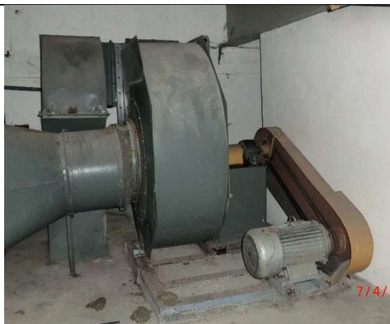
Fot. – 63 (Poziom -2.50) – pomieszczenie wentylatorowni i AKPiA – nieczynne kanały wentylacyjne – do demontażu i utylizacji.
