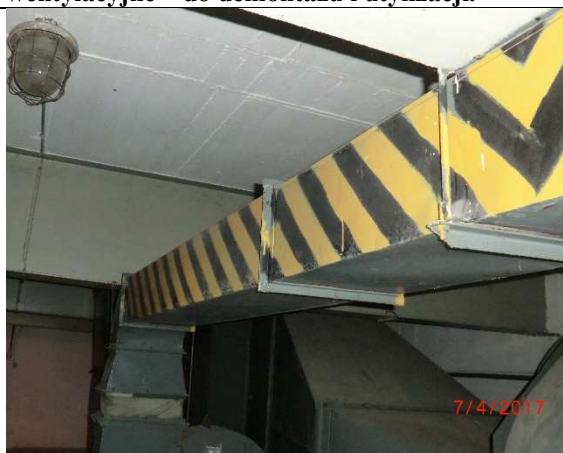
Fot. – 65 (Poziom -2.50) – pomieszczenie wentylatorowni i AKPiA – nieczynne kanały wentylacyjne – do demontażu i utylizacji.
