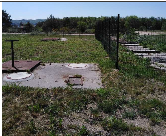
Fot. 3 (Teren) – przykrycie komory nieczynnej kanalizacji sanitarnej.
