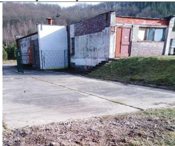
Fot. 4 (Teren) – wejście do budynku F-13.
