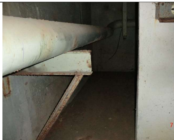
Fot. – 96 (Poziom -6.10) – nieczynny rurociąg tłoczny ścieków sanitarnych.
