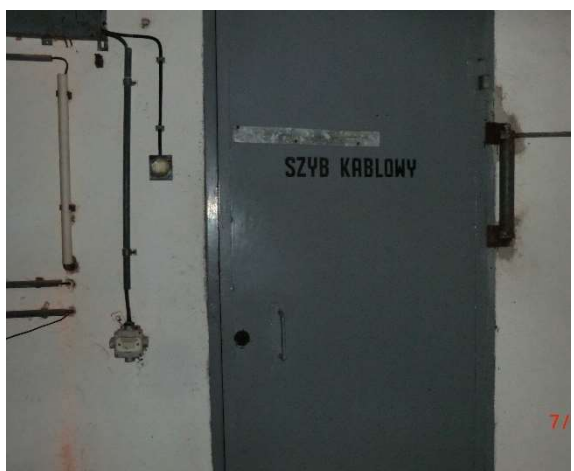
Fot. – 59 (Poziom -2.50) – drzwi do pomieszczenia szybu kablowego.
