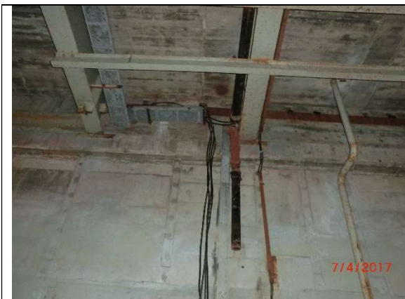
Fot. – 109 (Poziom -12.10) – nieczynna hala pomp Istn. nieużytkowane kable – do demontażu i utylizacji.
