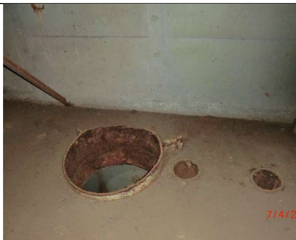
Fot. – 95 (Poziom -6.10) – otwory w stropie do zabezpieczenia.
