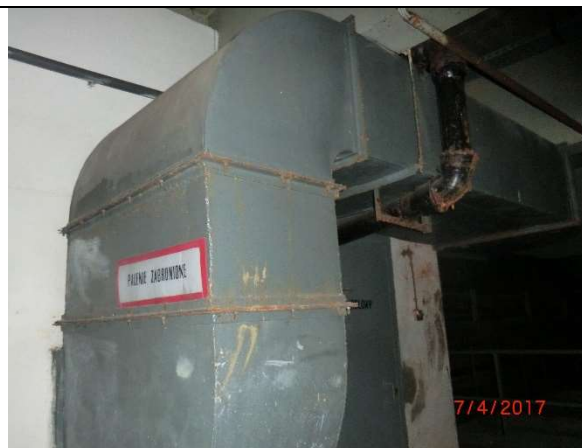
Fot. – 92 (Poziom -6.10) – kanał nieczynnej wentylacji.
