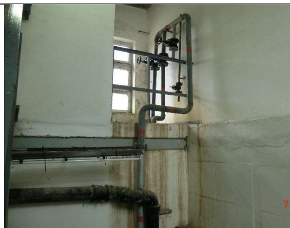
Fot. – 53 (Poziom +1.10) – klatka schodowa – ściany do pomalowania, rurociągi odwodnienia.
