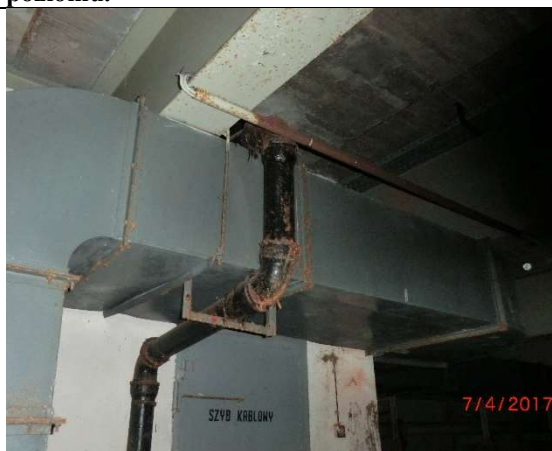
Fot. – 93 (Poziom -6.10) – kanał nieczynnej wentylacji.
