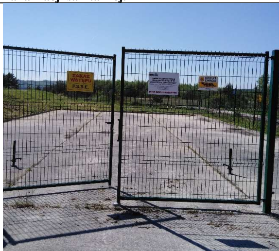
Fot. 5 (Teren) – brama wjazdowa na teren przepompowni.
