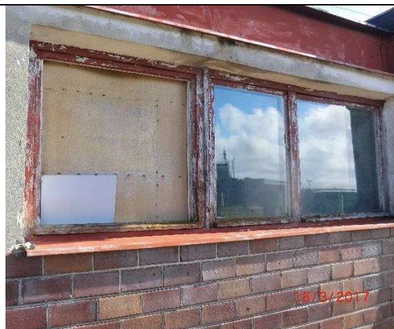
Fot. 38 – Okno do zamurowania luksferami.
