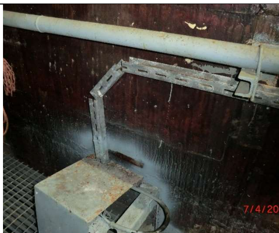
Fot. – 87 (Zbiorniki wody deszczowej) – istn. rurociągi wody i skrzynki.
