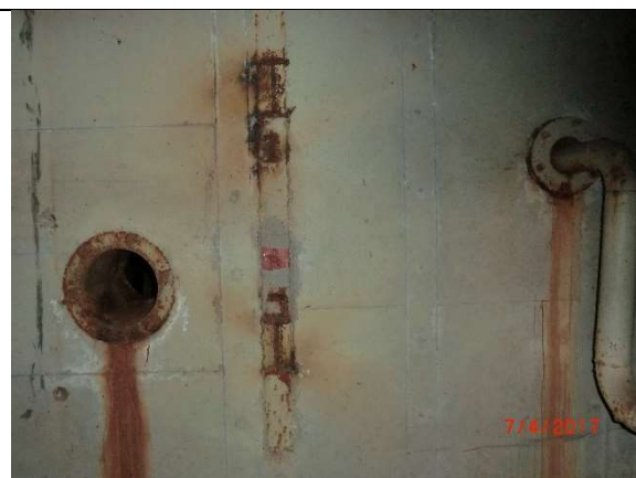
Fot. – 100 (Poziom -6.10) – otwory do zamurowania i trwałego zabezpieczenia.
