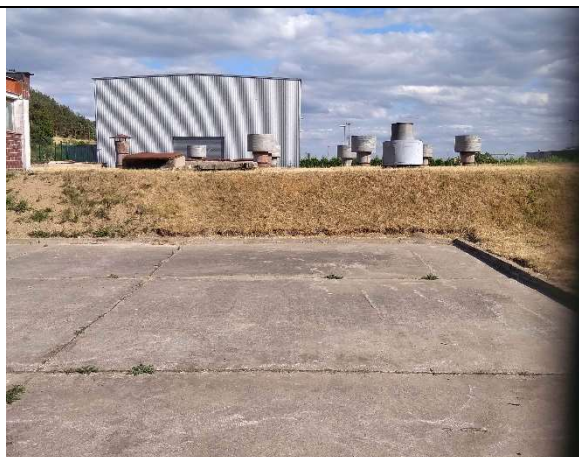
Fot. 19 – Widok na zbiornik od strony wjazdu i placu manewrowego na terenie przepompowni.
