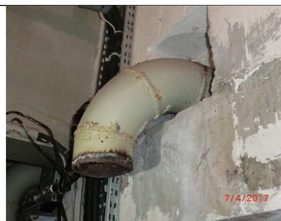
Fot. – 71 (Poziom -2.50) – Korytarz prowadzący do zbiorników – istn. rurociągi do demontażu; otwory do zamurowania.
