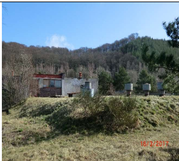
Fot. 1 (Teren) – widok na budynek F-13.
