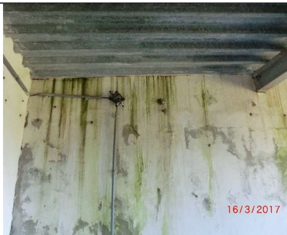
Fot. – 47 (Poziom +1.10) – pomieszczenie techniczne.
