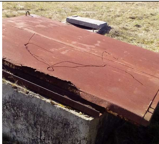
Fot. 26 – pokrywa luku montażowego – do konserwacji lub wymiany.
