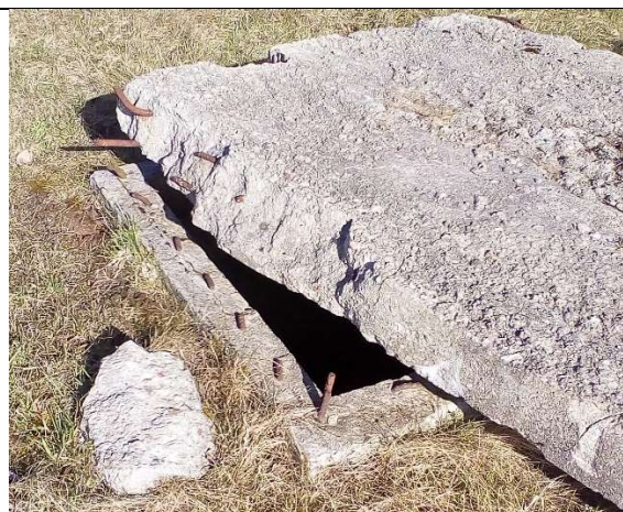
Fot. 24 – Luk montażowy na nieczynnym zbiorniku ścieków sanitarnych – do zabezpieczenia
