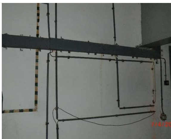
Fot. – 57 (Poziom -2.50) – demontaż zbędnych instalacji.
