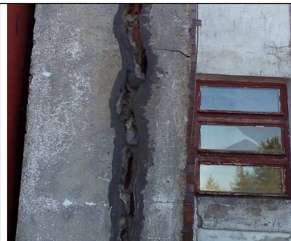
Fot. 37 – Okno do zamurowania luksferami.
