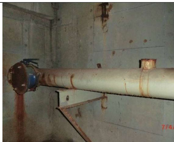
Fot. – 94 (Poziom -6.10) – nieczynny rurociąg tłoczny ścieków sanitarnych.
