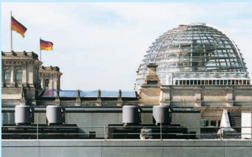
Wentylatory oddymiające dachowe Typ BVD 710/30-6 - F 400
