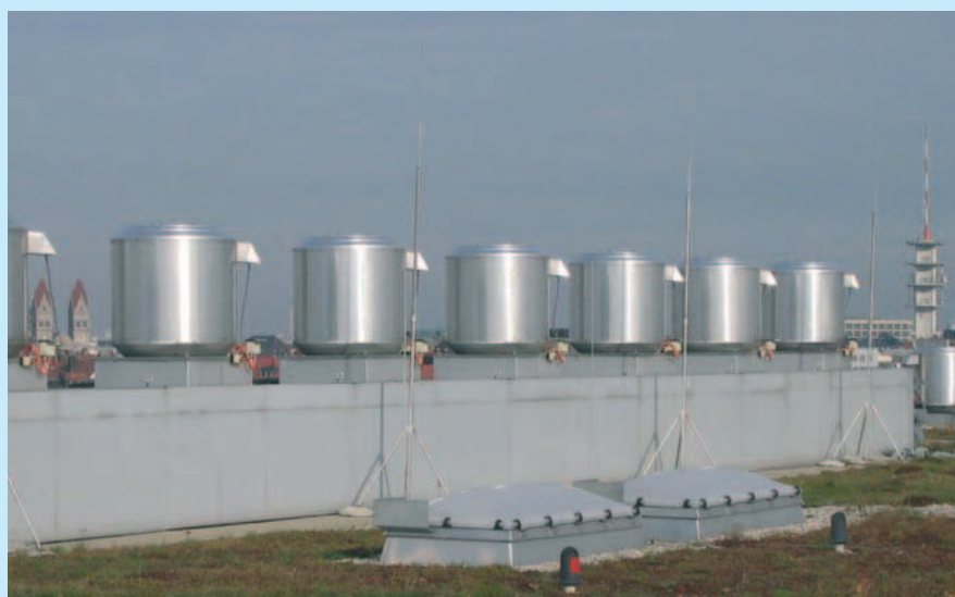
Wentylatory oddymiające dachowe BVD 710 - F600 (Daimler-Chrysler filia w Monachium)
