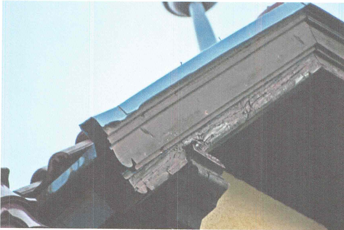
Różnica stanu zachowania między elementem zachowanym a uzupełnionym.
