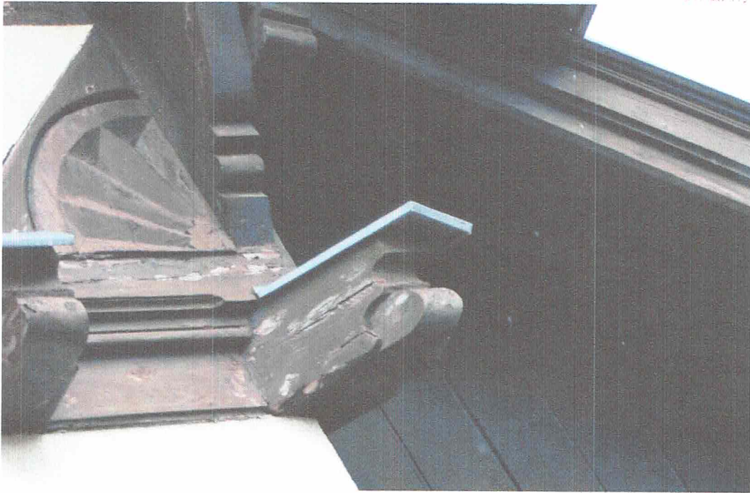
Fragment dekoracji elewacji frontowej
