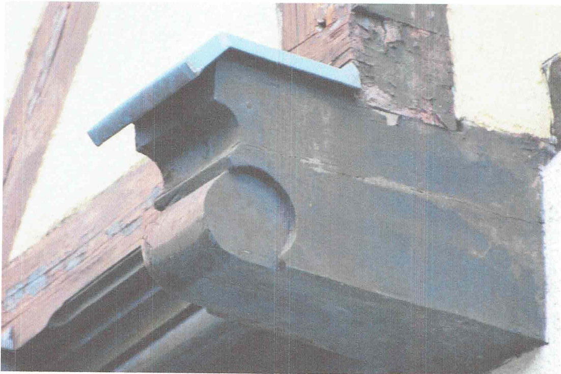
Połączenie rygla i zastrzału oraz konsolki
