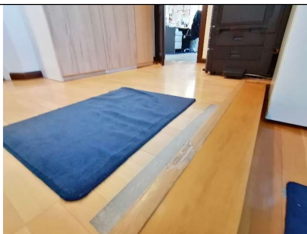
Fot.14 - naprawa progu (zakończenia schodów drewnianych)
