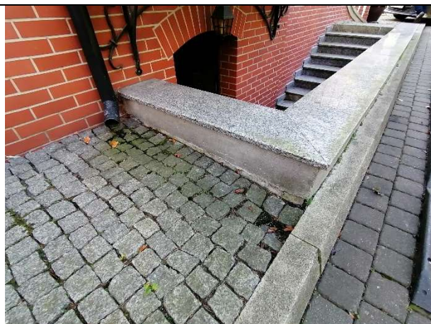
Fot.18 - demontaż i ponowny montaż nawierzchni z kostki w okolicach rynny spustowej z daszku nad wejściem do dolnej kondygnacji, w celu likwidacji zastoju deszczówki powstającej w zagłębieniu terenu podczas opadów deszczu
