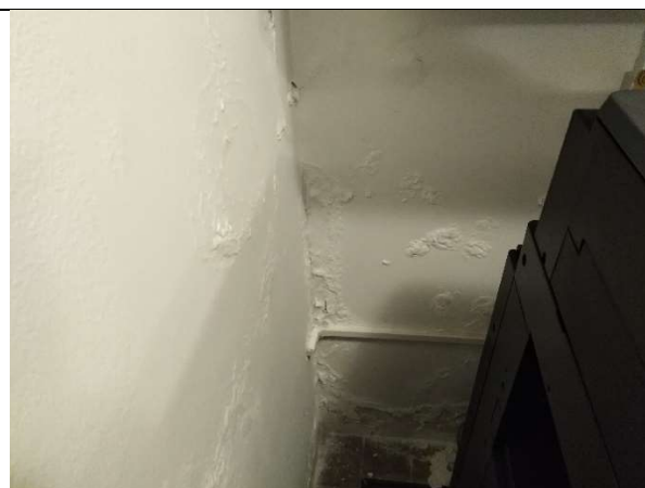
Fot.4 - zbitie i wymiana tynku zawilgoconej ściany (okolicie wejścia do budynku na poziomie piwnicy, przy ksero i pom. gospodarczym)
