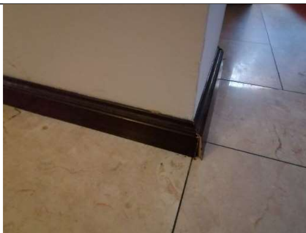
Fot.16 - montaż luźnych listew przypodłogowych + ewentualne uzupełnienia.
