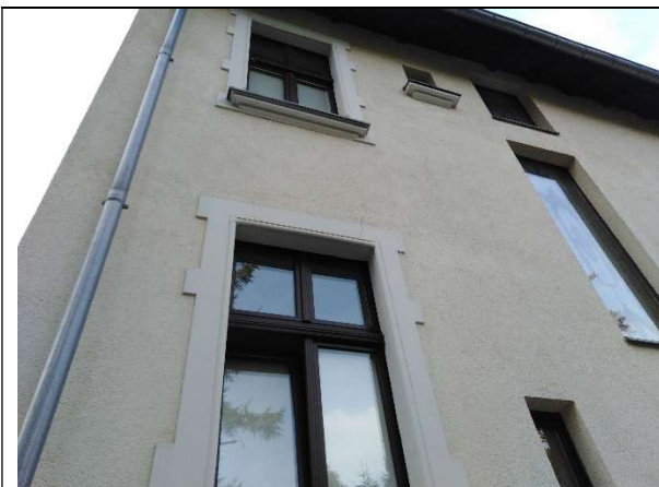
Fot.17 - sprawdzenie i udrożnienie rynien spustowych (zwłaszcza daszku nad wejściem do dolnej kondygnacji)
