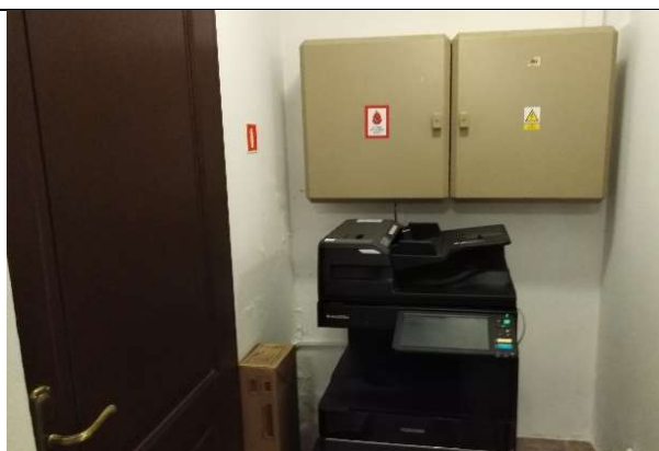
Fot.5 - przebudowa szafki elektrycznej z wyprowadzeniem przewodu do zasilania centrali sterującej klapami oddymiania
