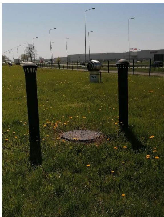
Fot. 4 – Widok na teren zbiornika od strony Północnej.
