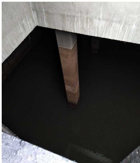
Fot. 8 – Widok na wnętrze zbiornika (stały minimalny poziom wody w zbiorniku).
