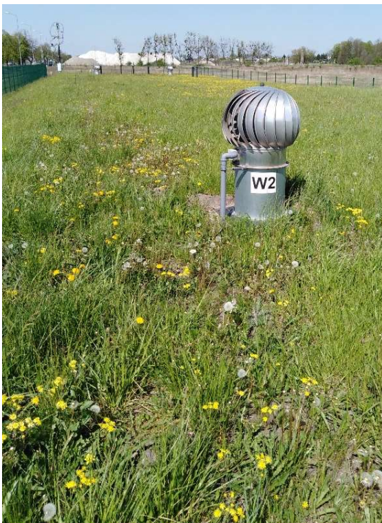
Fot. 3 – Widok na teren zbiornika od strony południowej (zbiornik podziemny).
