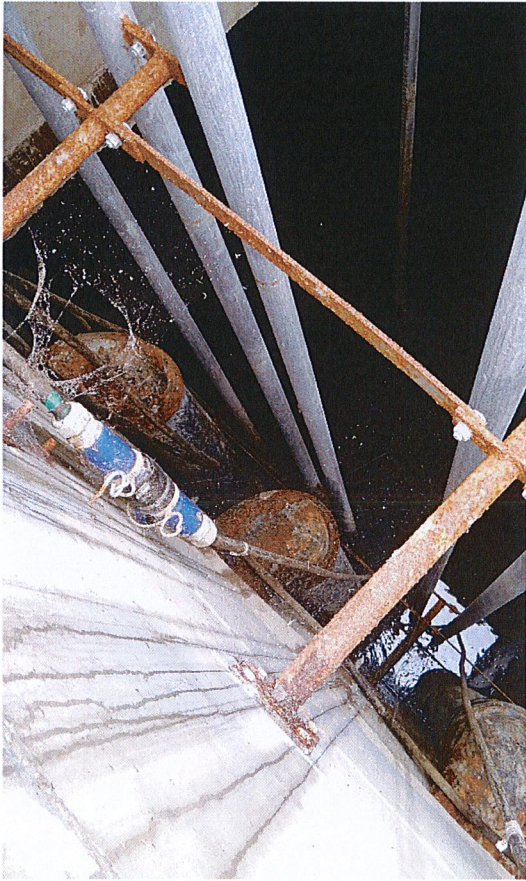
Widok na pompownie przez otwór szybu
