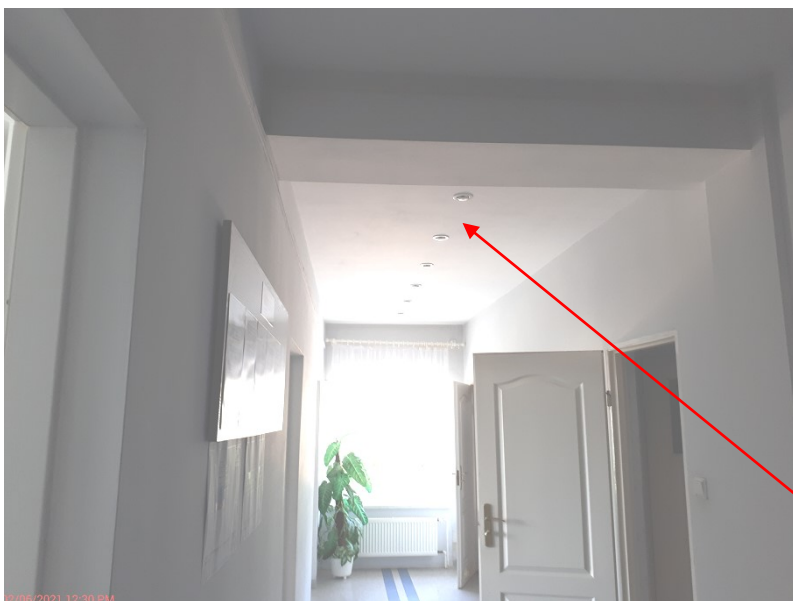
wymienione drzwi, grzejnik itd. cz.B III kondygnacja
