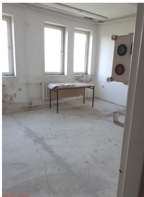
pokój w części murowanej „A” III kondygnacja
