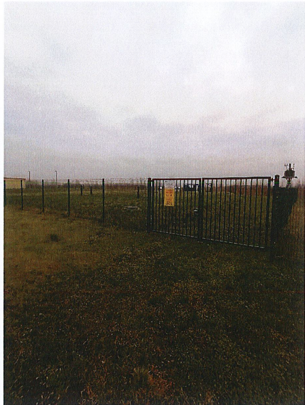
Fot.2 – Brama wjazdowa – teren do utwardzenia.
