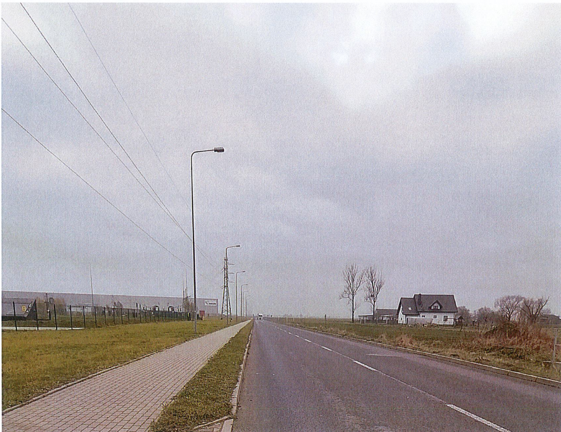
Fot.3 – Chodnik i jezdnia w rejonie planowanego utwardzenia terenu.
