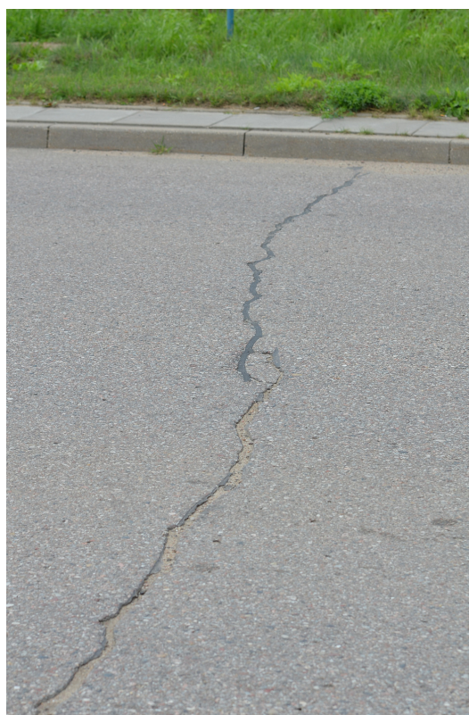
Fot. 10. Próba uszczelnienia spękania poprzecznego masą zalewową. Pomimo przeprowadzenia niniejszego zabiegu spękanie znacznie zwiększyło swoją szerokość.
