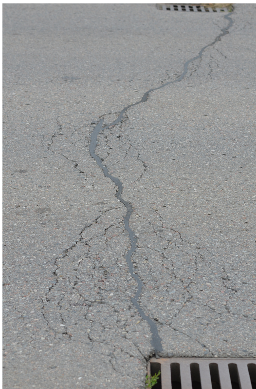
Fot. 3. Spękanie poprzeczne o mocno zdegradowanych brzegach, mimo uszczelnienia masą zalewową.
