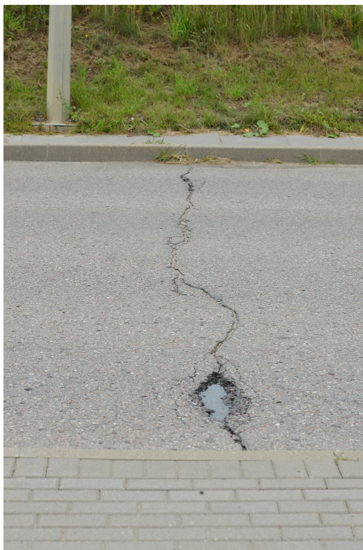
Fot. 5. Bardzo szerokie (szerokość ok. 3-4 cm) spękanie poprzeczne wraz ze znaczącym ubytkiem warstwy ścieralnej.
