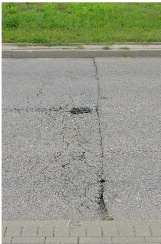
Fot. 8. Rozległe uszkodzenia nawierzchni po lewej stronie zdjęcia wynikające z błędnego odtworzenia nawierzchni po pracach przy budowie sieci podziemnych.
