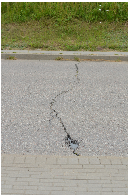
Fot. 4. Bardzo szerokie (szerokość ok. 3-4 cm) spękanie poprzeczne wraz z ubytkiem warstwy ścieralnej.
