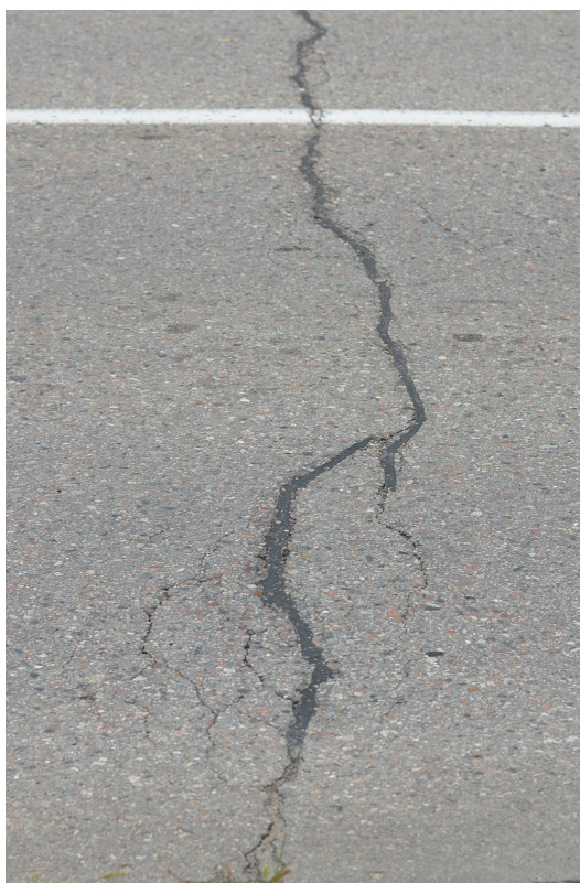
Fot. 2. Widoczne próby uszczelnienia spękania poprzecznego poprzez zalanie masą zalewową, proces degradacji brzegów szczeliny postępuję jednak dalej.
