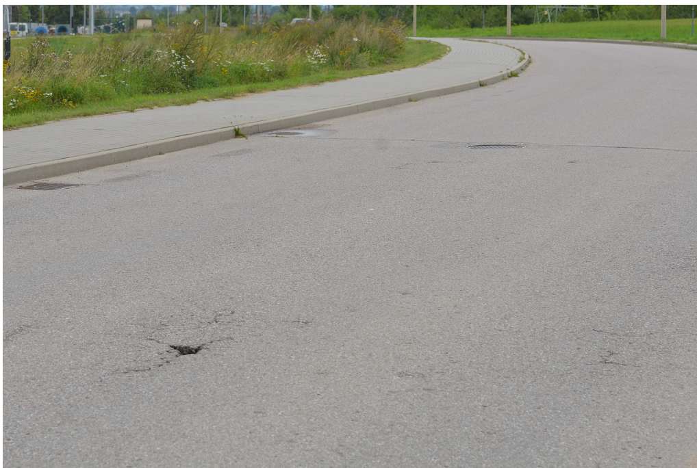
Fot. 9. Uszkodzenia powierzchniowe (wykruszenie warstwy ścieralnej, spękania blokowe) wynikające najprawdopodobniej z procesów starzenia.
