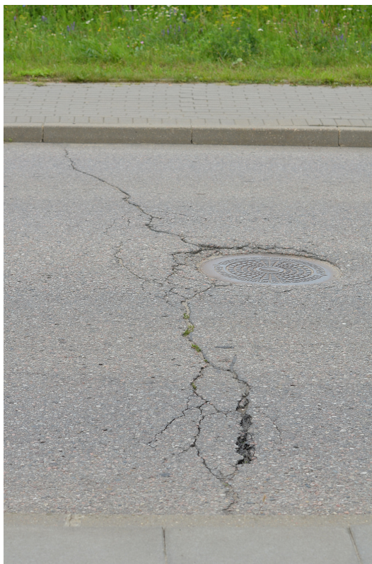
Fot. 7. Bardzo szerokie (szerokość ok. 3-4 cm) spękanie poprzeczne wraz ze znaczącym ubytkiem warstwy ścieralnej, zainicjowane najprawdopodobniej przez właz studni kanalizacji. Widoczna jest mocna degradacja brzegów spękania.
