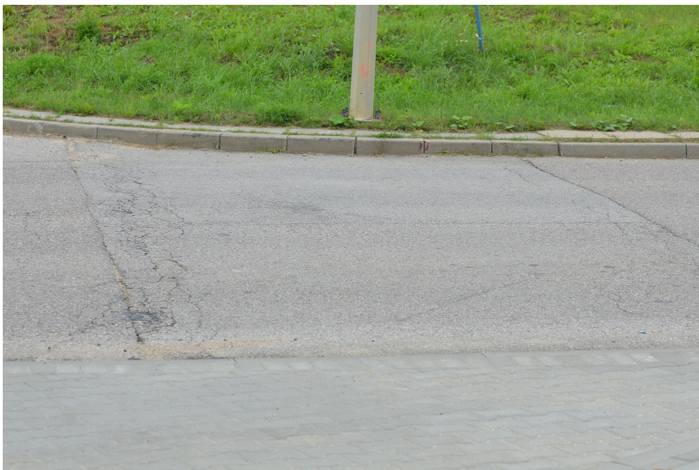
Fot. 11. Rozległe uszkodzenie wynikające z błędnego odtworzenia nawierzchni po pracach przy budowie sieci podziemnych.
