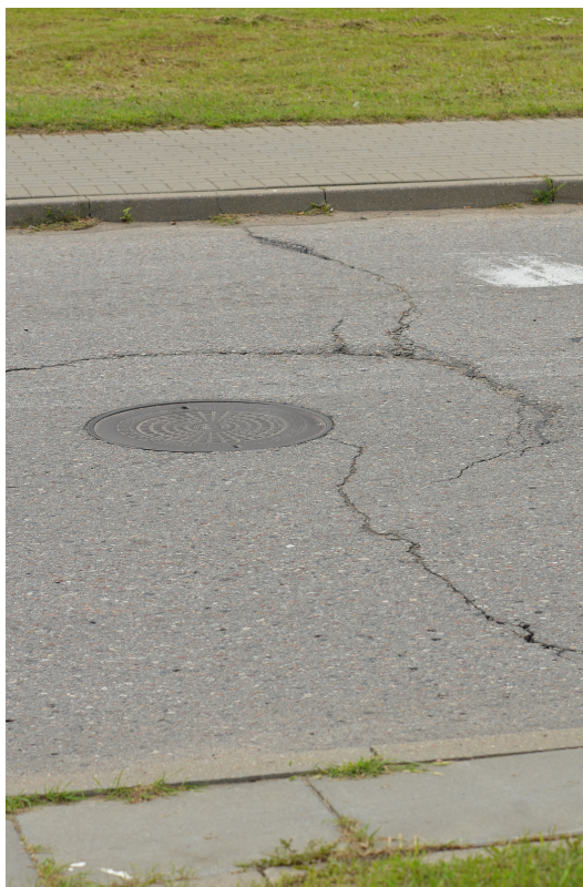
Fot. 1. Spękanie poprzeczne z zaawansowaną degradacją występujące w sąsiedztwie wjazdu kanalizacji.
