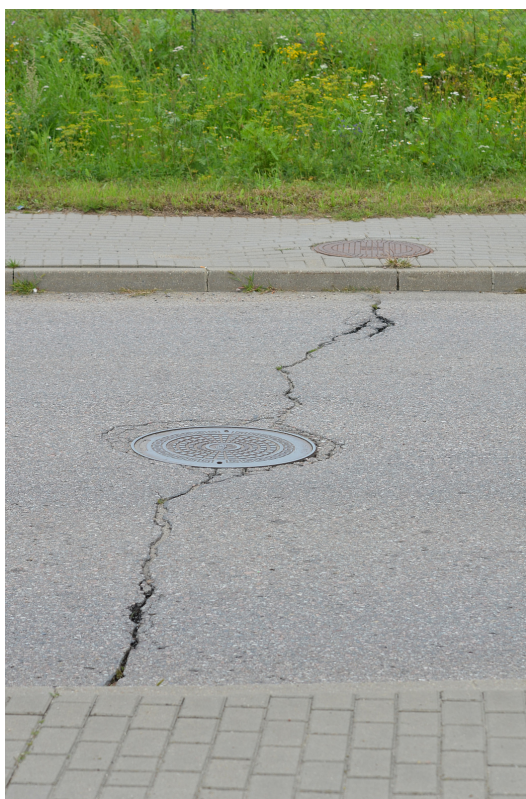
Fot. 6. Bardzo szerokie (szerokość ok. 3-4 cm) spękanie poprzeczne wraz ze znaczącymi ubytkami warstwy ścieralnej w sąsiedztwie studni kanalizacji deszczowej.
