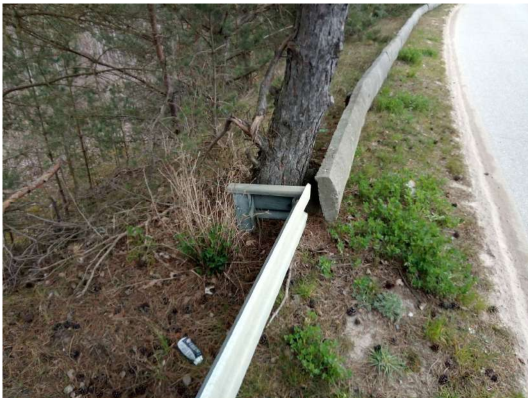
Fot. 9. Inne miejsce styku bariery żelbetowej z barierą stalową stwarzający istotne zagrożenie w przypadku najeżdżania pojazdu na barierę.
