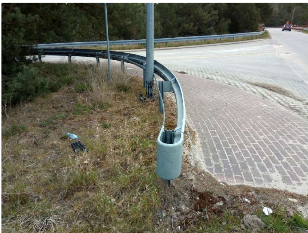
Fot. 17. Bariery stalowe i ich zakończenie na wlocie skrzyżowania ulicy Okrężnej z ulicą Spokojną.
