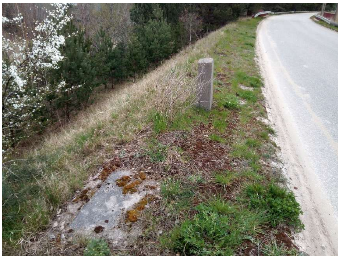
Fot. 23. Elementy infrastruktury telekomunikacyjnej po prawej stronie ulicy Spokojnej.
