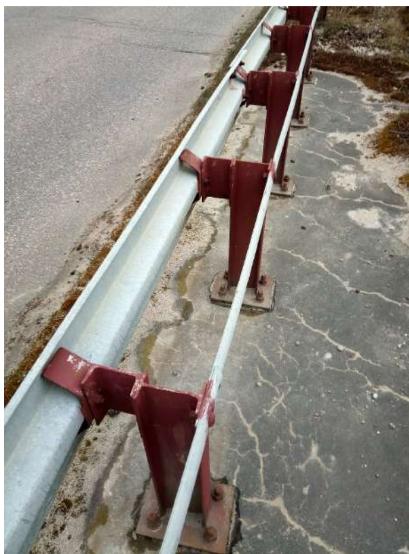
Fot. 12. Zbliżenie na słupki bariery stalowej na obiekcie WD-2. Widoczna jest uszkodzona powłoka malarska słupków, przekładek i wsporników.
