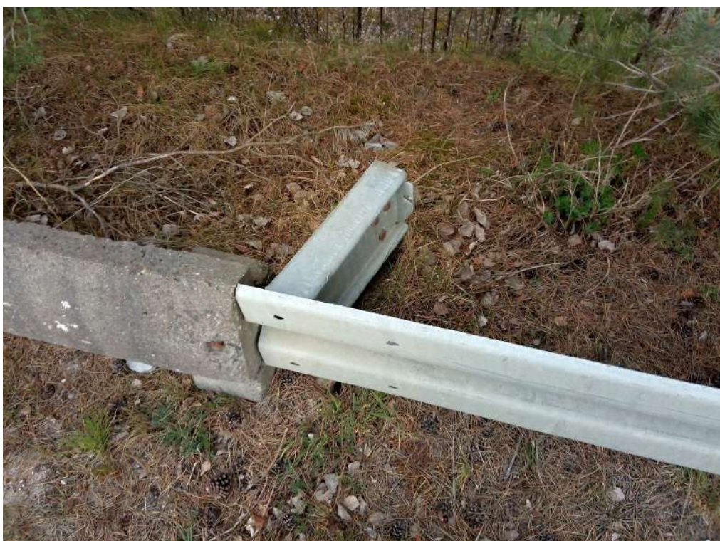
Fot. 7. Zdjęcie obrazujące stan istniejących barier żelbetowych. Widoczne są liczne załamania i odkształcenia linii barier.
