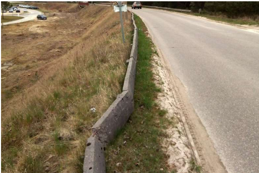
Fot. 7. Zdjęcie obrazujące stan istniejących barier żelbetowych. Widoczne są liczne załamania i odkształcenia linii barier.
