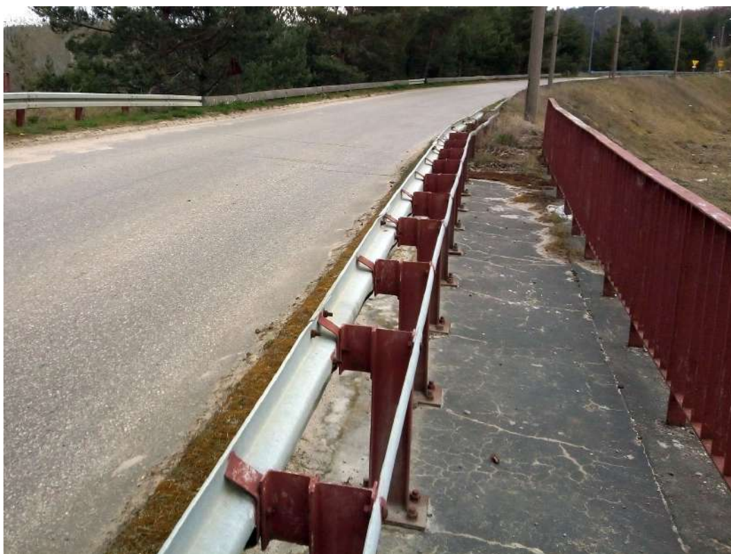
Fot. 11. Widok ogólny barier stalowych na obiekcie WD-2.
