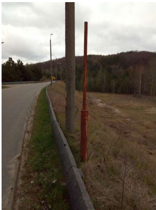
Fot. 22. Przewidziane do demontażu słupy oświetleniowe po lewej stronie ulicy Spokojnej.
