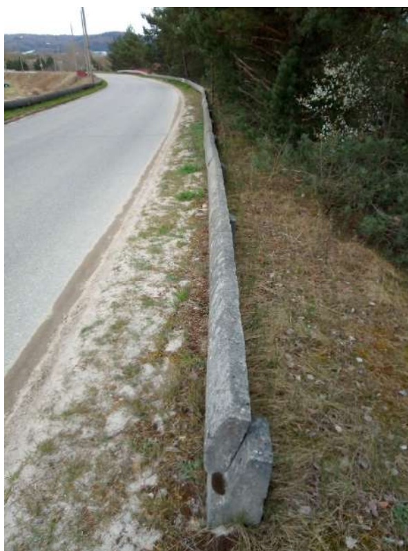
Fot. 9. Inne miejsce styku bariery żelbetowej z barierą stalową stwarzający istotne zagrożenie w przypadku najeżdżania pojazdu na barierę.
