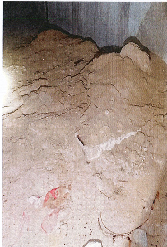
Fot.6 Kanał „A”
