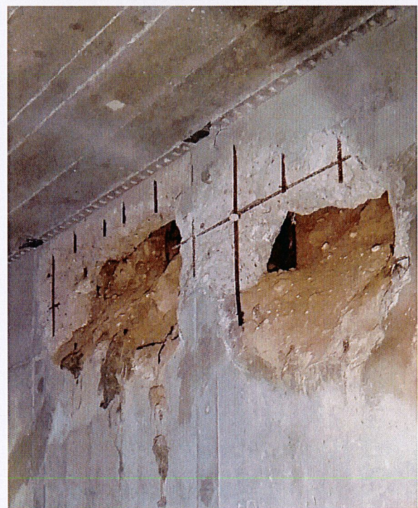
Fot.12 Kanał „A”
