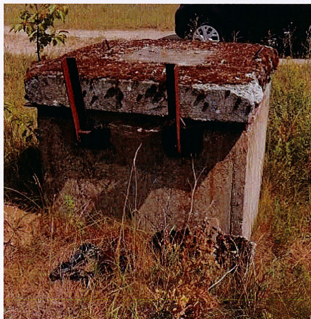
Fot.27 Kanał „B”
