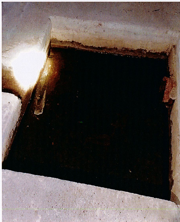
Fot.11 Kanał „A”
