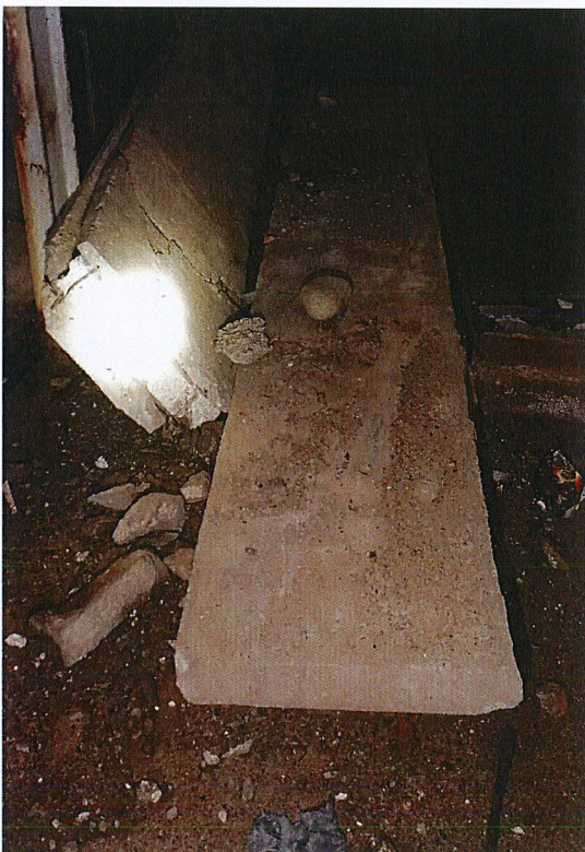
Fot.7 Kanał „A”
