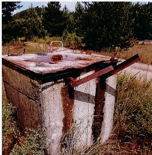
Fot.26 Kanał „B”
