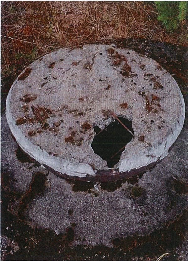
Fot.29 Kanał „B”
