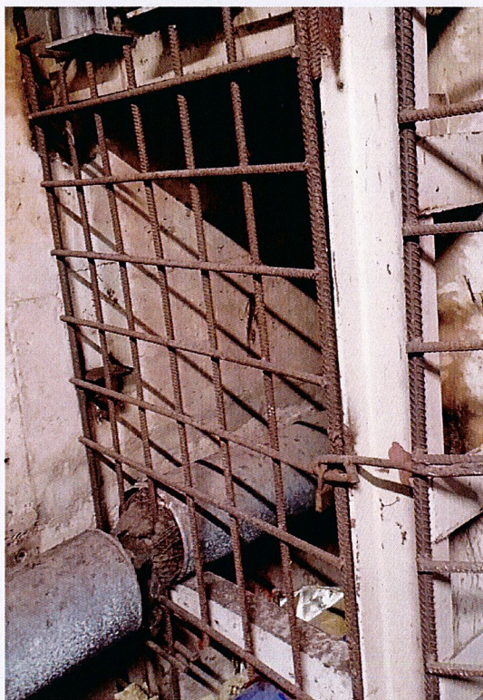
Fot.1 Kanał „A”
