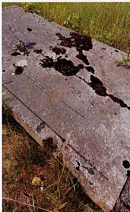
Fot.20 Kanał „A”
