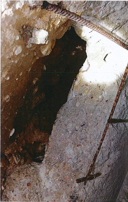
Fot.13 Kanał „A”
