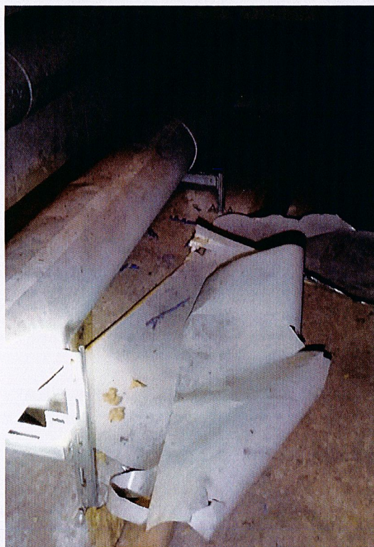
Fot.2 Kanał „A”
