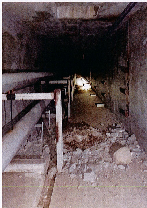
Fot.4 Kanał „A”
