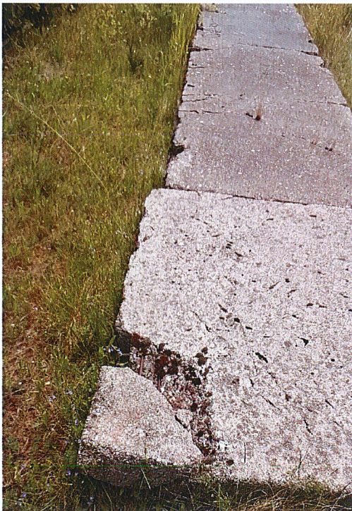
Fot.23 Kanał „A”
