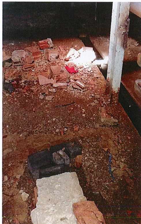
Fot.8 Kanał „A”
