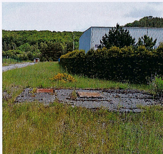
Fot.18 Kanał „A”
