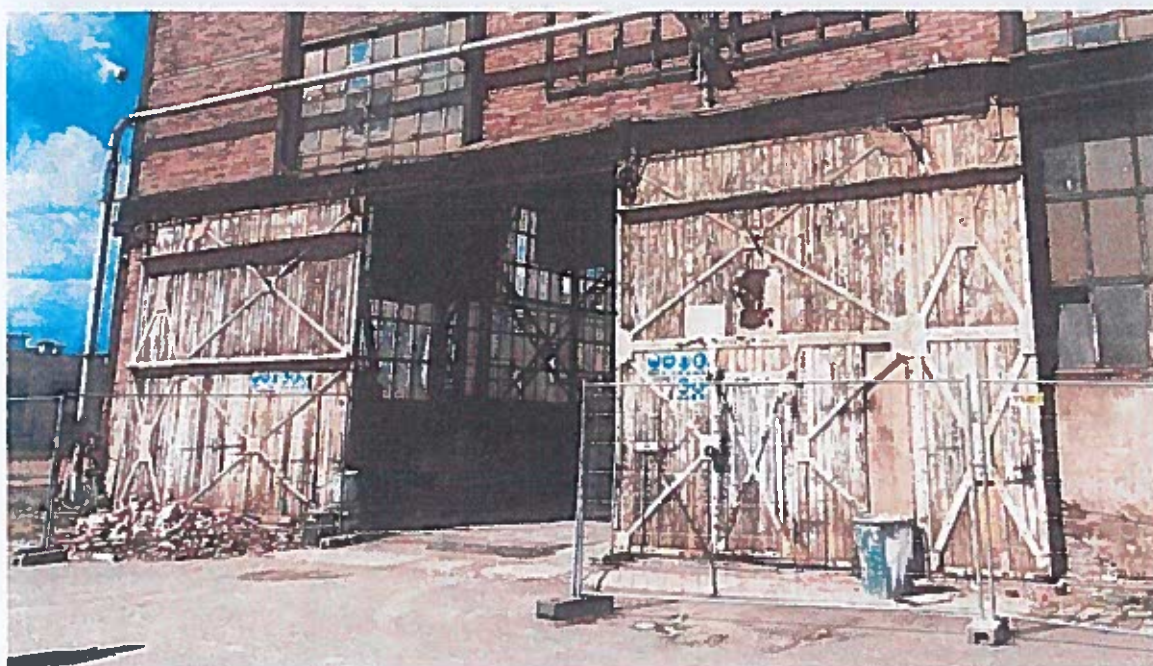
Uszkodzenia wrót
