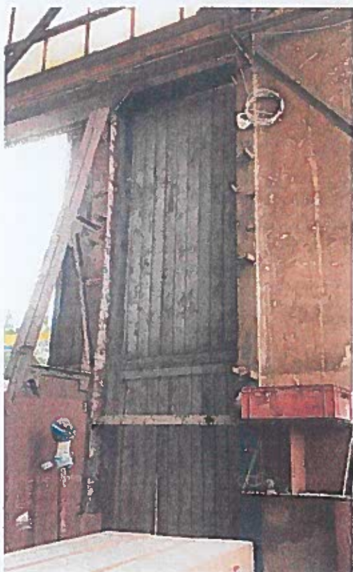
otwór po wyburzeniu ściany przy wrotach
