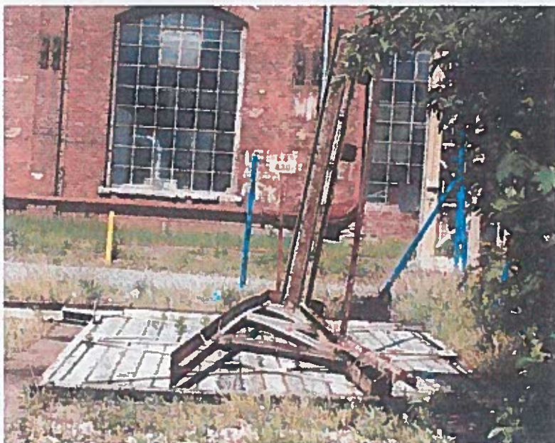
Zdemontowane skrzydło bramy oraz konstrukcja stalowa ściany
