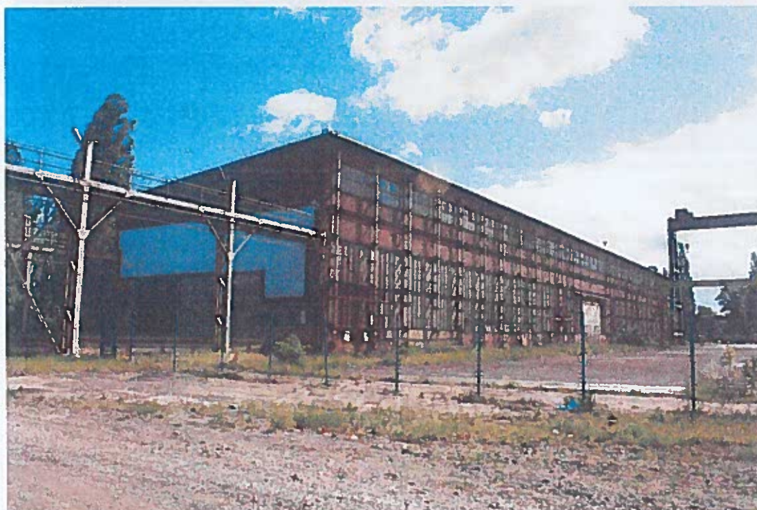
Widok od strony południowo zachodniej
