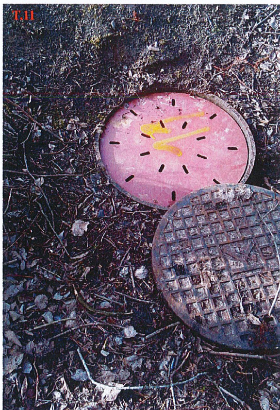
Foto. 20 Studnia T.11 - widok z zewnątrz
