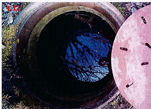
Foto. 23 Studnia T.12 - widok wnętrza obudowy
