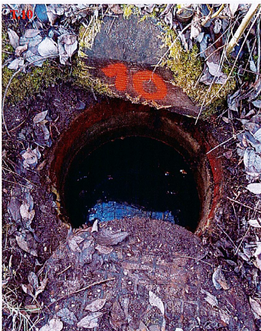
Foto. 18 Studnia T.10 - widok z zewnątrz
