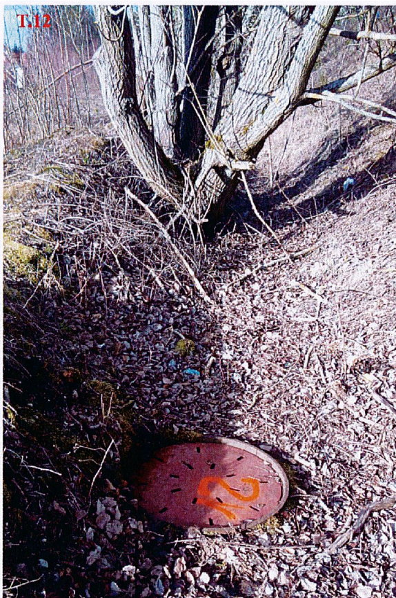
Foto. 22 Studnia T.12 - widok z zewnątrz
