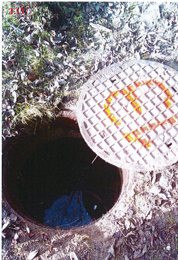
Foto. 24 Studnia T.13 - widok z zewnątrz
