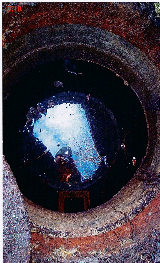
Foto. 19 Studnia T.10 - widok wnętrza obudowy
