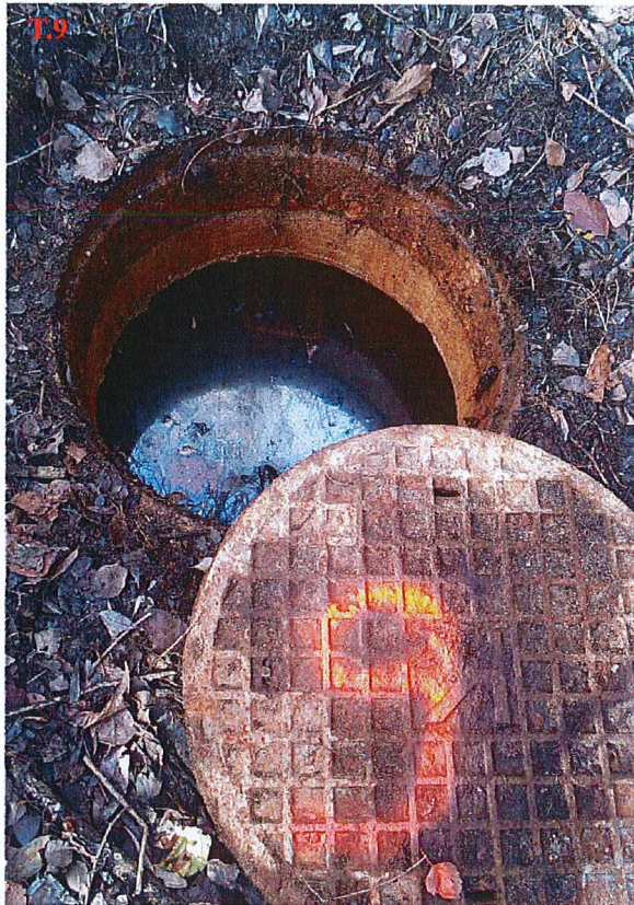
Foto. 17 Studnia T.9 - widok z zewnątrz
