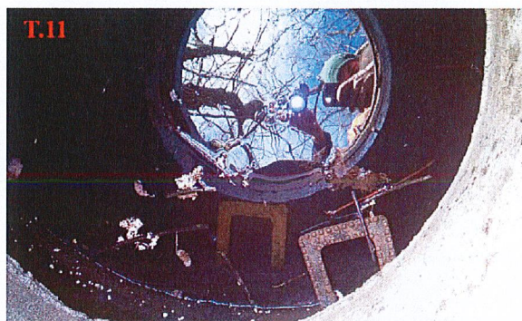
Foto. 21 Studnia T.11 - widok wnętrza obudowy
