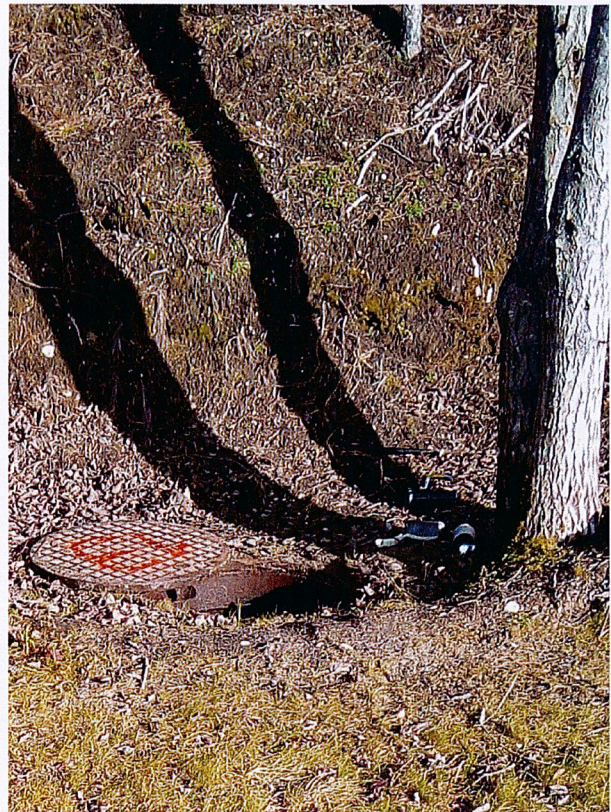
Fot.6 – Studzienka nr T.13
