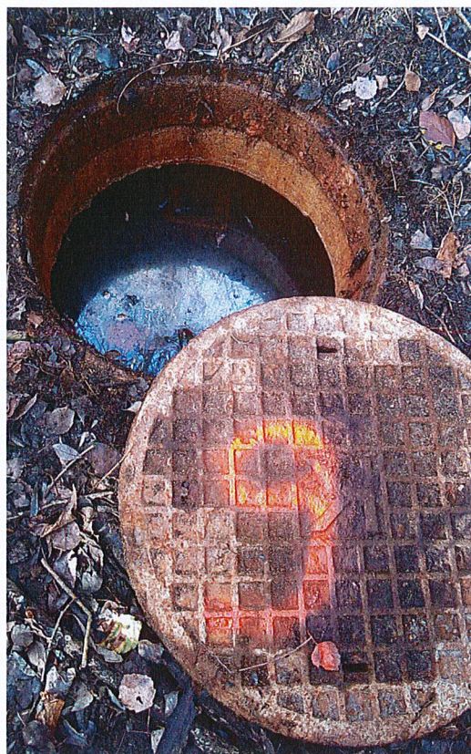
Fot.2 – Studzienka nr T.9
