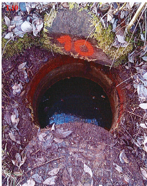
Fot.3 – Studzienka nr T.10
