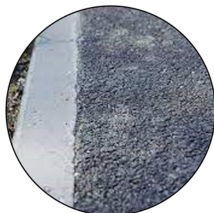
Nawierzchnia bitumiczna na podbudowie z kruszywa + krawężniki betonowe
